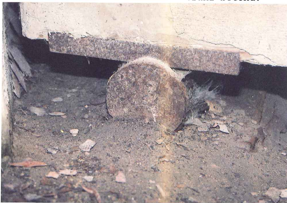
Obr.887-27 Pohyblivé ložisko pod 6. trámem na I. opěře. Pohled zprava proti vodě,
