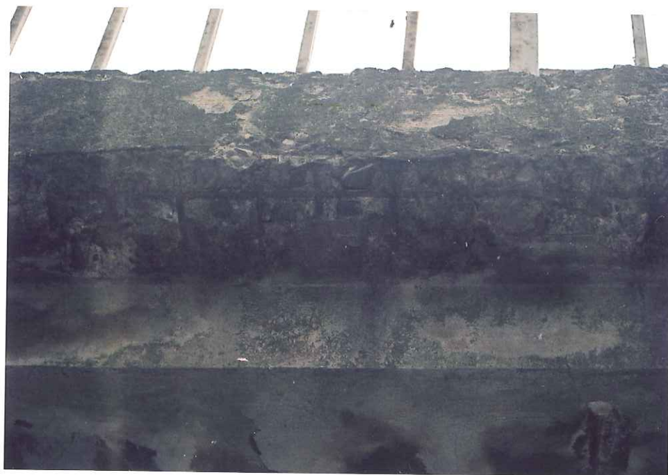
Obr.887-28 Návodní římsa za polovinou rozpětí. Pohled od pa- ty levobřežního svahu koryta po vodě a vzhůru, - opadaná omítka, zvětralý beton, olámaný okapový nos a ob- nažená a korodovaná výztuž.
