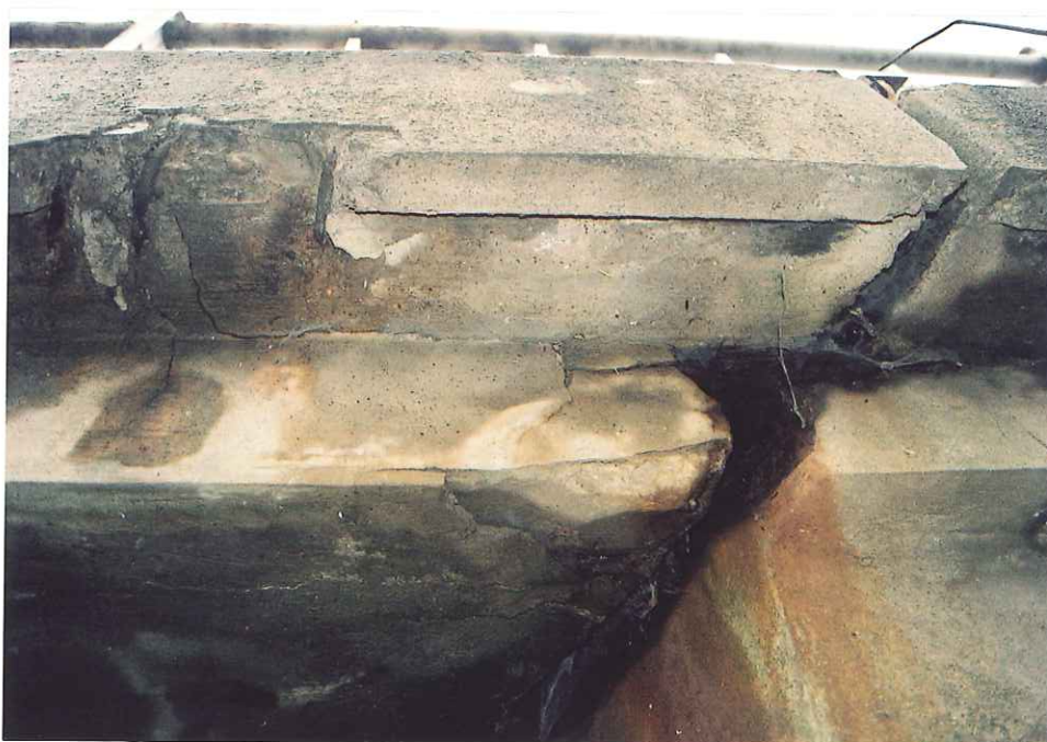
Obr.887-25 Původní římsa nad II. podpěrou. Pohled zprava do- leva (proti vodě) a vzhůru, - římsa a konzola mostovkové desky spojené monoliticky jsou oddělené trhlinou. Důvodem je chybná realizace dilatační spáry. Deska spolu s trámy je uložena na UP pomocí ložisek, římsa přesahuje nad závěrnou zeď, kde není zajištěna mož- nost dilatace. Při dilatačních pohybech je římsa odtrhává- na od desky vodorovnou a sama poškozována svislou trhli- nou, přestože se konstrukce nachází nad pevným uložením, - na římsce opadaná omítka i s betonem, olámaný okapový nos a obnažená a korodovaná výztuž. V dilatační spáře koro- zivní zabarvení.
