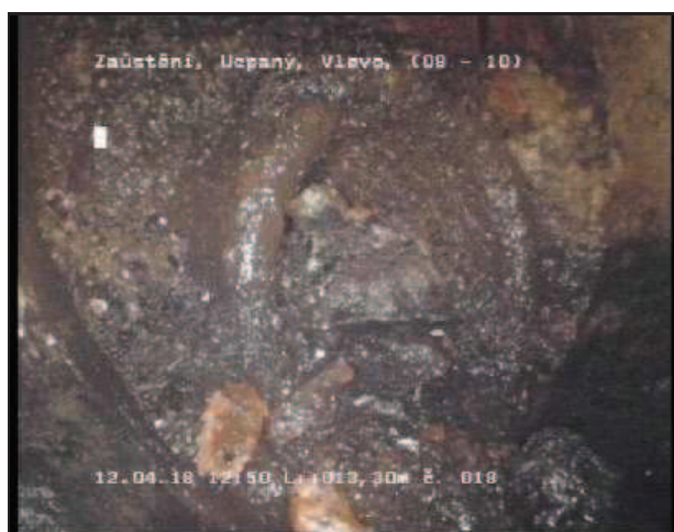
Foto 018 Videopáska: 1/2 Stav S-DL 13,30 m 8 - 10 Uhr Zaústění, Ucpaný, Vlevo
