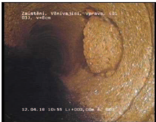
Foto 003 Videopáska: 1/1 Stav SE-R 3,00 m 1 - 3 Uhr Zaústění, Včnívající, Vpravo, Včnívající = 8cm
