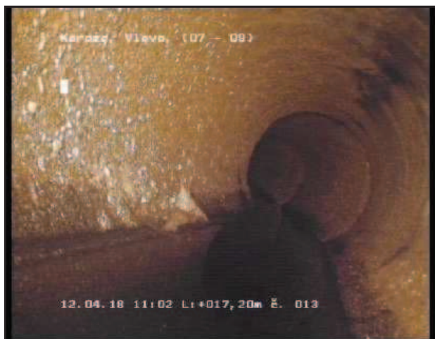
Foto 013 Videopáska: 1/1 Stav C--L 17,20 m 7 - 8 Uhr Koroze, Vlevo
