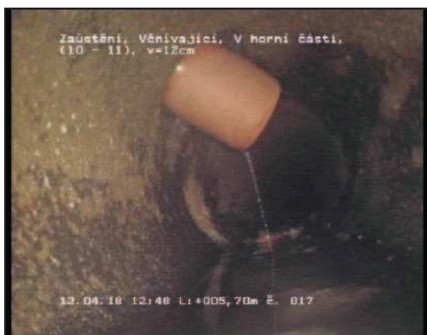
Foto 017 Videopáska: 1/2 Stav SE-O 5,70 m 10 - 11 Uhr Zaústění, Včnávající, V horní části, Včnávající = 12cm
