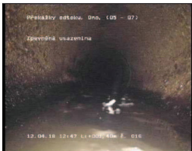
Foto 016 Videopáska: 1/2 Stav H--U 1,40 m 5 - 7 Uhr Překážky odtoku, Dno; Zpevněná usazenina
