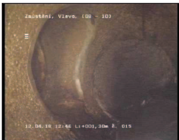
Foto 015 Videopáska: 1/2 Stav S--L 1,30 m 8 - 10 Uhr Zaústění, Vlevo
