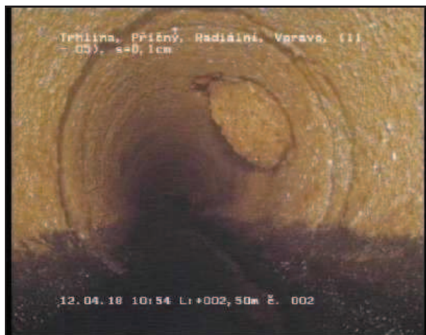
Foto 002 Videopáska: 1/1 Stav RQ-R 2,50 m 11 - 5 Uhr Trhlina, Příčný, Radiální, Vpravo, Šířka trhliny = 0,10cm
