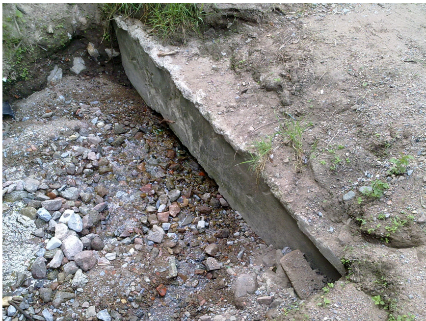
Foto č.10 - Podhled na zanesený propustek na potoku Skok, pod polní cestou.
