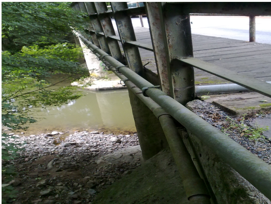
Foto č.7 - Podhled na inženýrské sítě, umístěné na povodní straně mostu.
