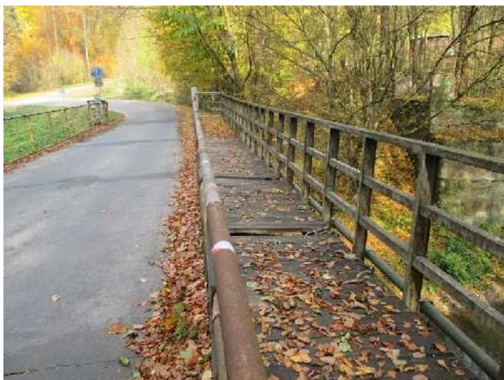
Zdevastovaný chodník, rezivějící zábradlí a zanesená krajnice.
