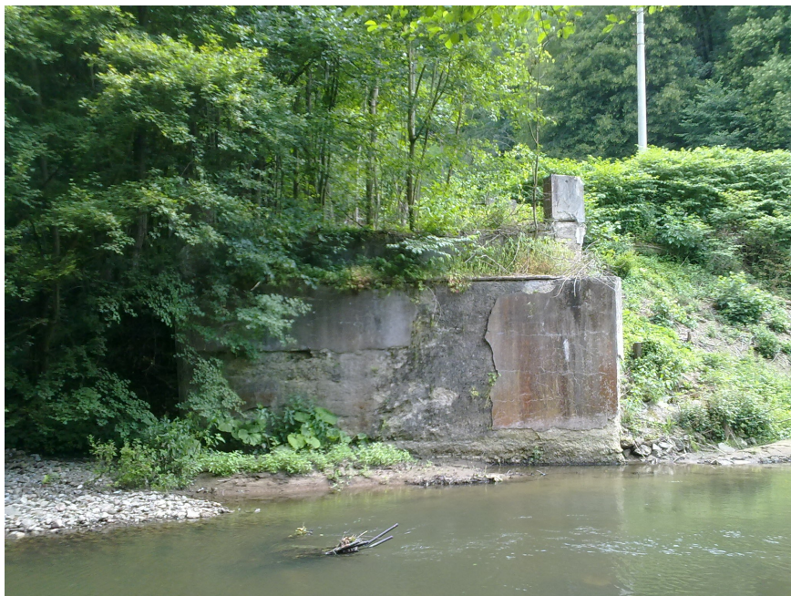
Foto č.9 - Podhled na mostní opěru původního mostu.
