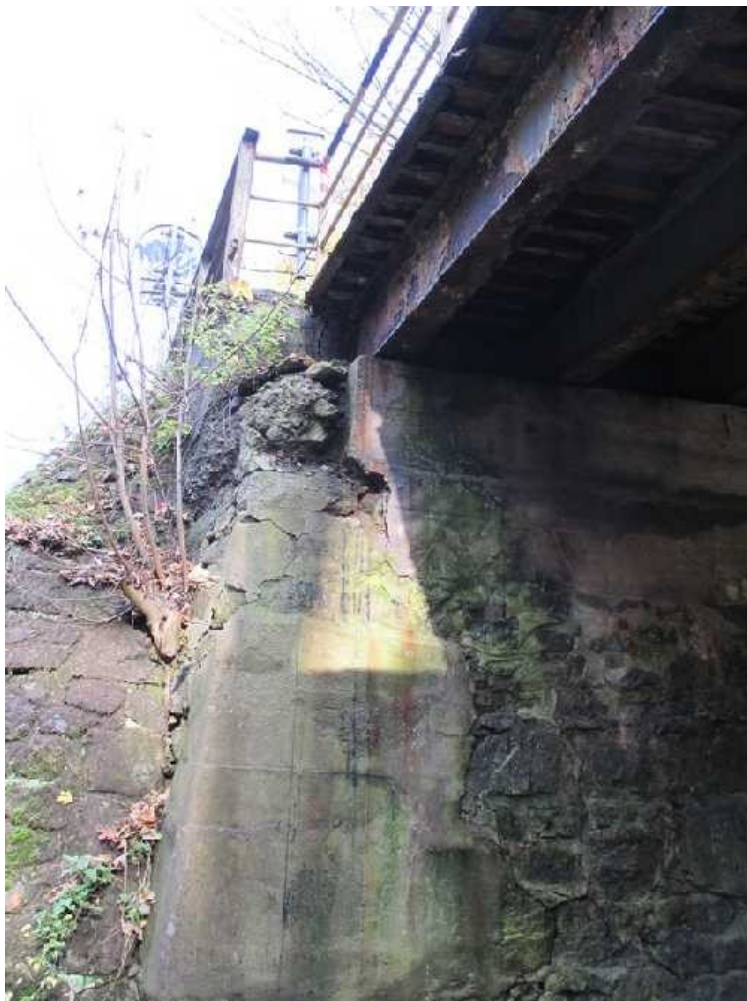
Nebezpečně rozpadlá opěra pod krajním nosníkem z návodní strany.
