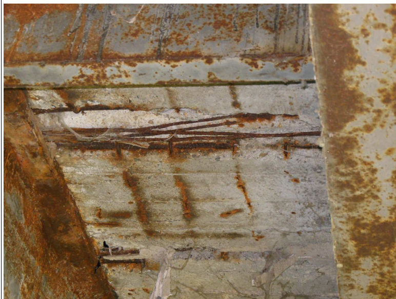
Rozpad prefabrikátů mostovky
