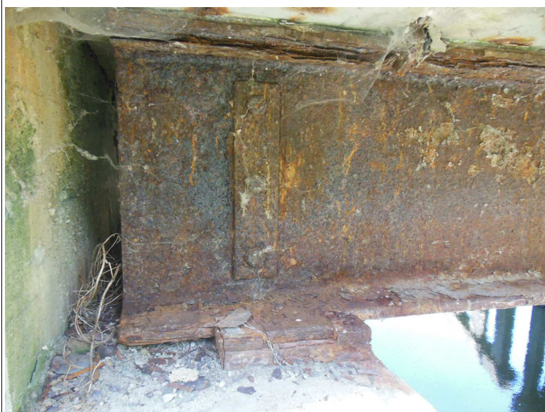
Koroze ocelového nosníku NK
