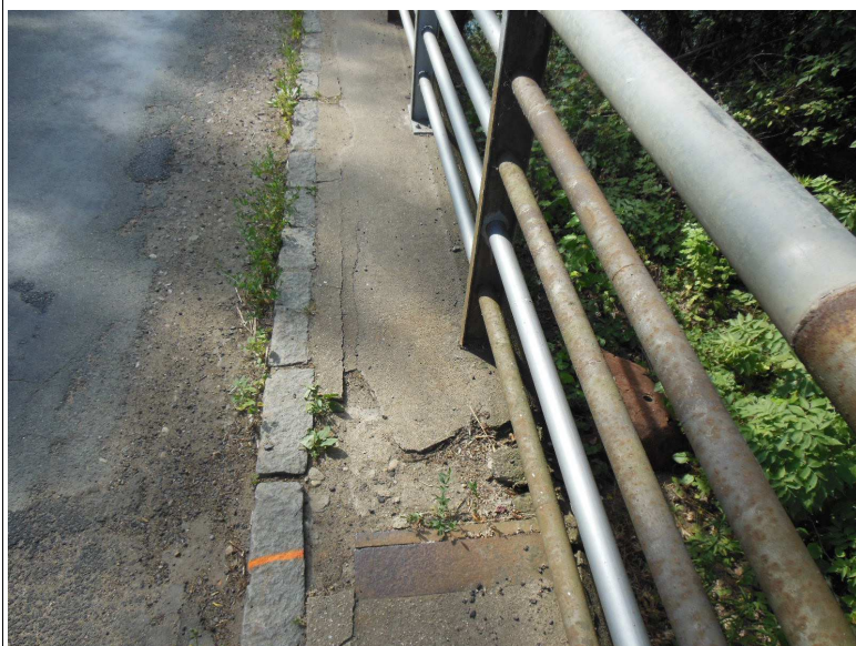
Rozpad římsy
