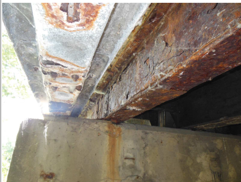
Koroze ocelového nosníku NK
