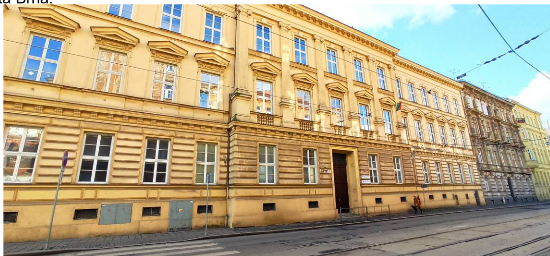
stávající uliční pohled
