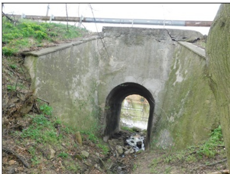
Most zprava, pravá římsa roztržená
