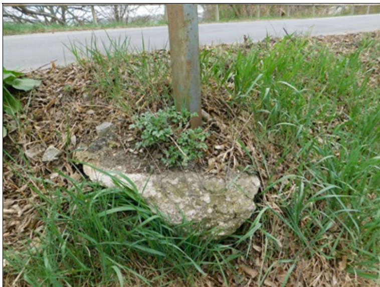
základová patka sloupku levého svodidla před mostem
