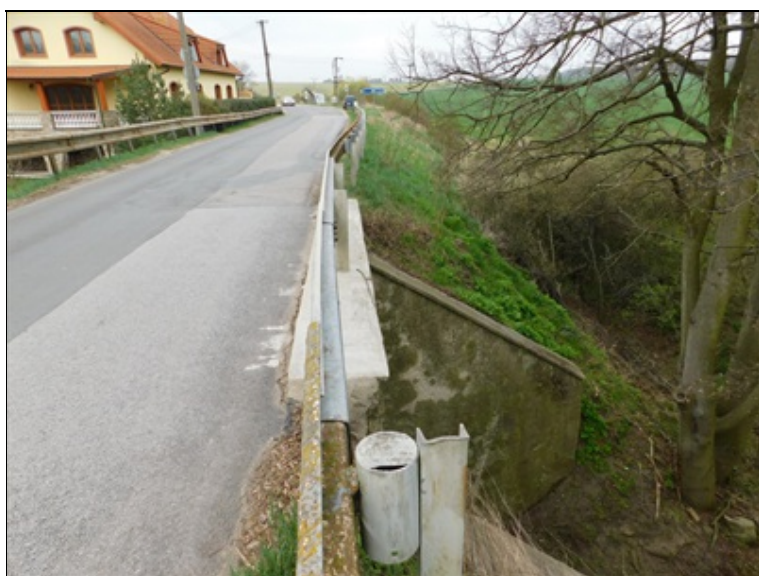
Svodidlo na mostě vpravo - chybí deformační válce
