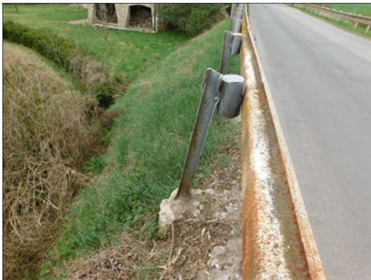
Sloupek svodidla za mostem vlevo - sloupek deformovaný, základová patka ujíždí po svahu
