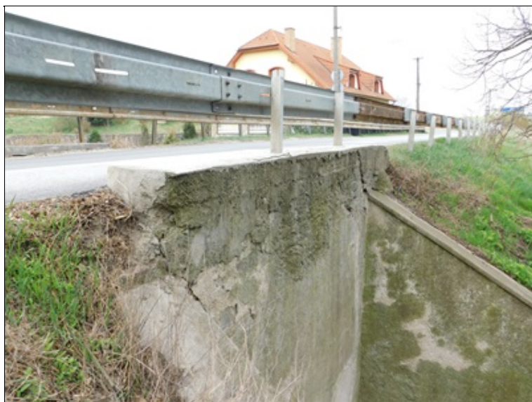
římsa vpravo - povrchová degradace betonu
