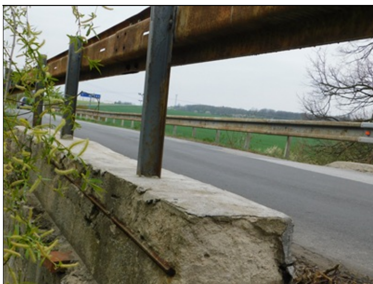
římsa vlevo - koroze betonu - povrchová vrstva odpadlá, plošná povrchová koroze ocelového svodidla
