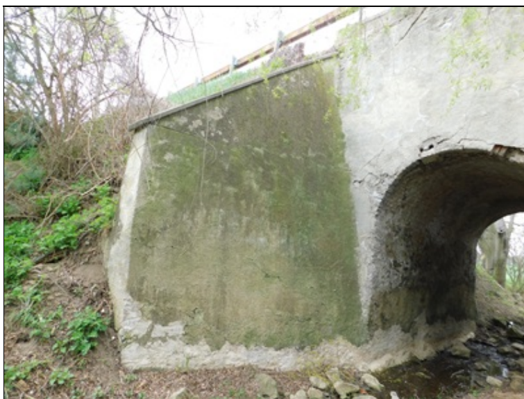
Křídlo O2L - výskyt trhlin
