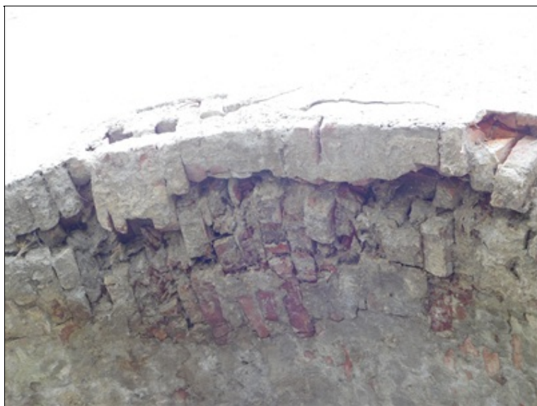
Rozpad klenby při levém kraji - kraj klenby je odtržen, vznik kaveren, postupné odpadávání cihel
