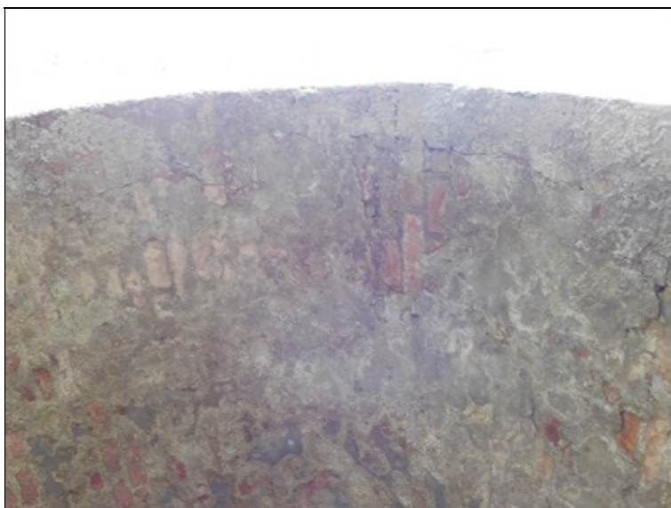
Podélná trhlina v podhledu NK vpravo
