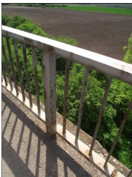
Začínající koroze zábradlí.
