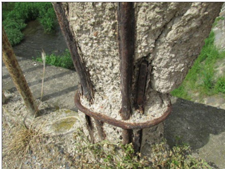
Rozpad zábradlí na mostě
