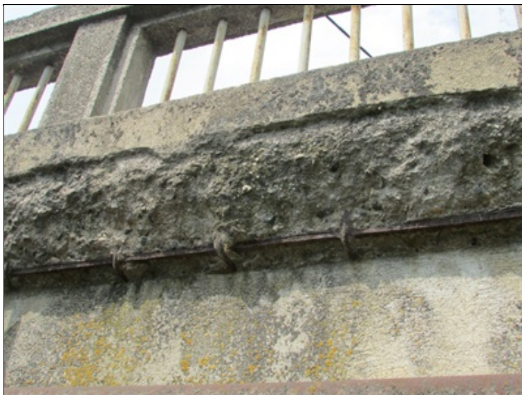
Rozpad římsy
