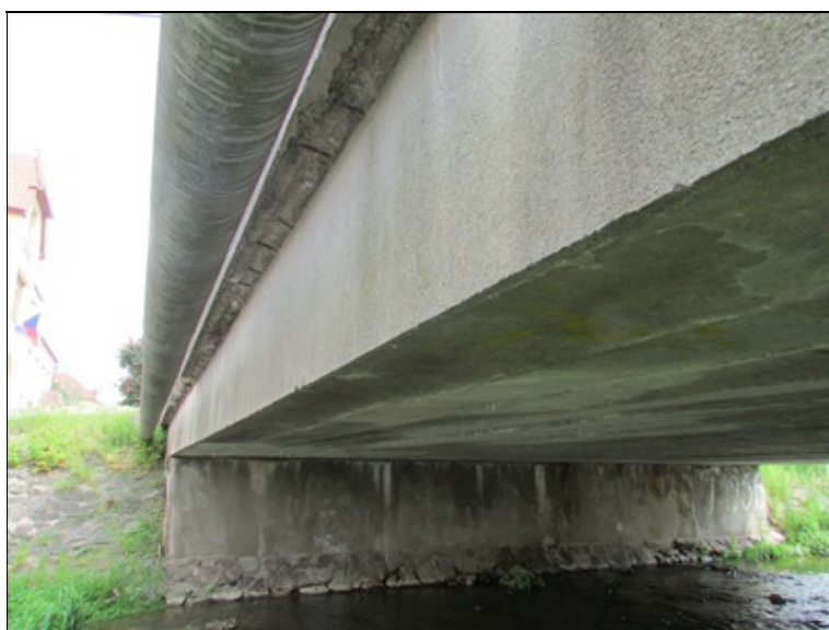
Krajní nosník NK s dobetonovaným bokem
