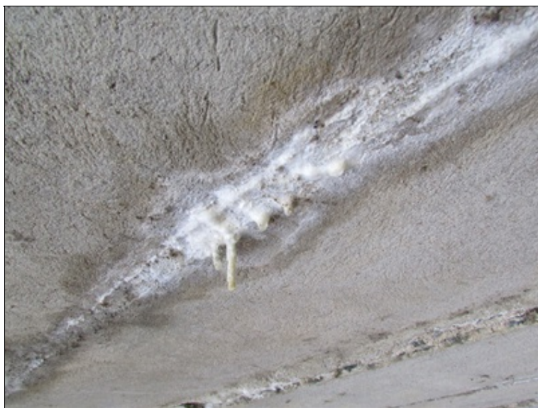
Krápníky a výluhy ve spárách mezi nosníky NK
