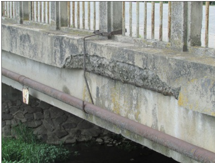
Rozpad římsy na levé straně mostu
