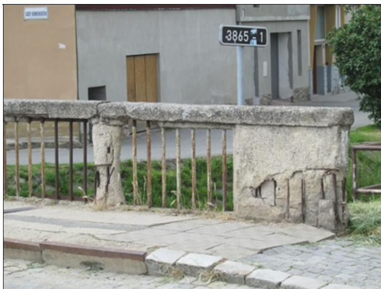
Rozpad zábradlí na mostě
