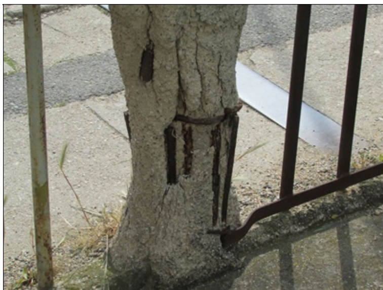
Rozpad zábradlí na mostě
