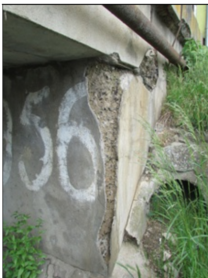
Degradovaný povrch betonu OP1 vlevo
