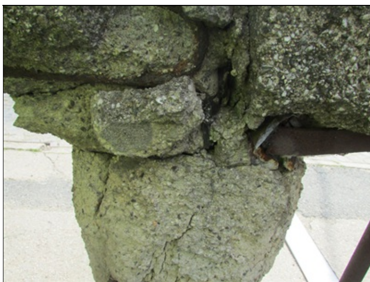
Rozpad zábradlí na mostě
