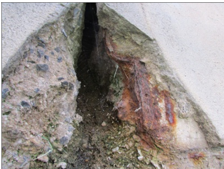
Degradovaný povrch betonu OP1 vlevo
