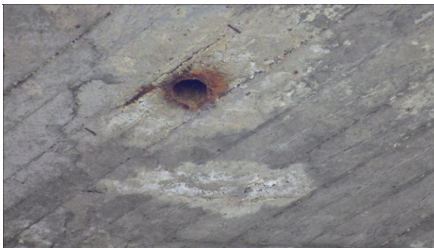
Koroze trubky odvodnění
