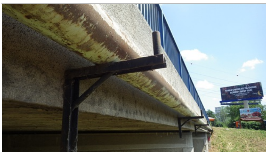
Koroze potrubí a konzol vpravo
