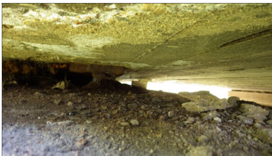
Silná koroze ložisek
