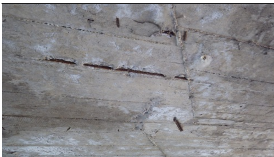
Koroze výztuže v podhledu NK
