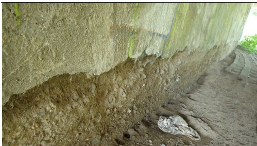
Silná degradace na opěrách u styku se zemním svahem
