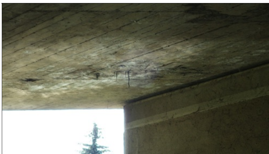
Krápníky v podhledu mezi podpěrami
