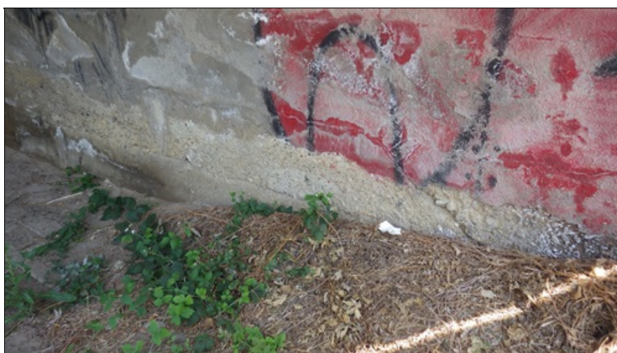
Degradace betonu opěry
