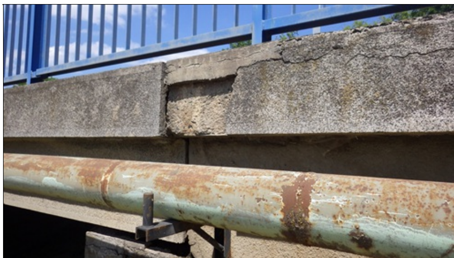
Degradace betonu pravé římsy
