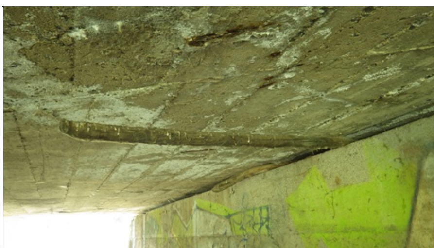
Podhled NK s vápennými výluhy
