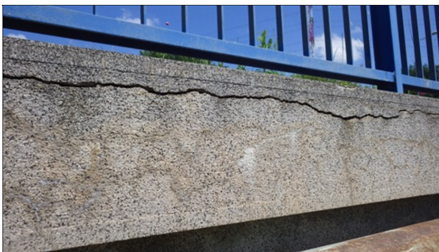
Degradace betonu římsy
