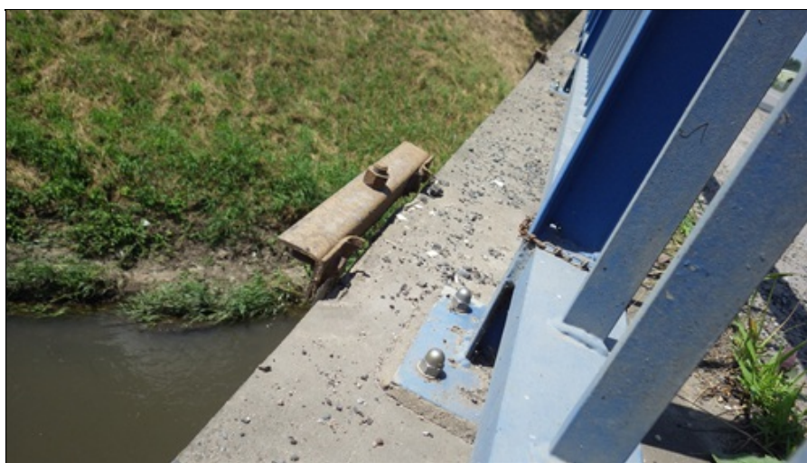
Závěsy pro chráničku ukotveny na pravé římse
