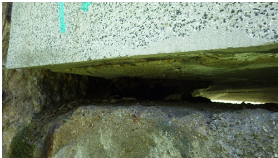
Nefunkční izolace u úložného prahu
