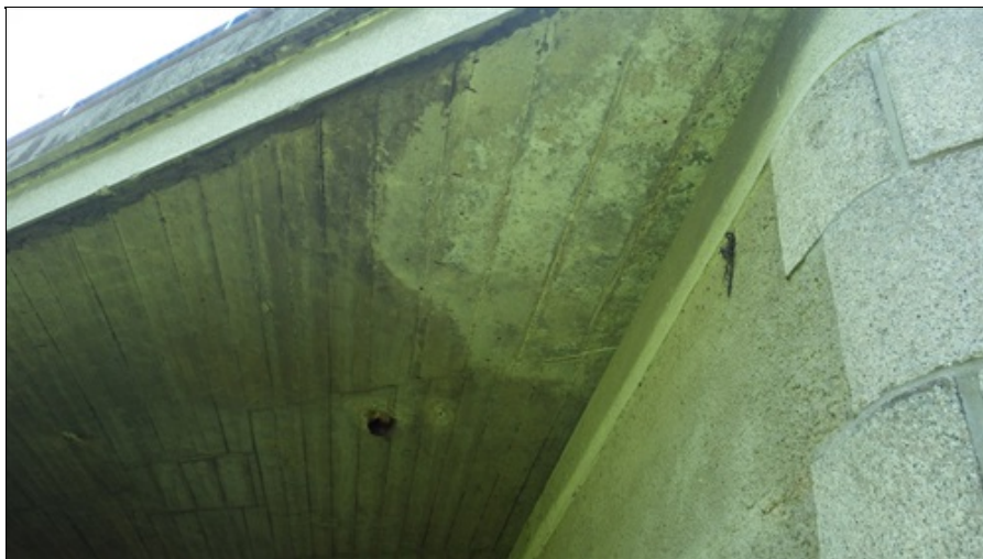
Vápenné výluhy u vnitřní podpěry 3
