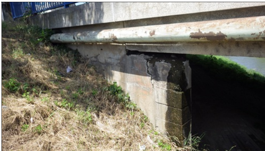
Špatný stav pravého křídla u opěry 1
