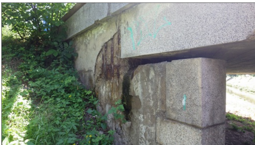
Silná degradace betonu levého křídla u opěry 4, zatéká z úložného prahu
