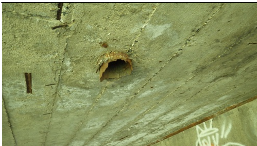
Koroze odvodňovače
