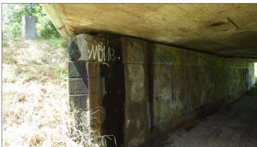
Degradace betonu vpravo u krajní opěry 1, zatéká z úložného prahu
