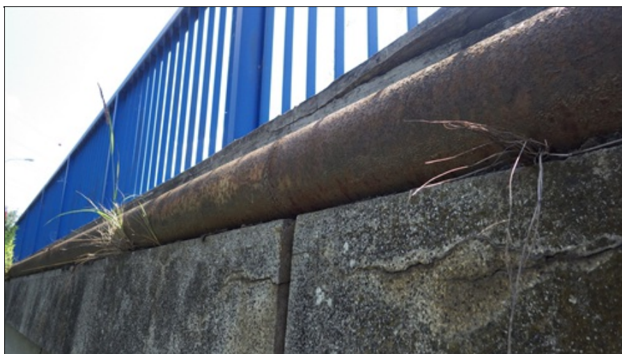
Koroze ocelové chráničky vlevo
