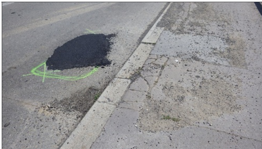
Znečištěný chodník s velkým množstvím trhlin
