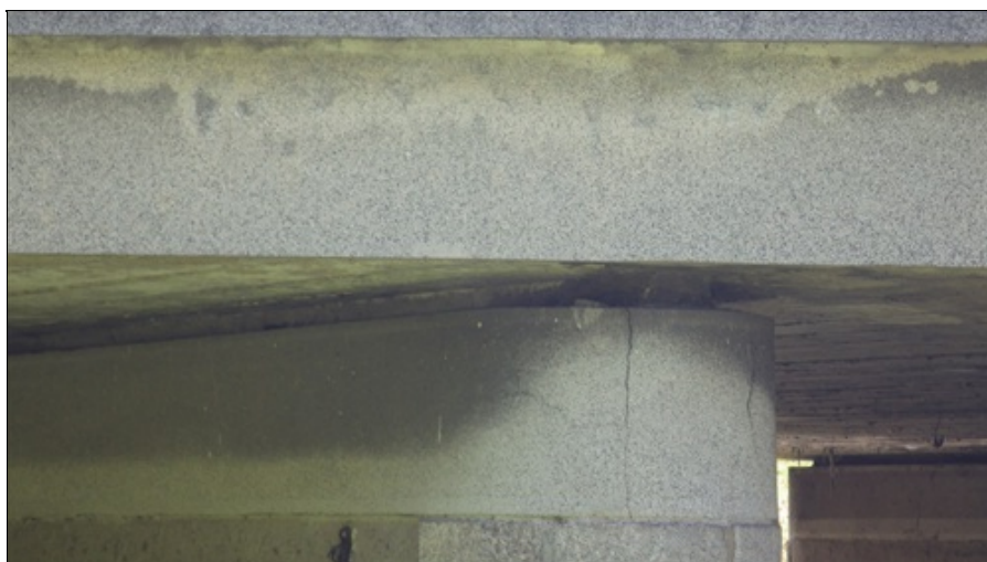
Uložení na vnitřních podpěrách
