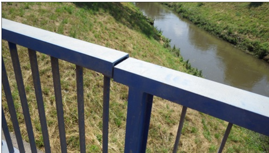
Nenavazuje horní madlo pravého zábradlí
