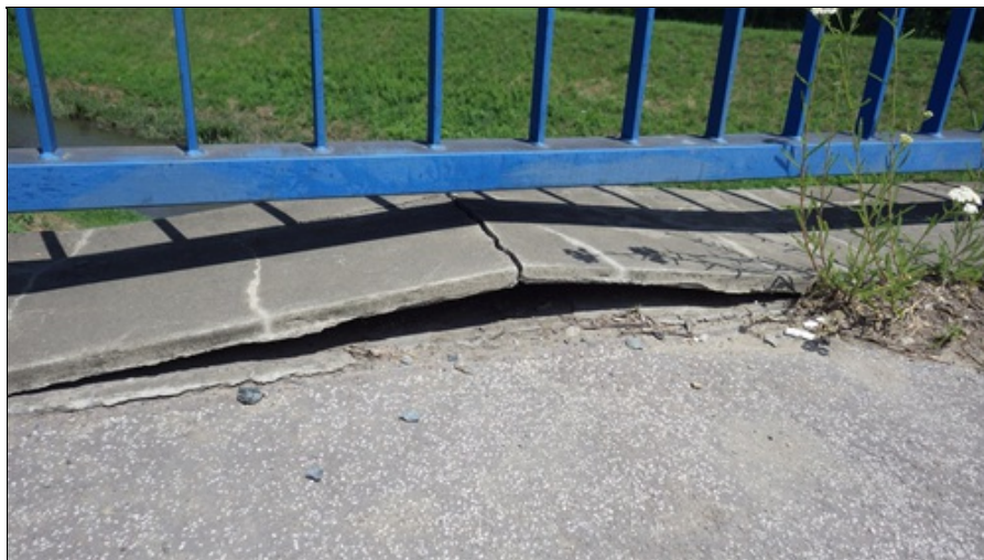
Trhlina betonu římsy
