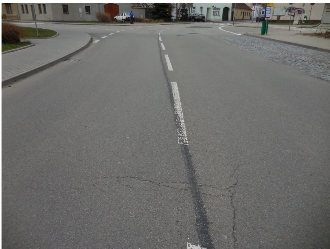
F55 – km 4,160+; kratší ojedinělé trhliny (novější obrušná vrstva)
