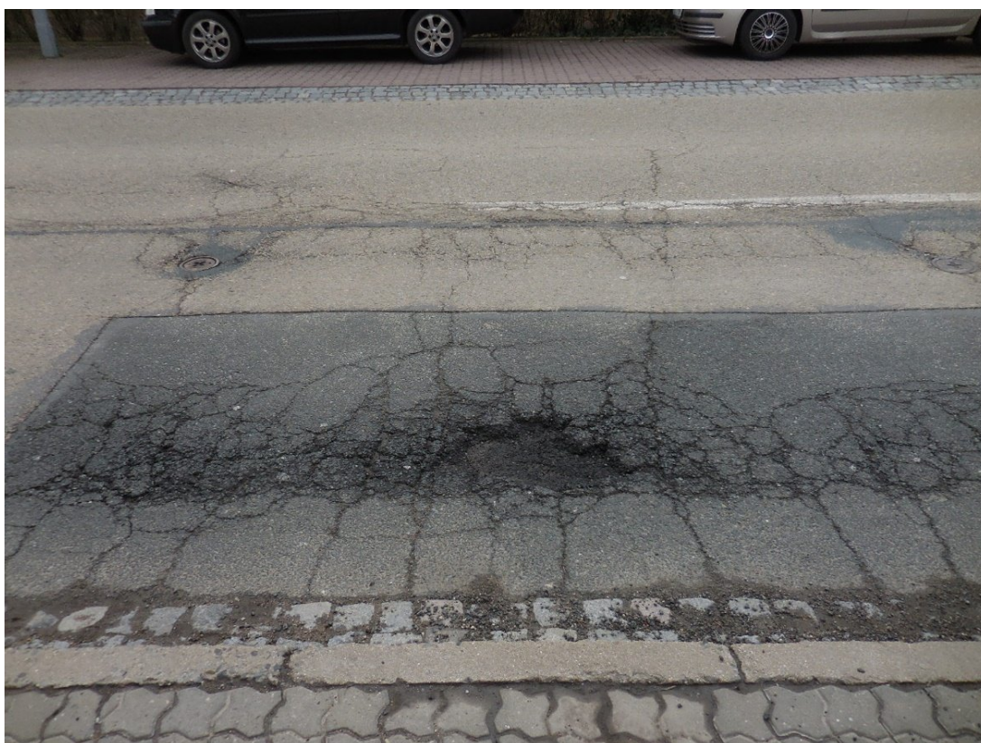
F19 – km 3,465P; výtluk v místě vysprávky a síťových (mozaikových) trhlin; trhliny v okolí
