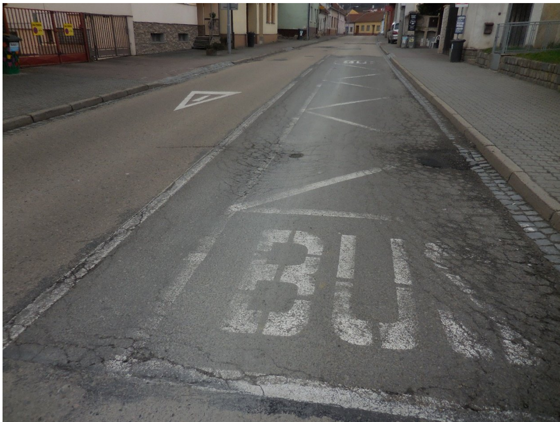
F40 – km 3,850+; konstrukční poruchy (pokles a síťové trhliny) v místě autobusové zastávky
