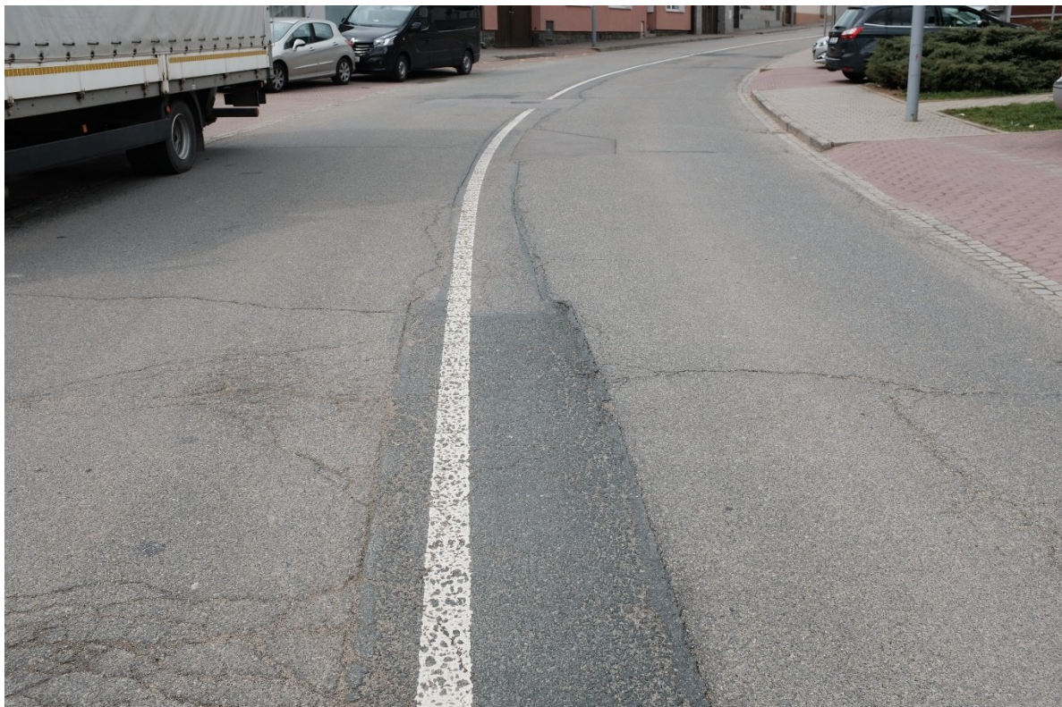
F63 – km 4,317+; vysprávkky, trhliny, koroze povrchu
