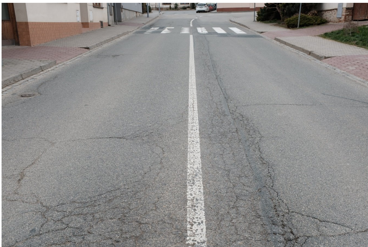
F66 – km 4,380+; mozaikové a různé jiné trhliny
