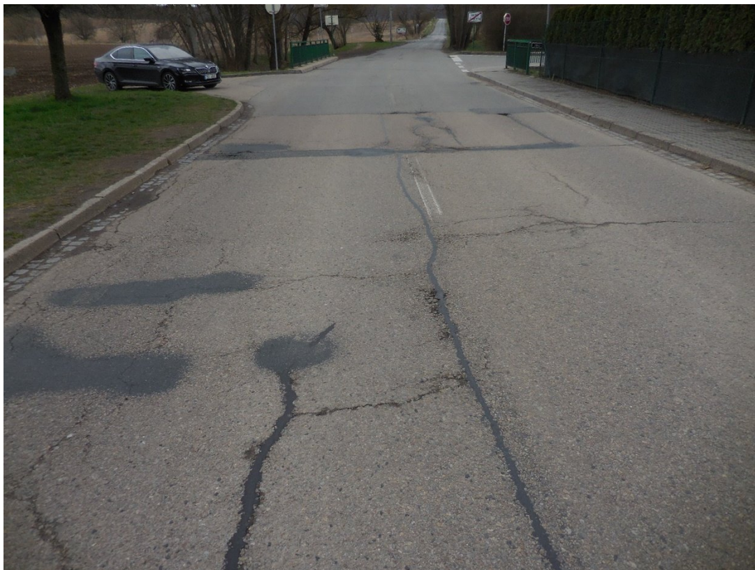
F02 – km 3,220-; pohled směrem k začátku úseku (konec mostu 3842-2); trhliny, vysprávkky
