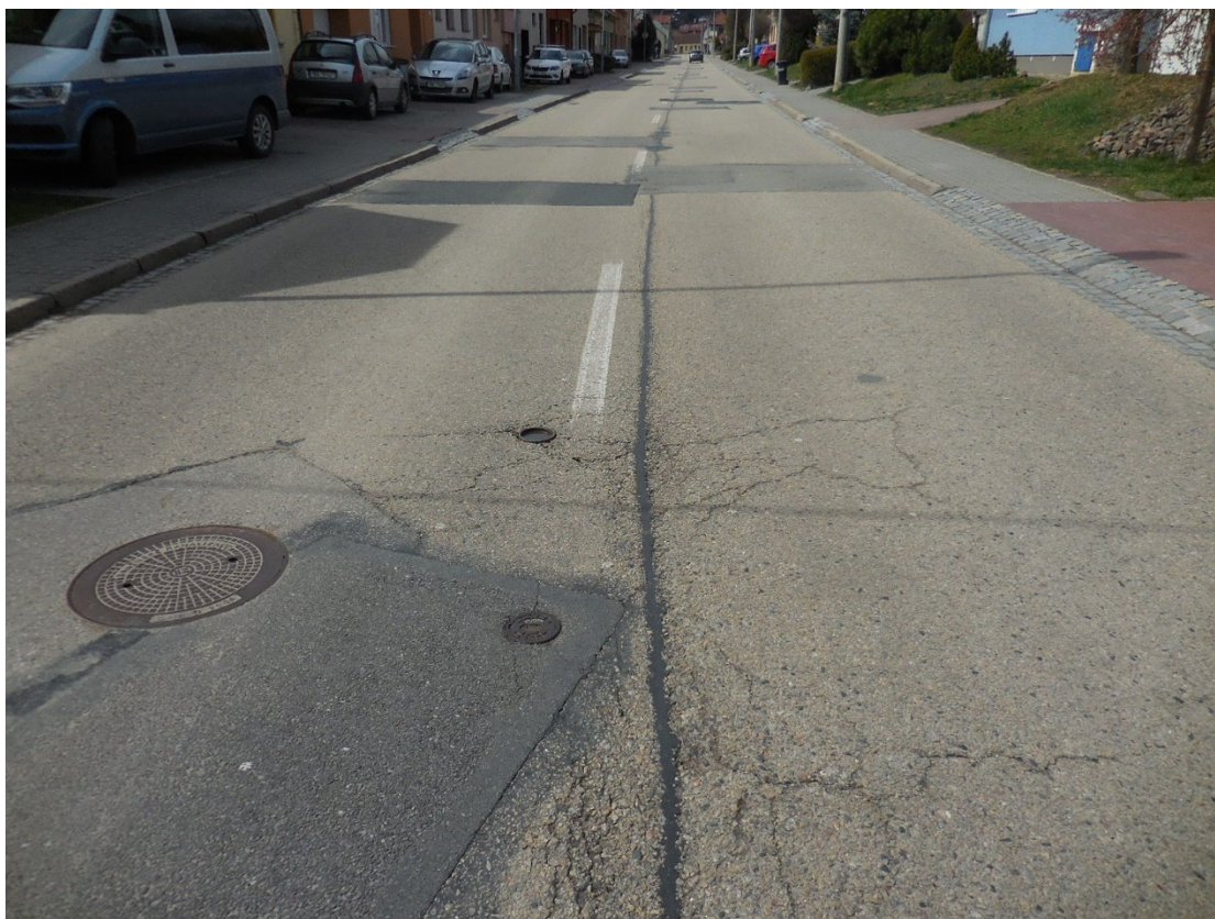
F28 – km 3,640+-; vysprávka u výstupů inženýrských sítí; trhliny uprostřed vozovky
