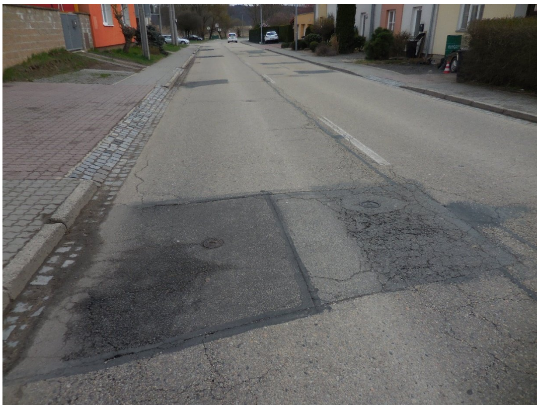
F09 – km 3,300-; trhlinami porušené vysprávkky u výstupů inženýrských sítí
