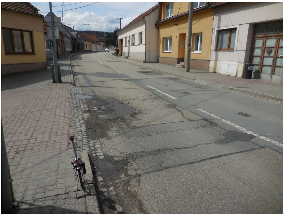
F47 – km 4,000+; vysprávkky, trhliny, pokles u uliční vpusti
