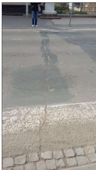
24-Příčná trhlina ve vozovce nad závěrem v uložení na OP2.jpg
