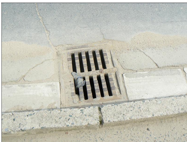
24-Příčná trhlina ve vozovce nad závěrem v uložení na OP2.jpg
