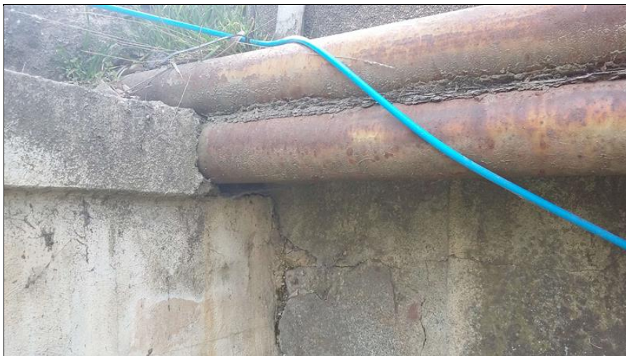
16-Uložení chrániček soukromý kabel pod mostem.jpg
