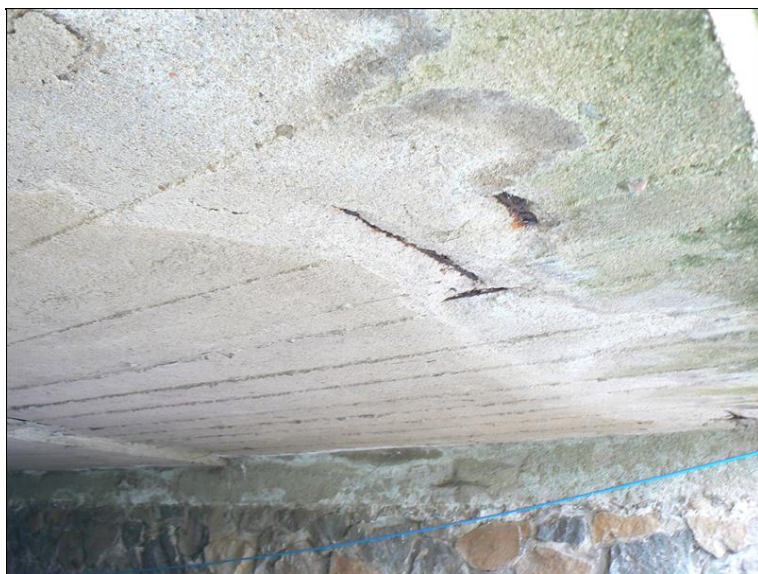
10-Podhled s prosvítající výztuží a stopami pro silném zatékání.jpg
