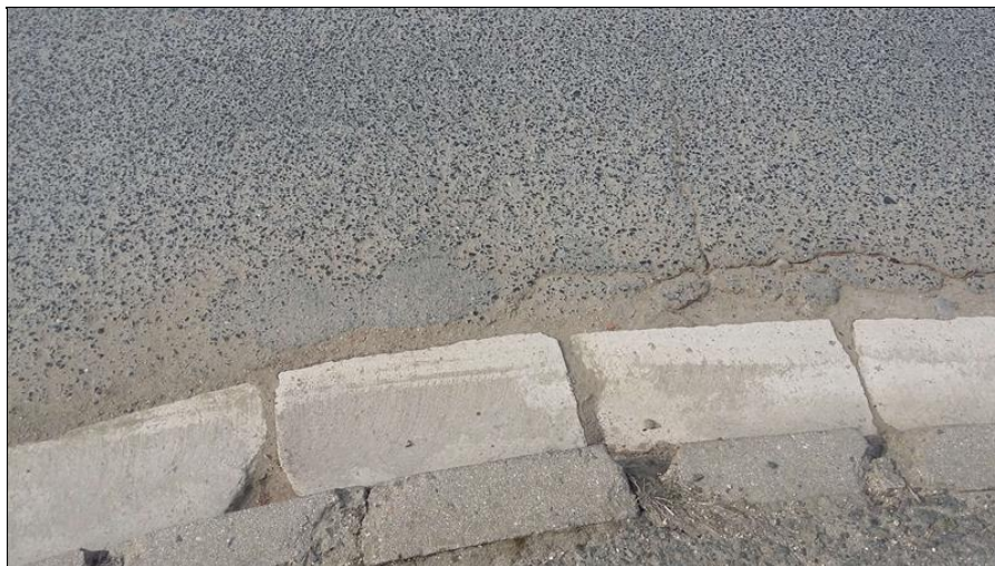
23-Mírně propadlý odvodňovač.jpg
