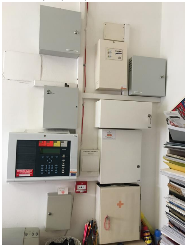
Obr. Stávající systémy EPS a EZS v m.č.1.07
