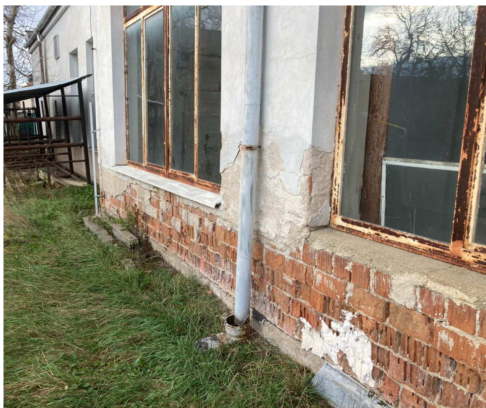
Obr. 22 Opadaná omítka na soklové části objektu
