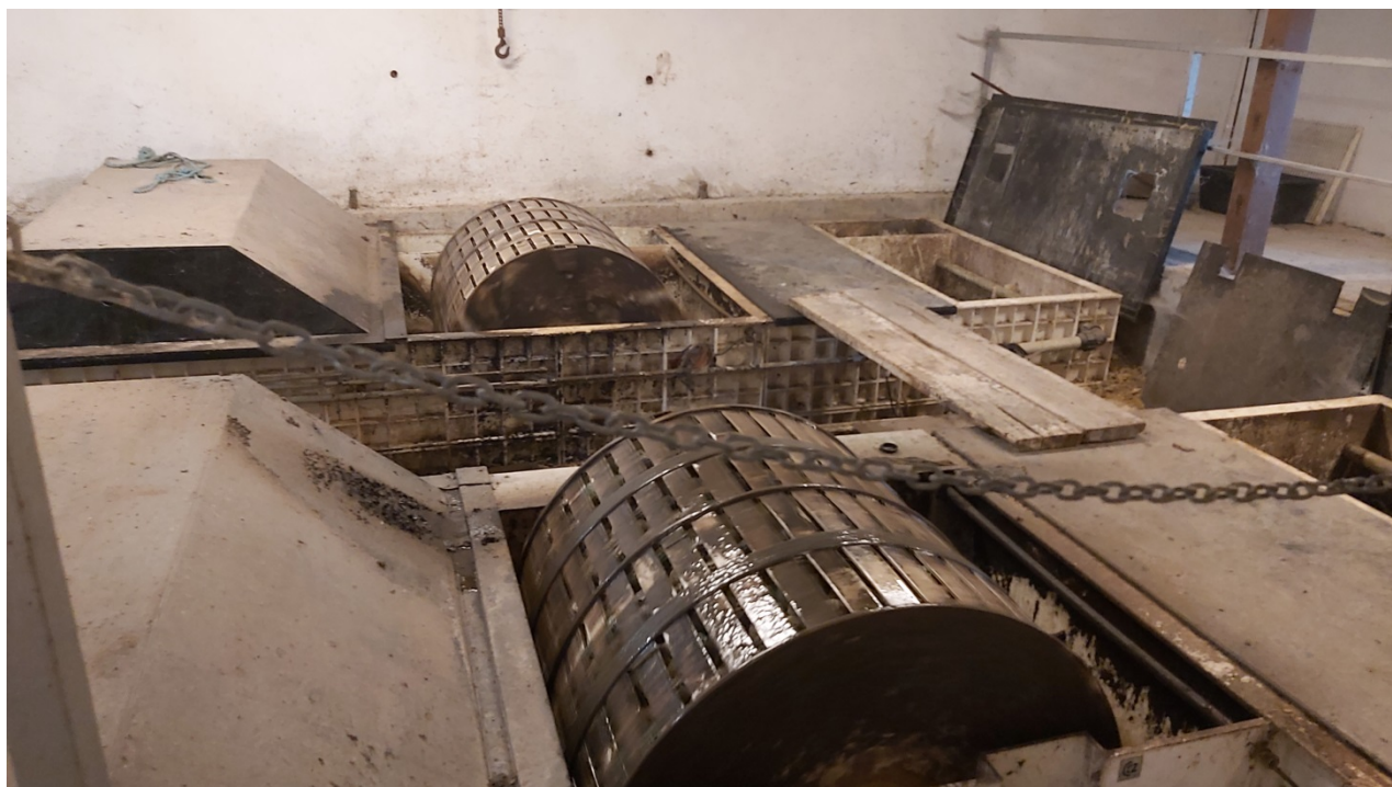
Fotografie č. 12 – Budoucí prostor čerpací jímky v místě původní linky čistírny odpadních vod – demontáž stávající technologie ČOV obou linek
