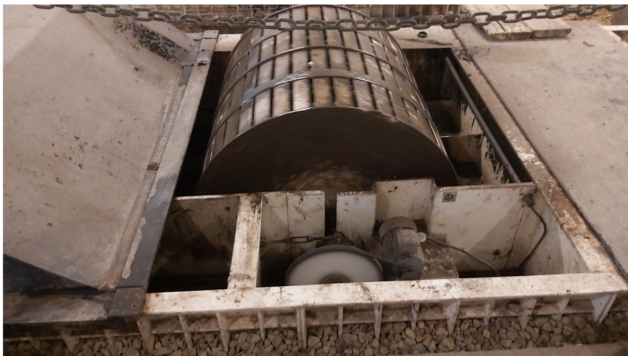
Fotografie č. 10 – Budoucí prostor čerpací jímky v místě původní linky čistírny odpadních vod – demontáž stávající technologie ČOV
