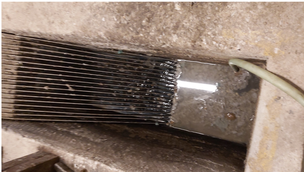
Fotografie č. 11 – Budoucí prostor čerpací jímky v místě původní linky čistírny odpadních vod – nátok s česlicemi bude zachován
