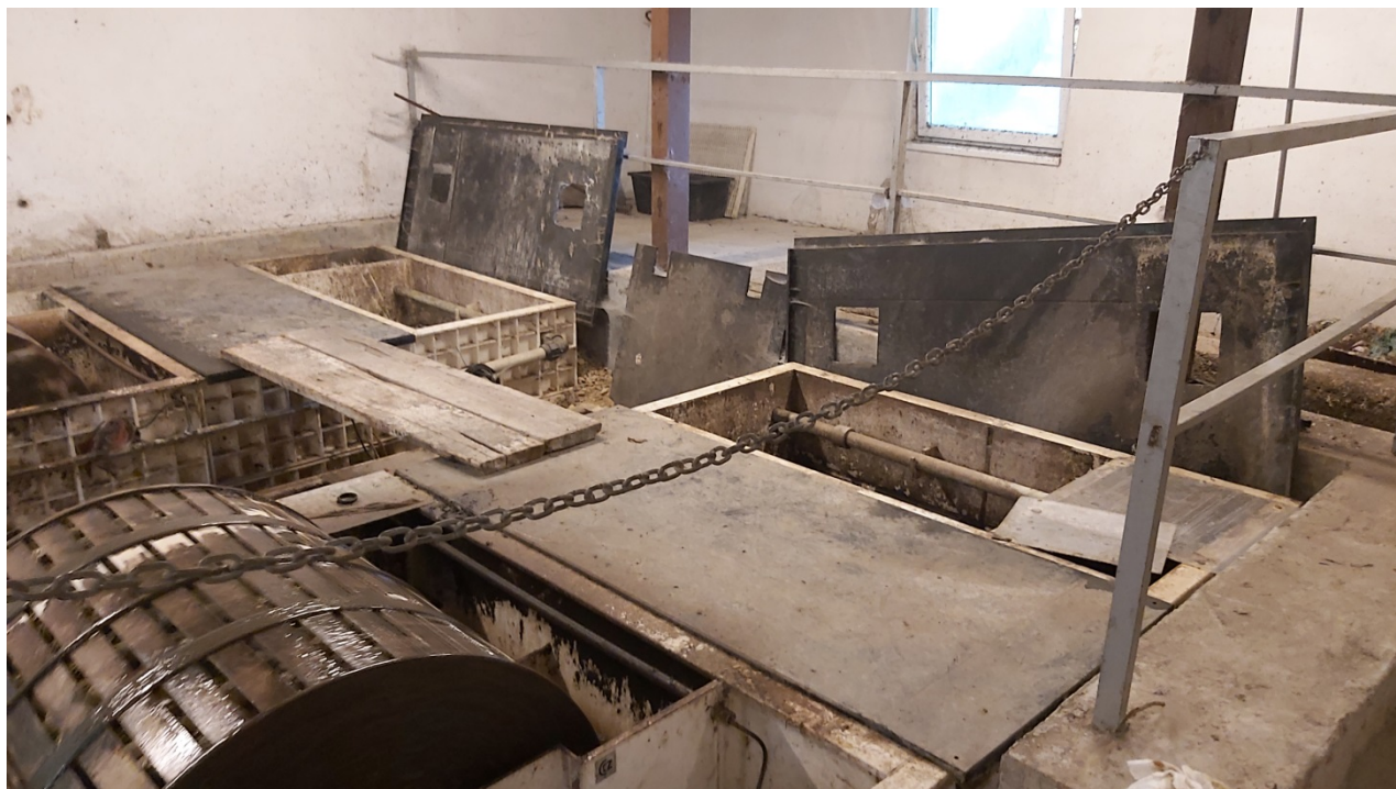
Fotografie č. 9 – Budoucí prostor čerpací jímky v místě původní linky čistírny odpadních vod
