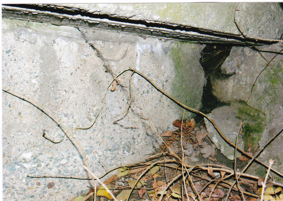
Obr.B45-889 Konec pravého křídla 5. podpěry, sloupské opěry. Pohled doleva a ke Sloupu,
