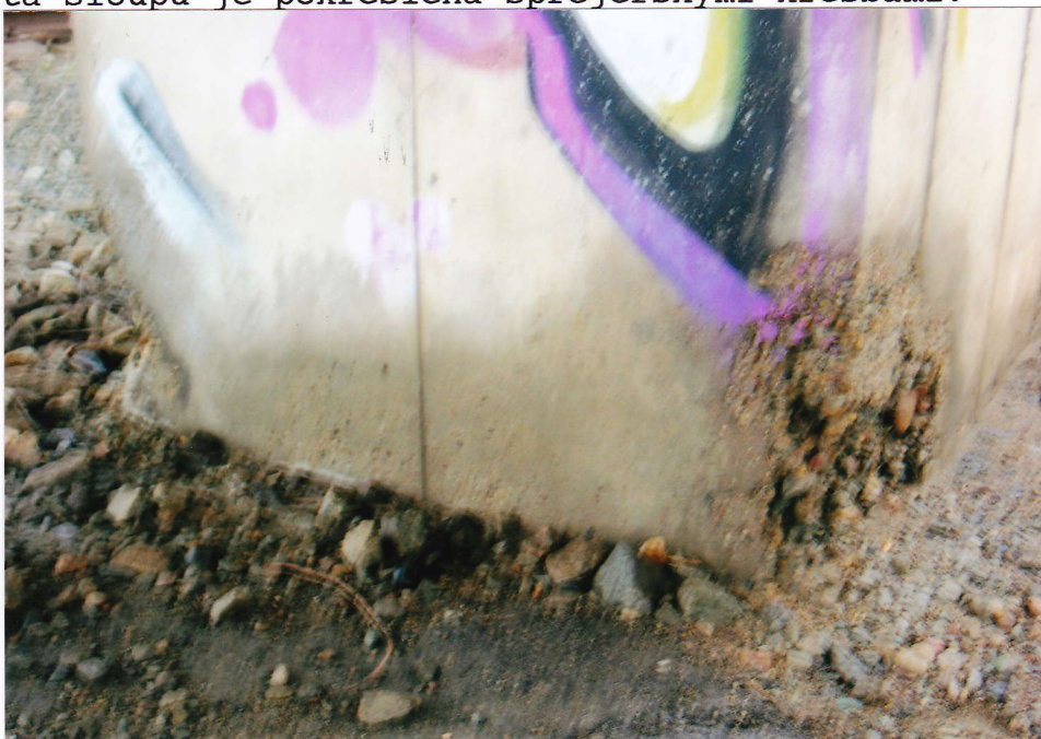
Obr. B45-844 První sloup 3., mezilehlé podpěry. Pohled diagonálně k Černé Hoře a doleva,
