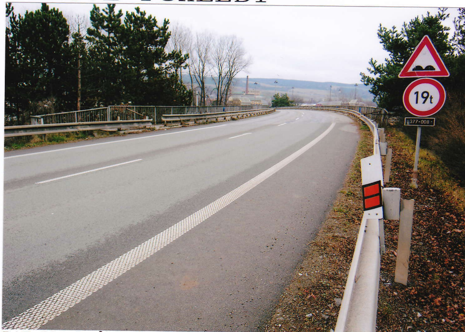
Obr.B45-801 Průhled přibližně tečnou k ose převáděné silnice č.377 od Č.Hory ke Sloupu v M.Krasu. Pohled ve směru stanič.
