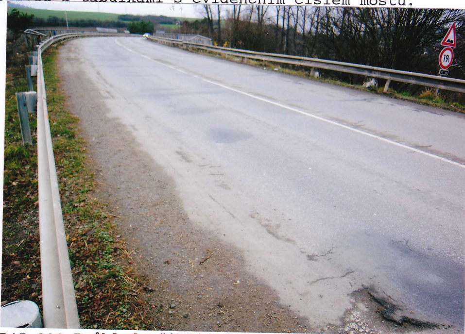
Obr.B45-802 Průhled přibližně tečnou k ose převáděné silnice č. 377 od Sloupu v Moravském Krasu k Černé Hoře. Pohled proti směru stanižení, - viz obr. B45-801 v obráceném pořadí.
