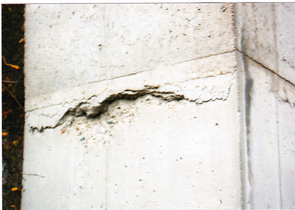
Obr.B45-866 Pravá strana třetího sloupu 4., mezilehlé podpěry. Pohled doleva,
