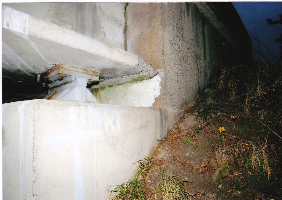
Obr.B45-882 Pravé křídlo 5. podpěry, sloupské opěry. Pohled doleva a ke Sloupu,
