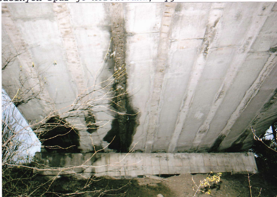
Obr. B45-873 Podhled 2. části 4. pole. V pozadí 5. podpěra. Pohled směrem ke Sloupu,
