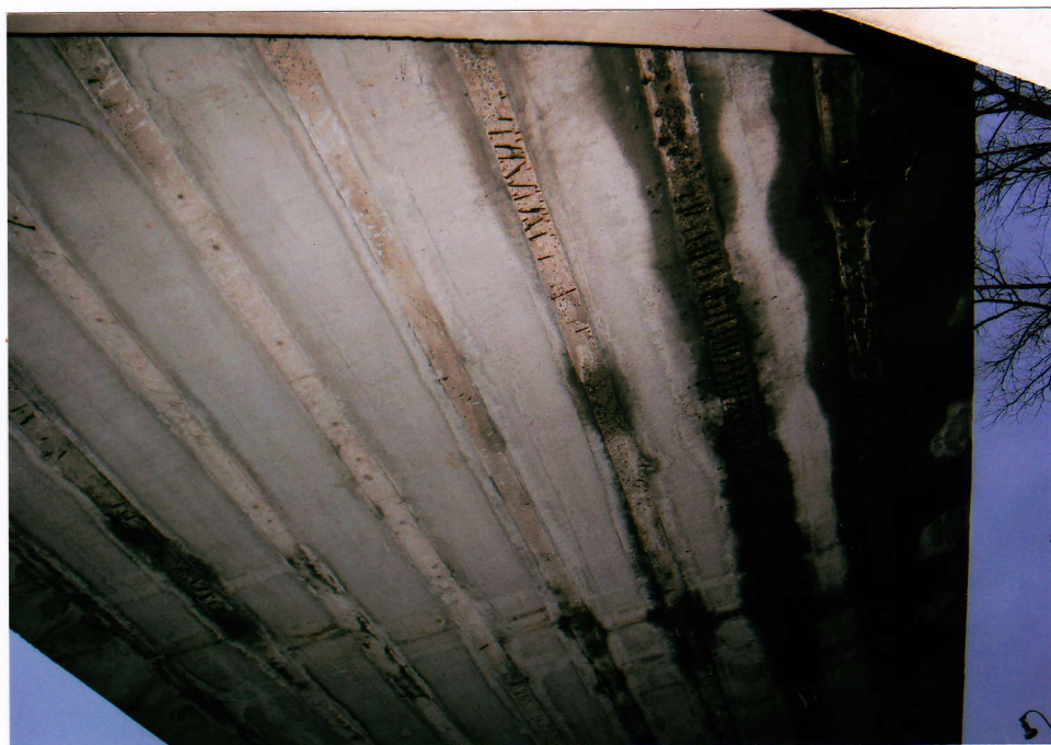
Obr.B45-869 Podhled levé poloviny 2. části 3. pole. Pohled od 4. podpěry směrem k Černé Hoře,
