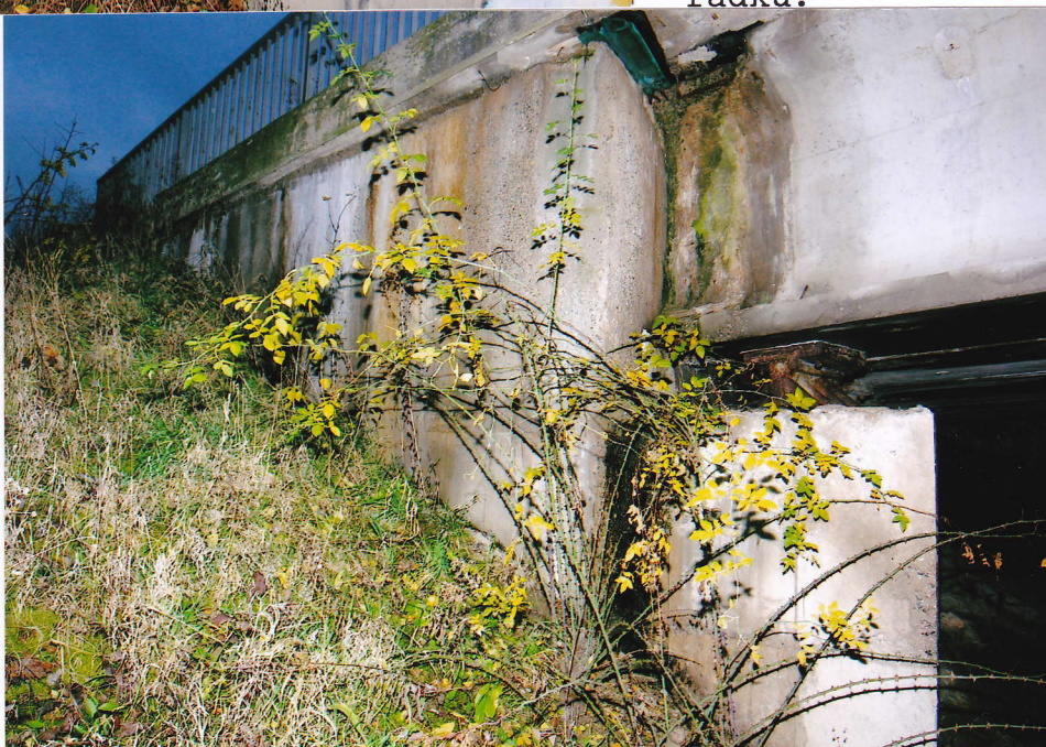
Obr.B45-879 Levé křídlo 5. podpěry, sloupské opěry. Pohled ke Sloupu a doprava,
