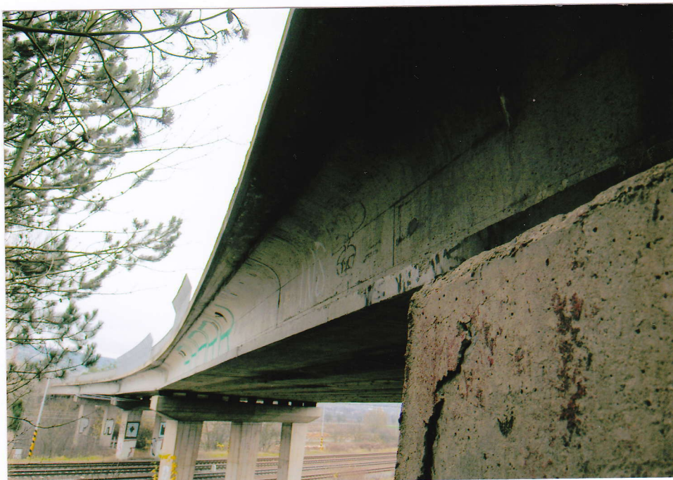
Obr.B45-803 Levá strana mostu. Pohled od 1. podpěry ve směru staničení, k obci Sloup,
