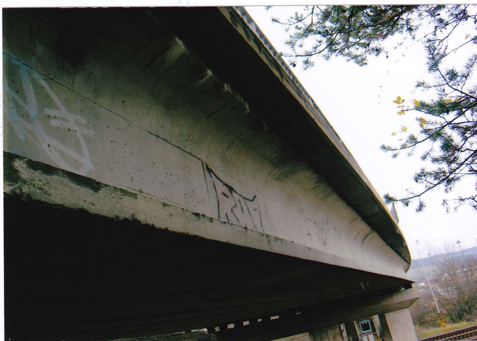
Obr.B45-804 Část pravé strany mostu (1. pole). Pohled od 1. podpěry ve směru staničení, k obci Sloup,
