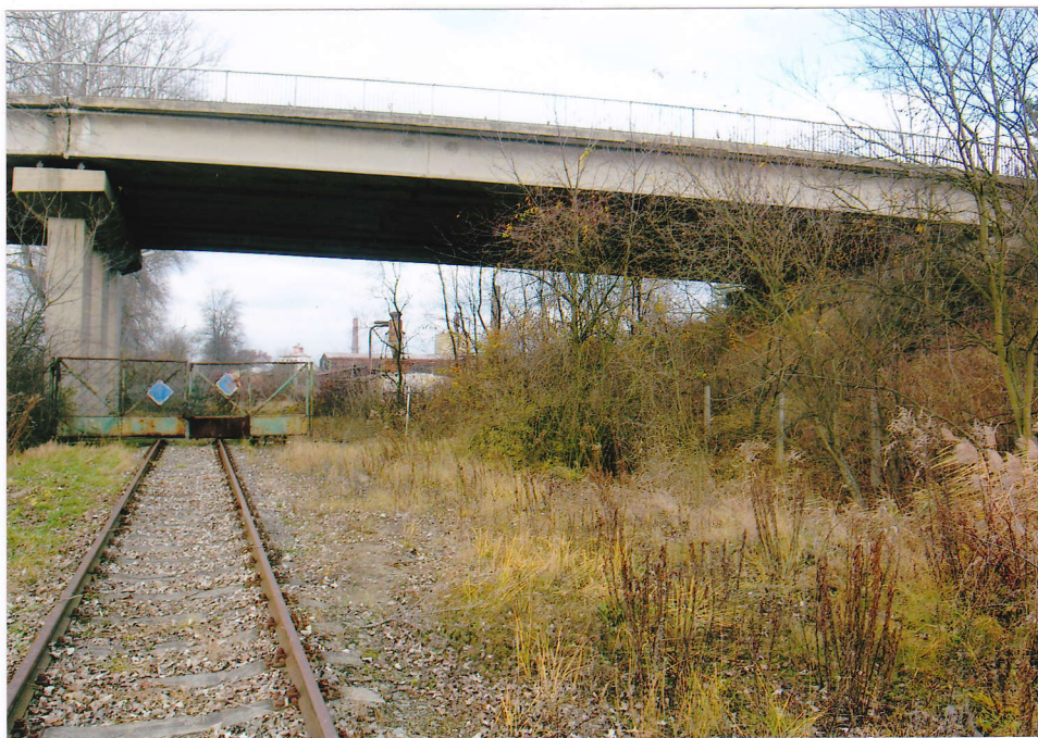
Obr.B45-144 Území ve 4. mostním otvoru. Pohled zprava do le- va. Vlevo je směr Č.Hora, vpravo Sloup, - územím prochází vlečka do průmyslového závodu na levo od silnice II/377 a do areálu pily napravo od silnice II/377. Areal pod mostem je nepřístupně zaplocen a vlečka v něm zarostlá dvacetiletými stromy.
