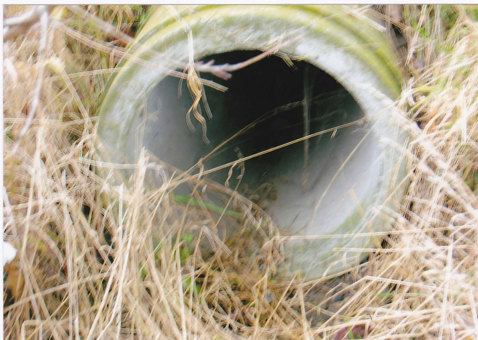
Obr.B45-834 Trouba \varnothing 500 mm ústící ze svahu násypu železničního tělesa vpravo za 3. podpěrrou a odvodňující patrně bezodtokové území v 1. poli. Pohled směrem k Černé Hoře a dolů,
