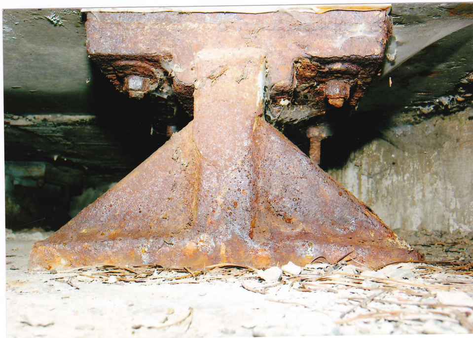
Obr.B45-822 Pevné ložisko pod 1. nosníkem, na levém konci 1. podpěry. Pohled doprava,
