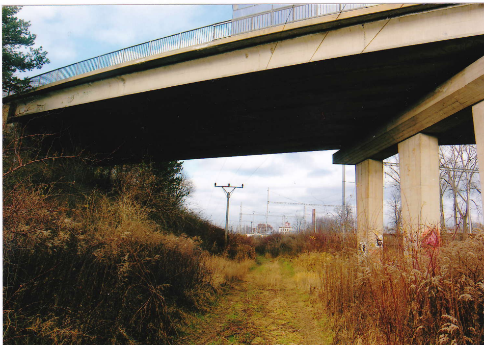
Obr.B45-140 Území v 1. mostním otvoru. Pohled zprava do le- va. Vlevo je směr Č.Hora, vpravo Sloup, - územím prochází místní komunikace, polní cesta, využívaná jen pro práce na sousedních zemědělských pozemcích.
