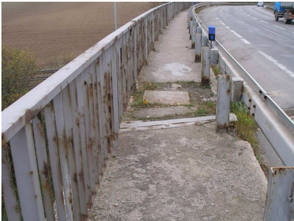
Obr. 3, Pohled římsu a povrchový závěr nad podpěrou 2
