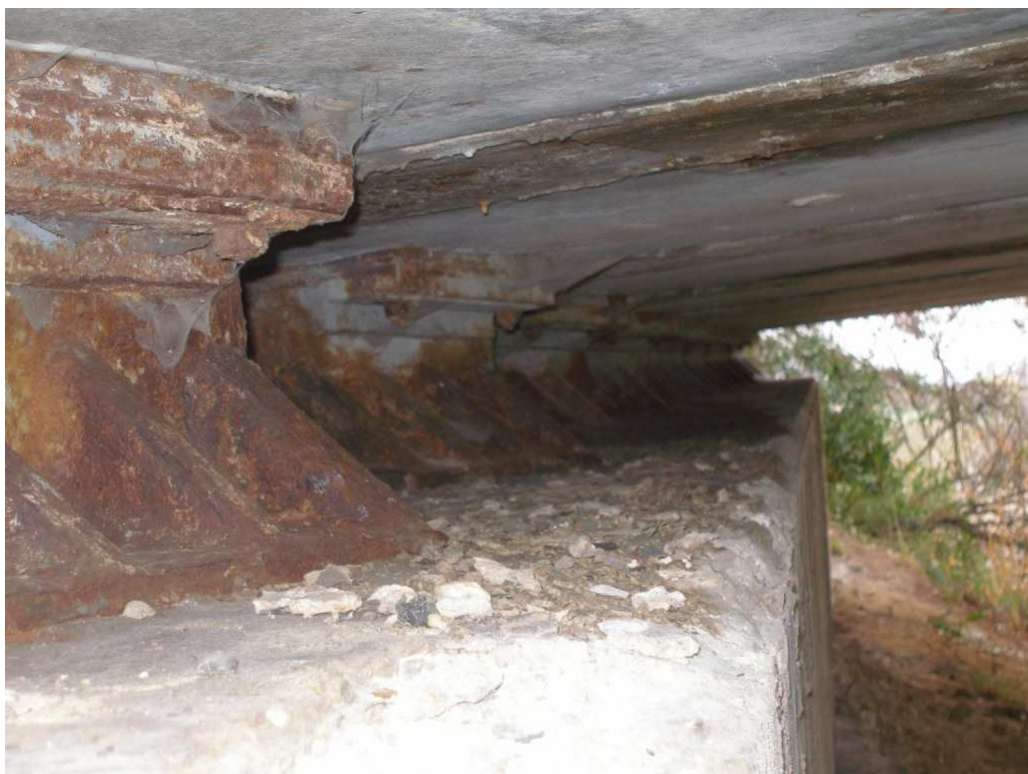
Obr.18, Mostní ložiska u opěry 1
