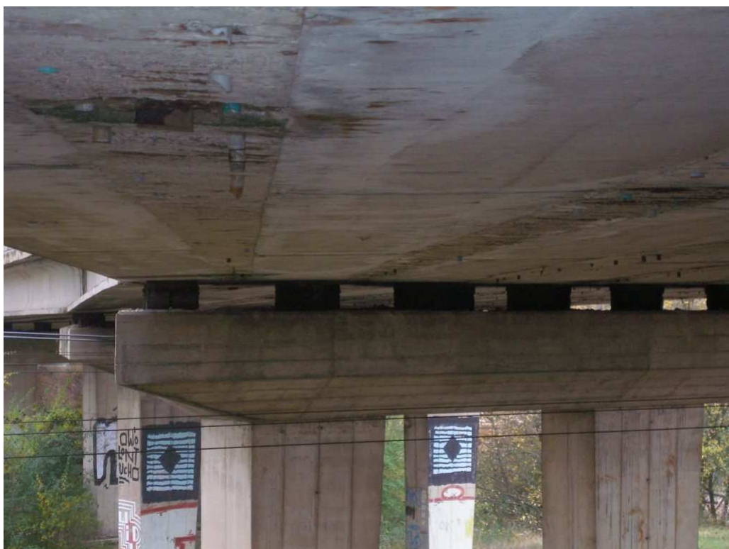
Obr.8, Pohled na podhled nosné konstrukce a úložný práh podpěry 3
