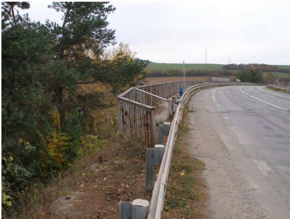
Obr. 1 – Celkový pohled na most ev.č. 377 - 008, pohled na vozovku ve směru na Černou Horu
