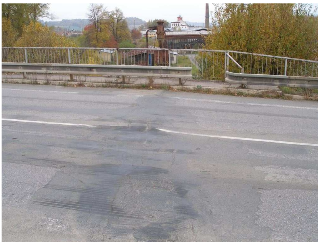
Obr. 2 – Pohled na závěr opěry 1
