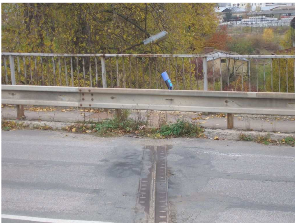
Obr. 4, Pohled na povrchový dilatační závěr nad opěrou 2
