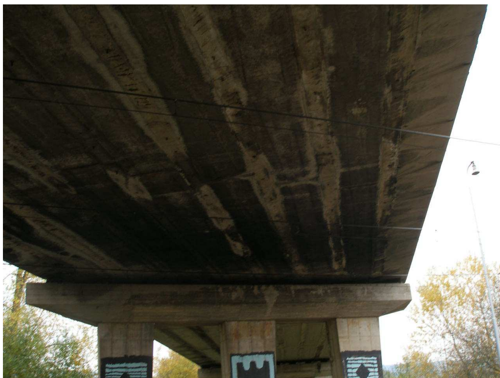
Obr. 12, Podhled druhého mostního pole
