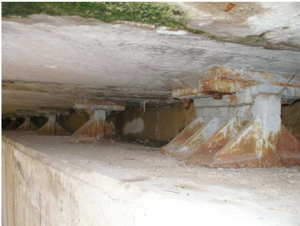
Obr.17, Mostní ložiska u opěry 1
