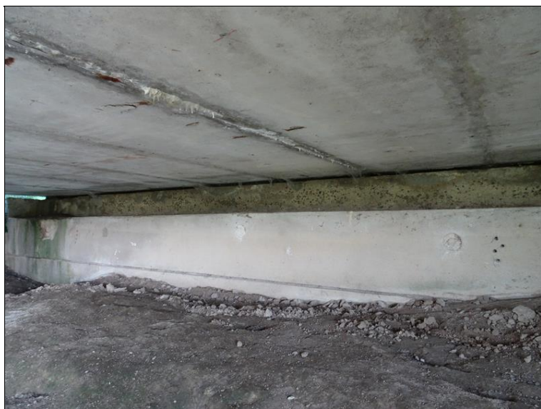
8.JPG Opěra 2 (Op2) a podhled NK. Parný dlouhodobý průsak spárou mezi nosníky - inkrustace výluh.
