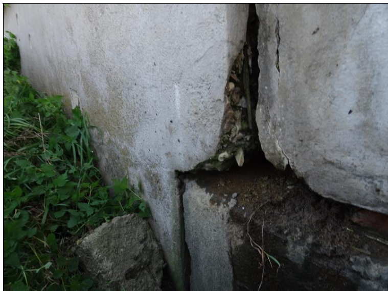
17.JPG Levá strana Op2 v místě uložení konce krajního nosníku.
