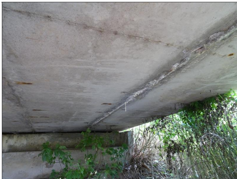
10.JPG Pravá strana Op2. Krajní spára mezi nosníky s inkrustací výluh. Lokální obnažení výztuže na podhledu nosníků
