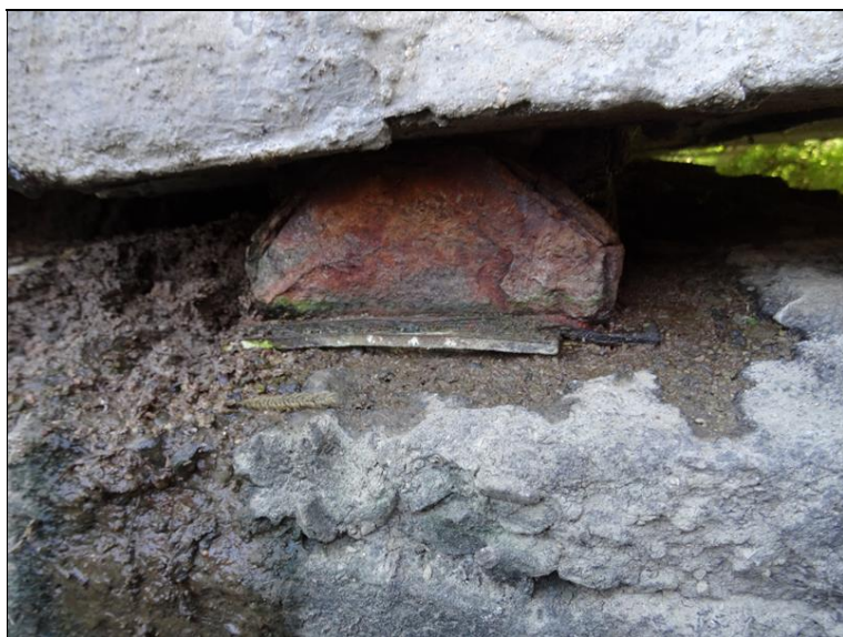
18.JPG Bok levého krajního ložiska
