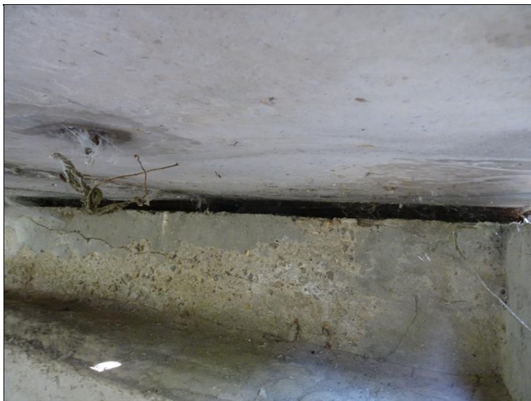
13.JPG Pravá strana Op2 v místě uložení krajního nosníku. Ve dně nosníku je před Op2 proveden odvod. otvor. komory nosníku.
