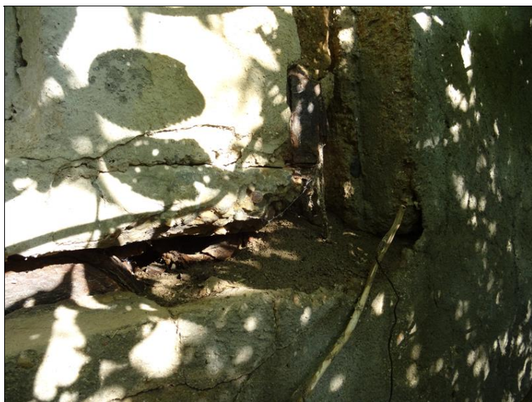
20.JPG Uložení pravého krajního nosníku na Op2.
