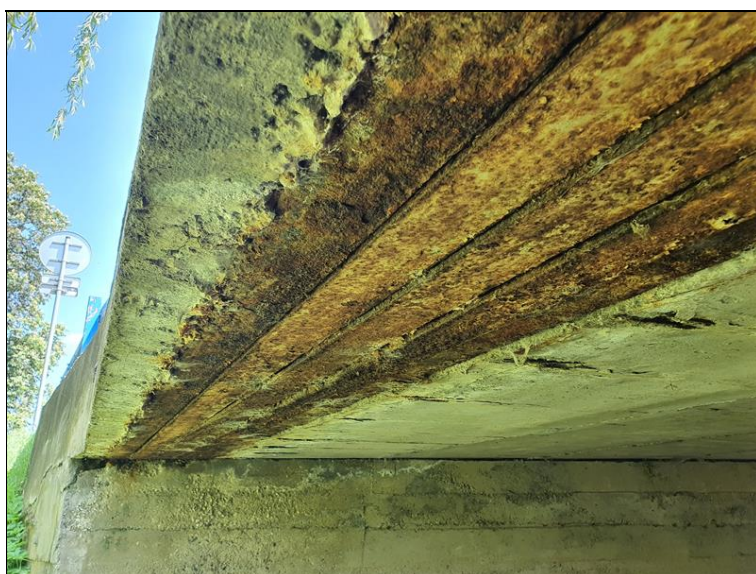
Podhled NK, korodující nosníky přibetonávky
