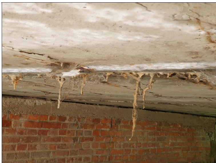
Průsaky na podhledu NK
