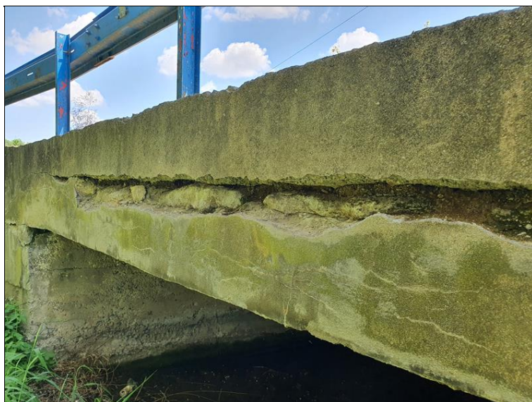
Poškozená pravá strana NK a římsy
