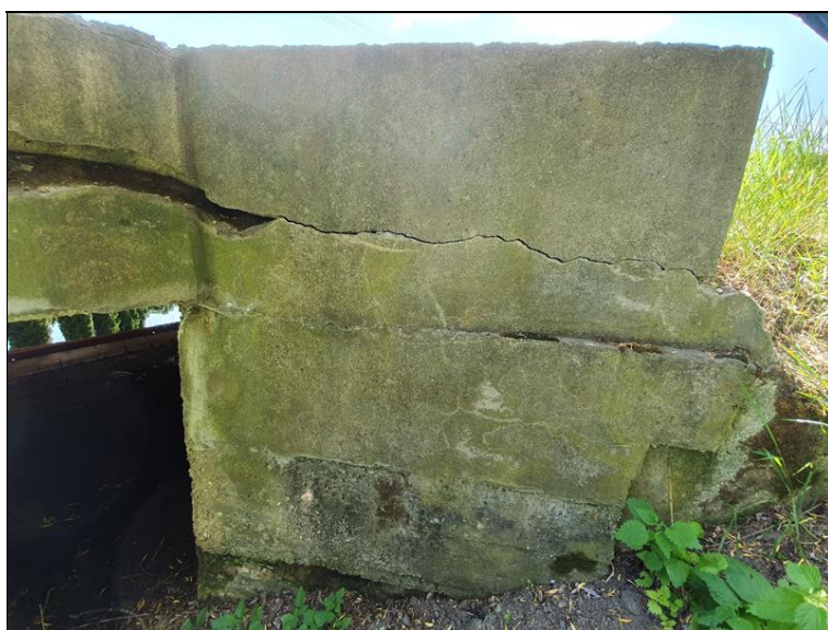
Trhlina na OP2 vpravo
