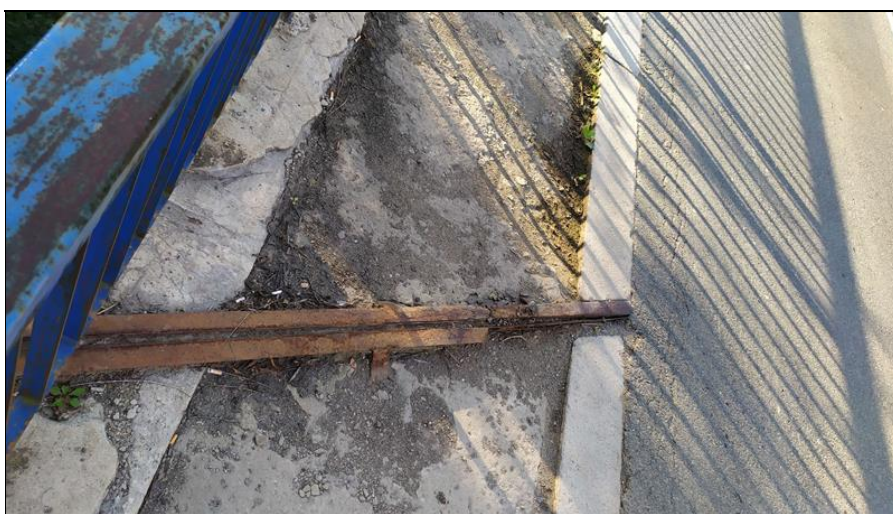
Detail korodujících úhelníků dilatace.
