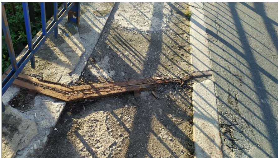
Detail korodujících úhelníků dilatace.
