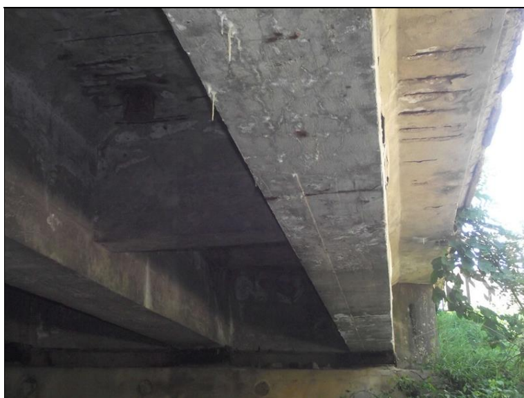
Podhled levé strany NK. Stopy zatékání jsou na celém podhledu nosné konstrukce, odpadává krycí vrstva. Výluhy, obnažená třmínková výztuž koroduje.
