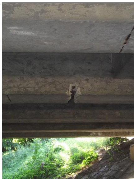
Detail pohledu NK. Na prostředním nosníku uprostřed rozpětí je nezapravená sekaná sonda podélné výztuže.
