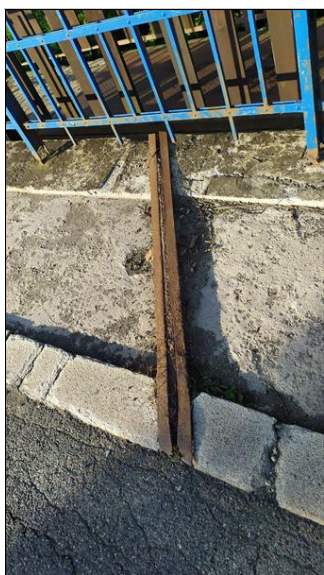
Detail korodujících úhelníků dilatace.
