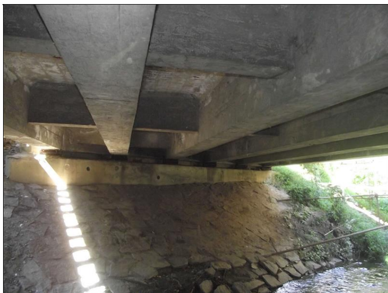
Detail pohledu NK. Na prostředním nosníku uprostřed rozpětí je nezapravená sekaná sonda podélné výztuže.
