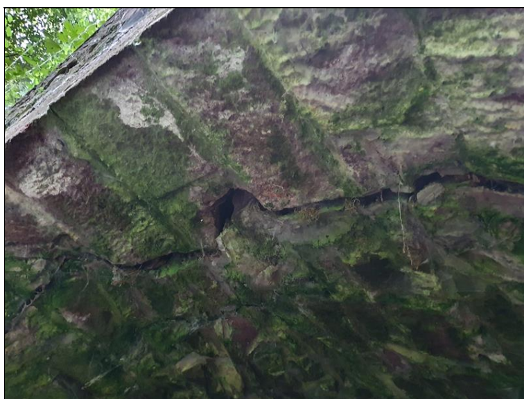
Trhlina v klenbě na vtoku
