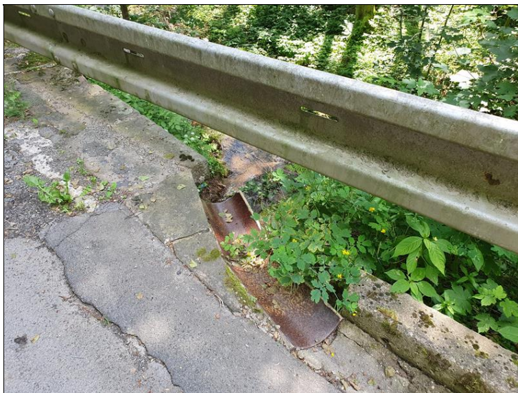
Odvodnění krajnice
