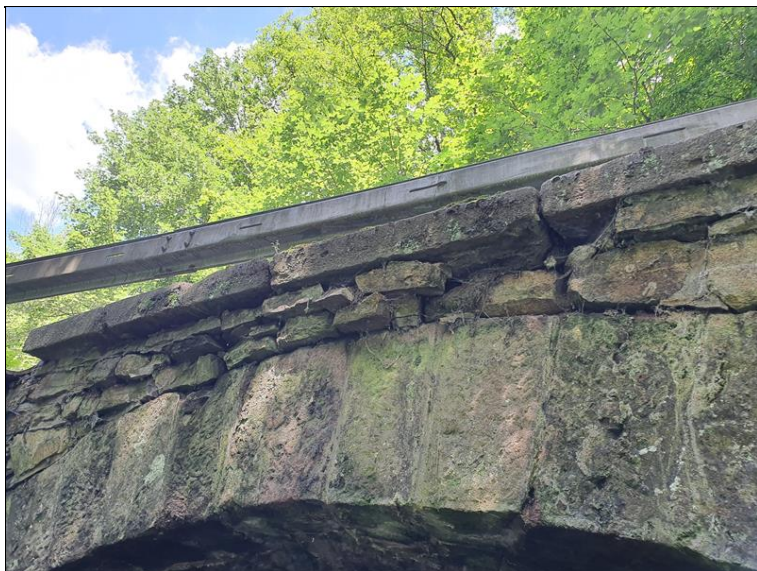
Rozpadlá pravá římsa
