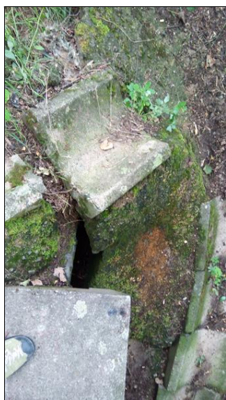
Odpadnutý skluz u křídla OP2 vpravo_2.jpg
