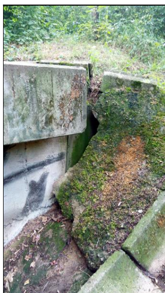
Odpadnutý beton u křídla OP2 vpravo.jpg
