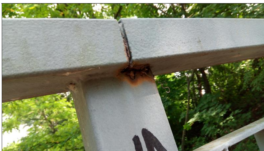
koroze zábradlí vpravo.jpg
