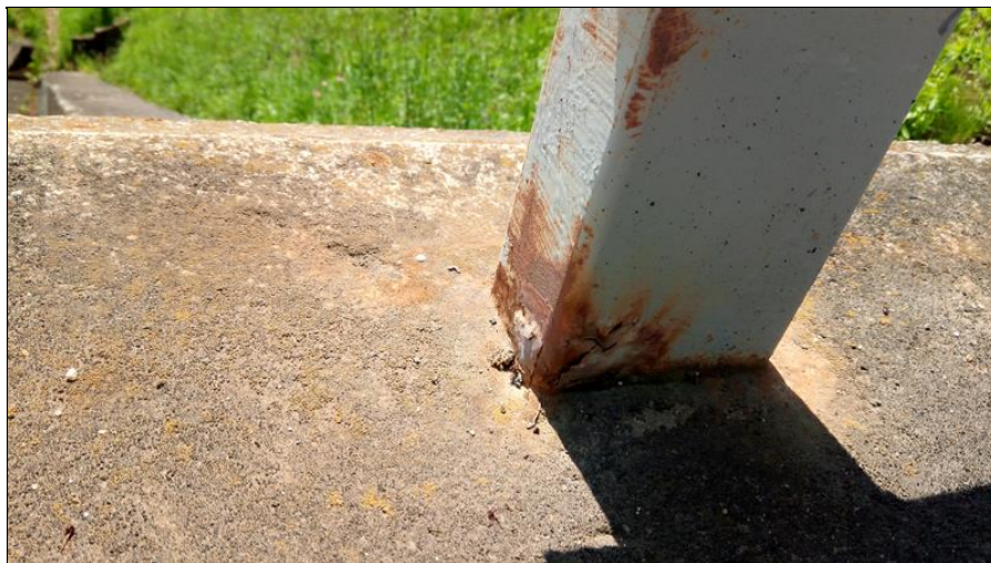
Koroze sloupku zábradlí vlevo.jpg
