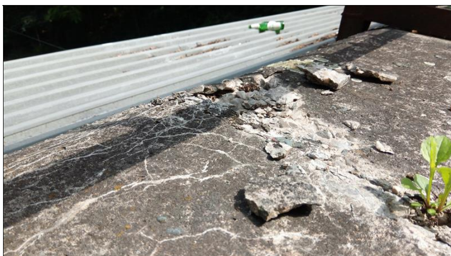
Degradace a všesměrné trhliny v omítce pravé římsy.jpg
