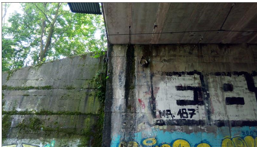
Stopy po zatékání OP1 vpravo.jpg
