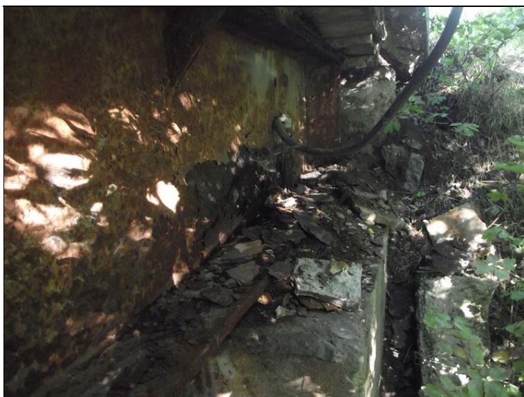
Detail uložení na opěře OP4. Značná koroze hlavního nosníku, znečištěný úložný práh.
