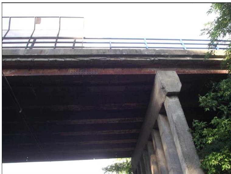
Pohled na pravý krajní nosník, značná koroze.
