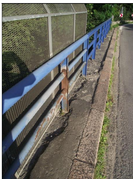
Detail zábradlí a protidotykové zábrany. Deformace a koroze.
