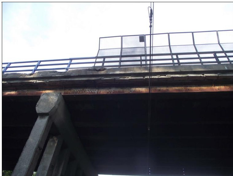
Detail levého okraje vozovky, rozpad římsy, chybějící obruby.
