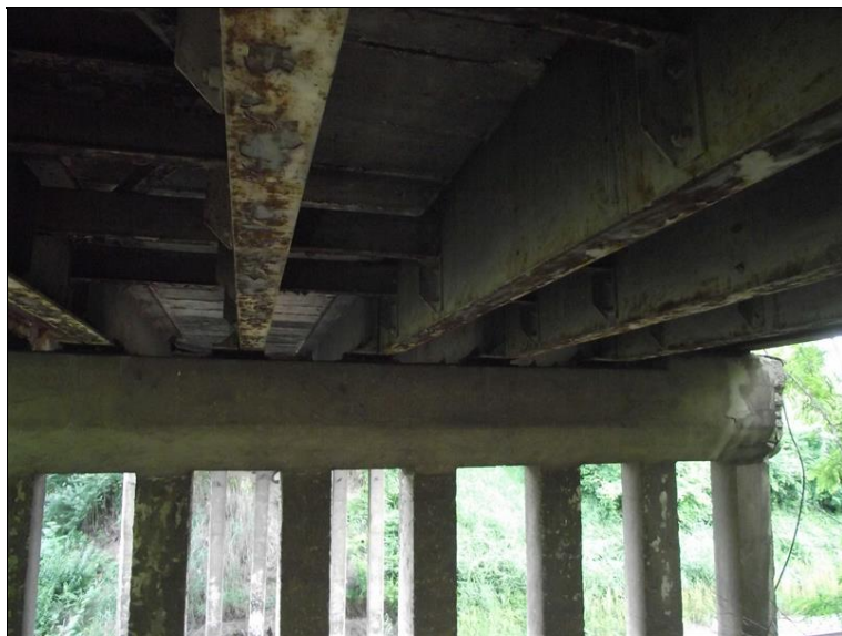
Detail uložení na pilíři P3
