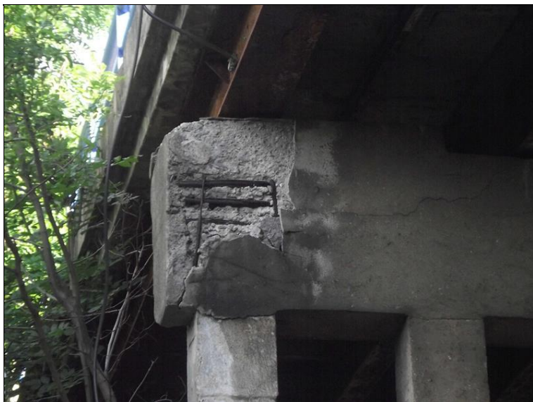
Detail pravého boku pilíře OP2
