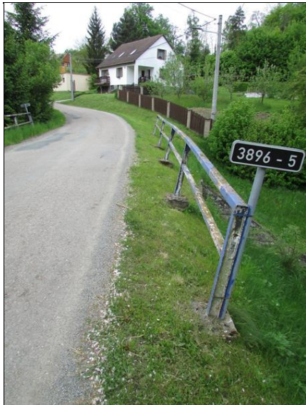
Pravé zábradlí - vykloněné
