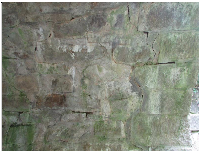
Podélná trhlina v klenbě pod čelní zídkou na levé straně
