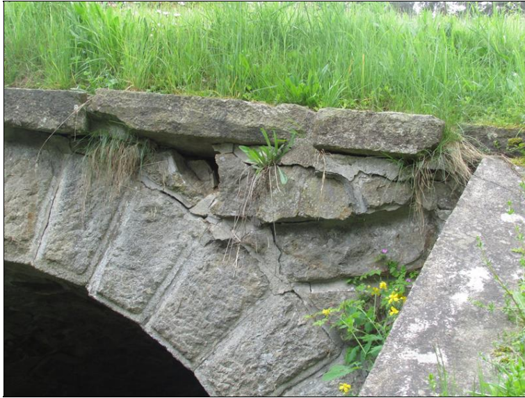
Pravé zábradlí - vykloněné
