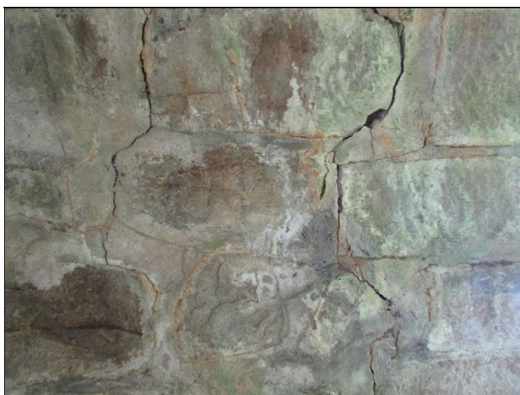
Podélná trhlina v klenbě pod čelní zídkou na levé straně- detail
