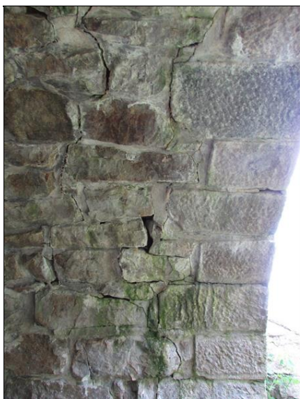
Podélná trhlina v klenbě pod čelní zídkou na pravé straně
