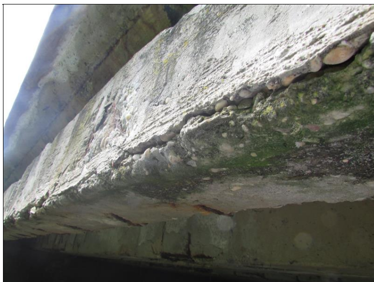
degradace betonu NK - odlupující se krycí vrstva betonu
