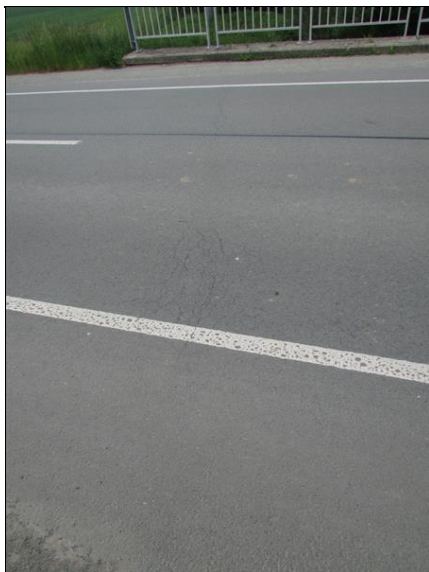
Trhliny ve vozovce v místě dilatace
