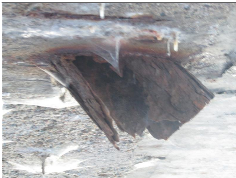
Zanesený a zarostlý odvodňovač
