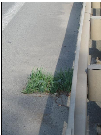
Zanesený a zarostlý odvodňovač
