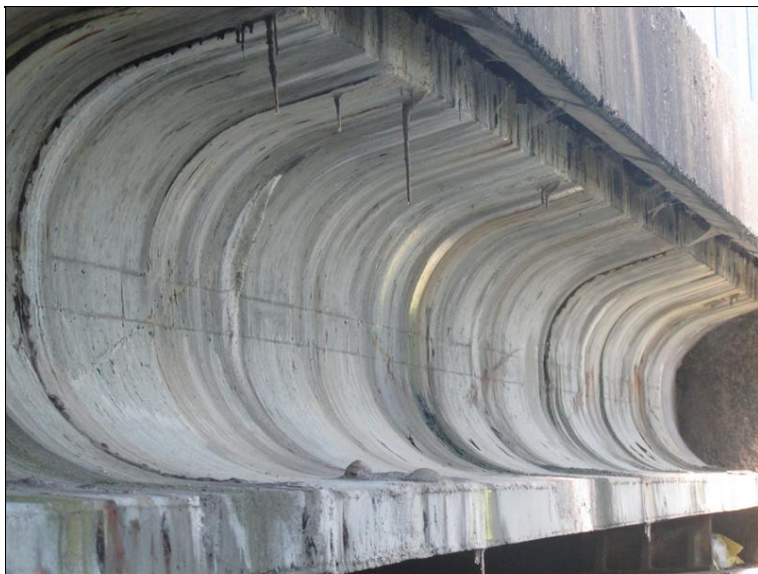
Levý krajní nosník -. silně potečený
