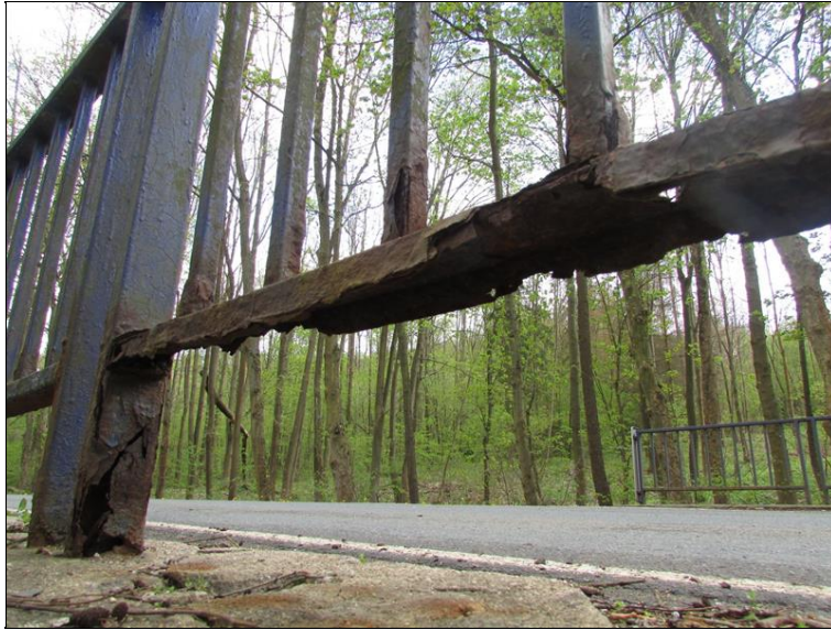
Velmi silná koroze zábradlí na levé straně
