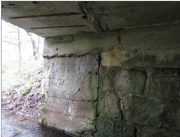
Dobetonávka opěry 2 vlevo
