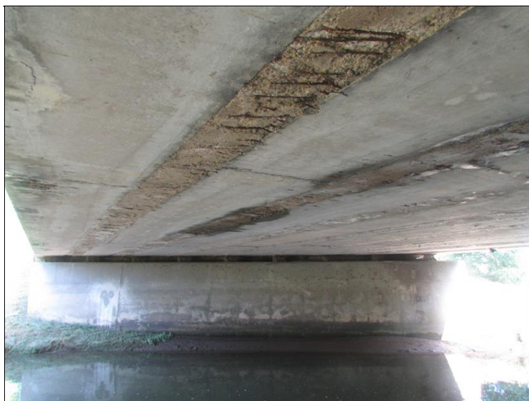
Zvlhlé a degradované dobetonávky mezi nosníky
