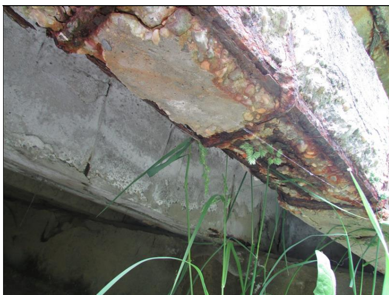
rozpad betonu NK a koroze nosné výztuže
