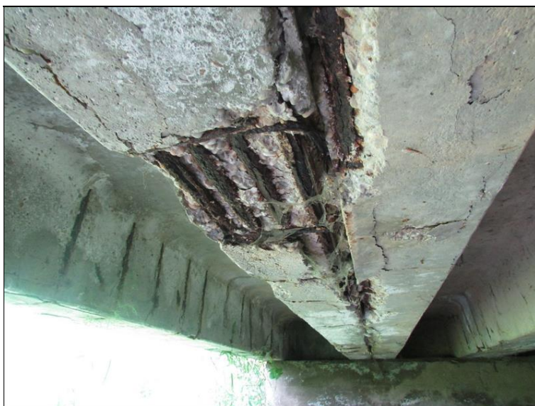
degradace betonu NK - odlupující se krycí vrstva betonu, koroze nosné výztuže
