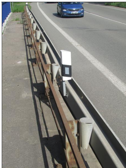
Koroze a deformace zádržného systému na pravé straně
