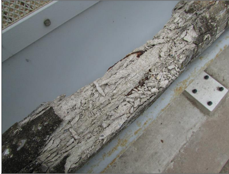
Vodorovná výplň zábradlí
