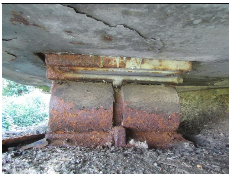
Koroze válcového ložiska
