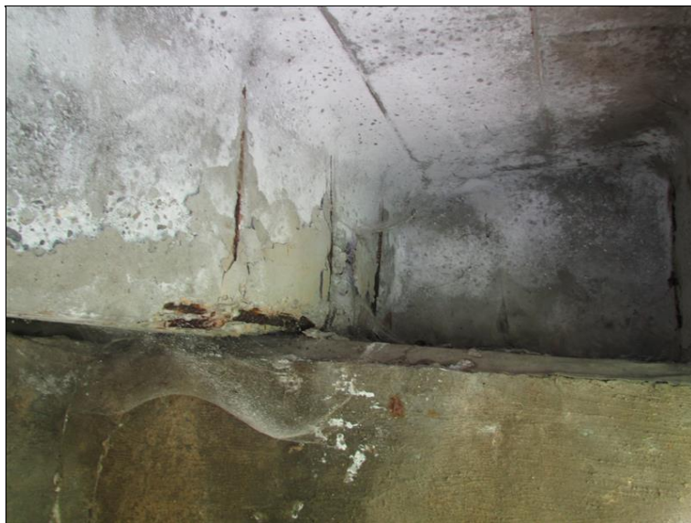
degradace betonu v místě uložení na ÚP a koroze výztuže
