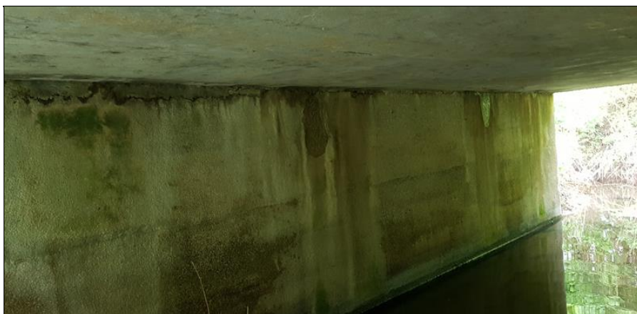
opěra 2 potečená přes uložení a nefunkční dilatace
