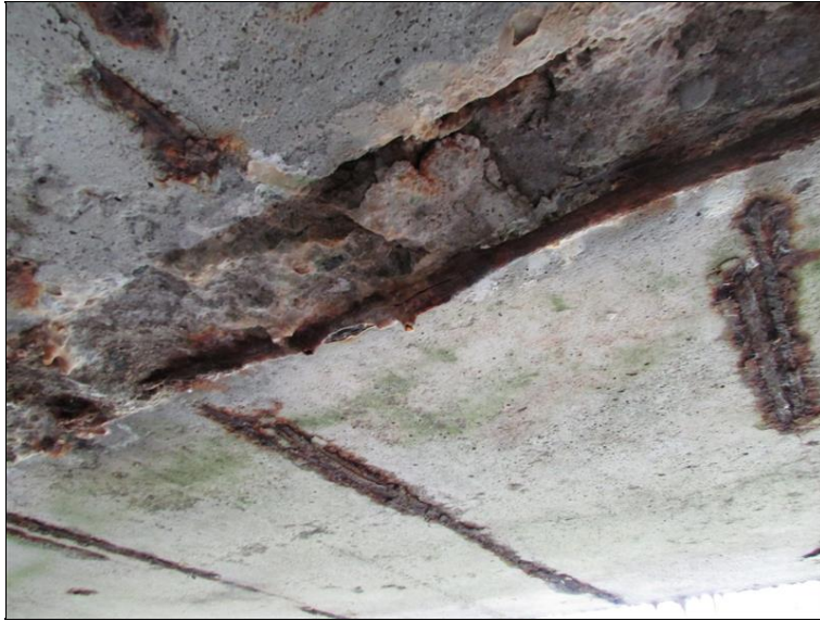
Zatékání skrz NK na pohledu NK
