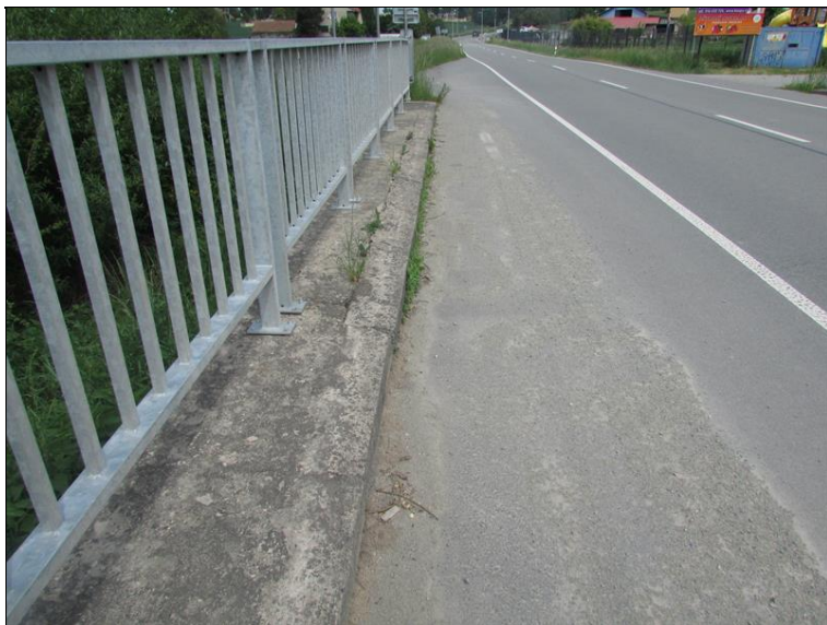
Pravá krajnice, degradovaný povrch betonové římsy
