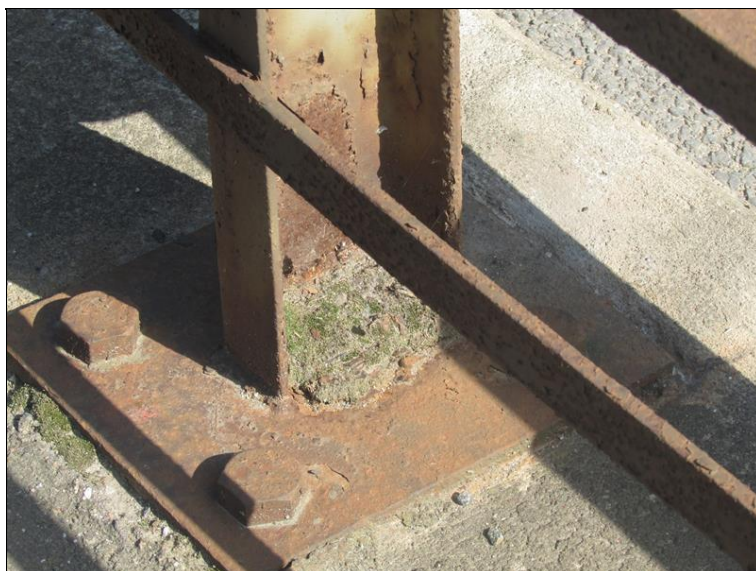
Koroze v patě svodidla
