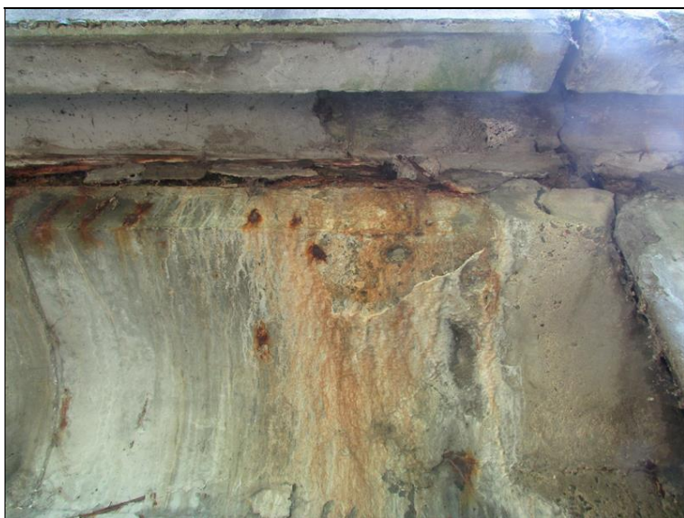
Silné zatékání z pod římsy na hlavní nosník
