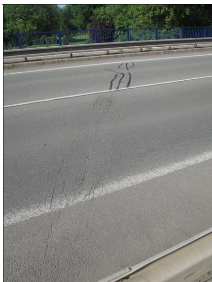
Trhlínky ve vozovce v místě dilatace nad OP1
