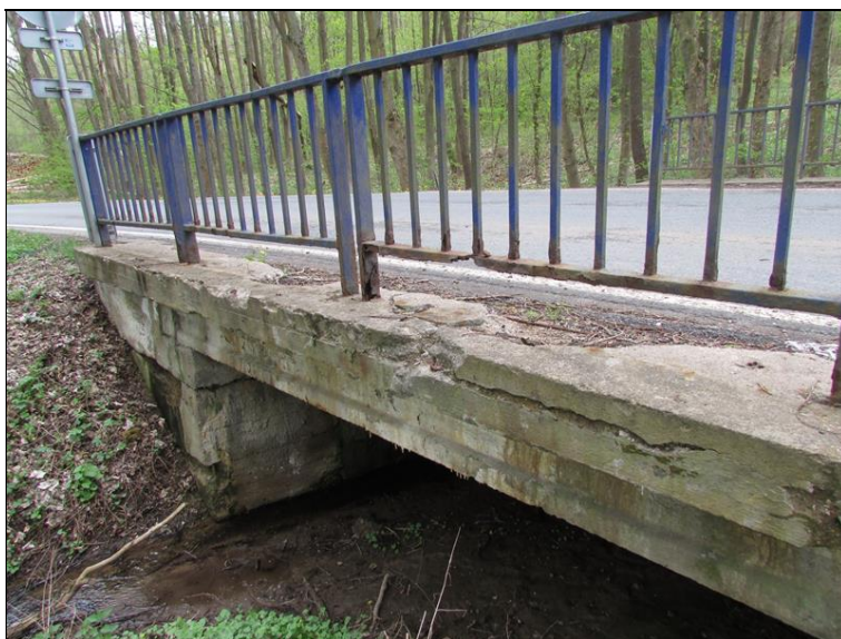
Celkový pohled na degradaci řimsy na levé straně
