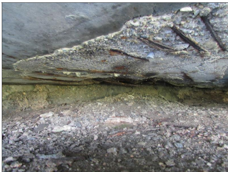
Stav dobetonávky mezi nosníky nad OP2
