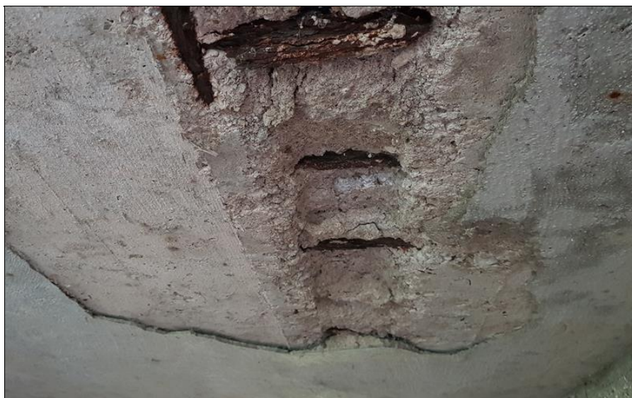
pod omítkou spodního líce NK koroze nosné výztuže
