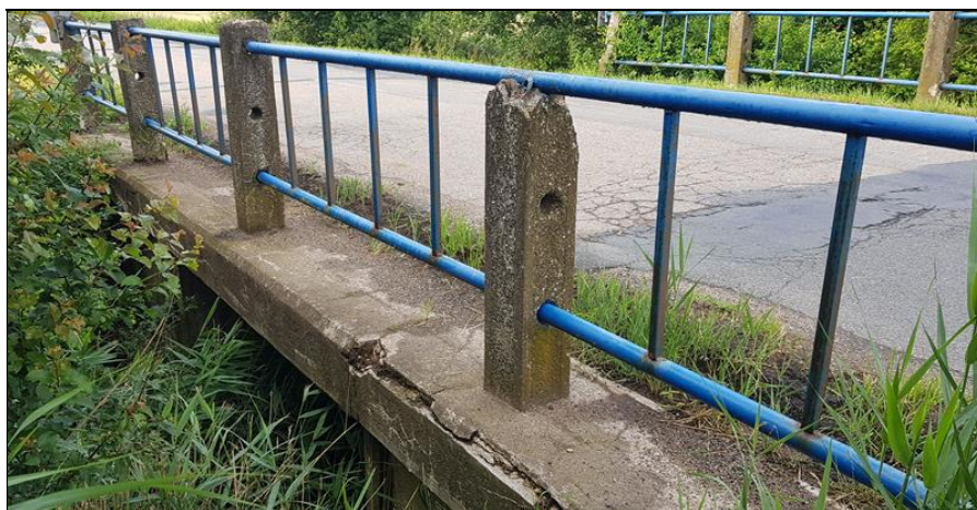
rozpadlý povrch říms, sloupky zábradlí hodně rozbité
