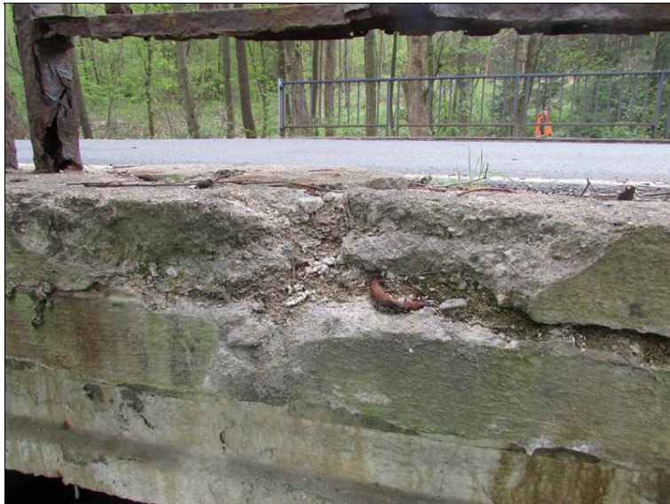
Rozpad řimsy na levé straně mostu
