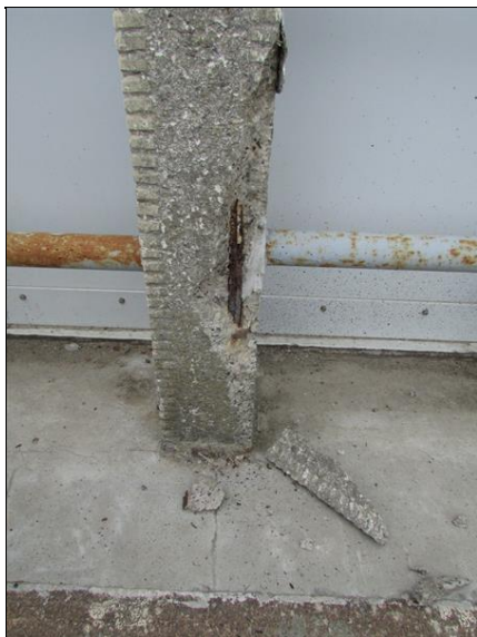
Degradace betonu slouku zábradlí
