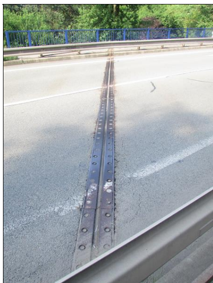
MA u OP2 - trhliny ve vozovce podél MZ
