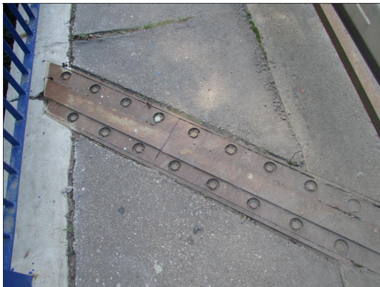
MA u OP2 - trhliny ve vozovce podél MZ
