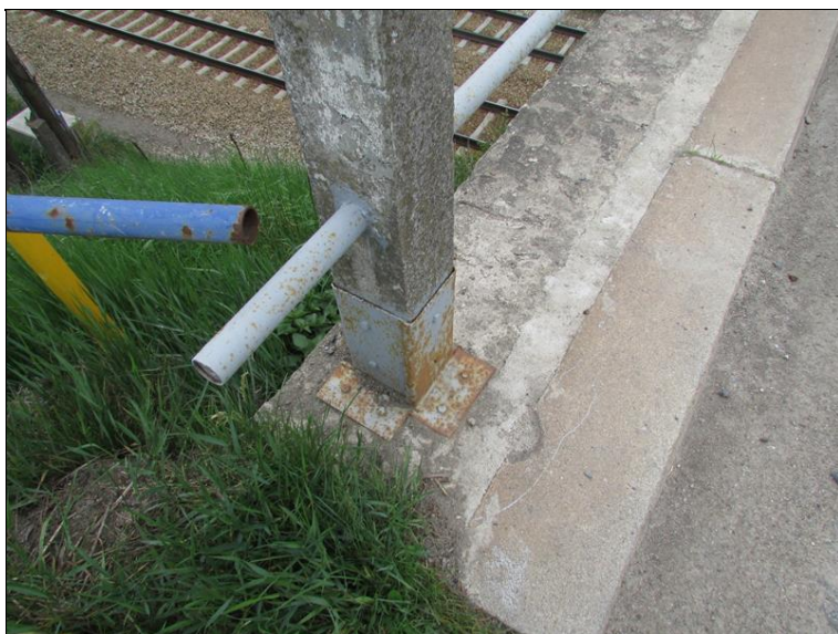
Zajištění kývajících se sloupků zábradlí
