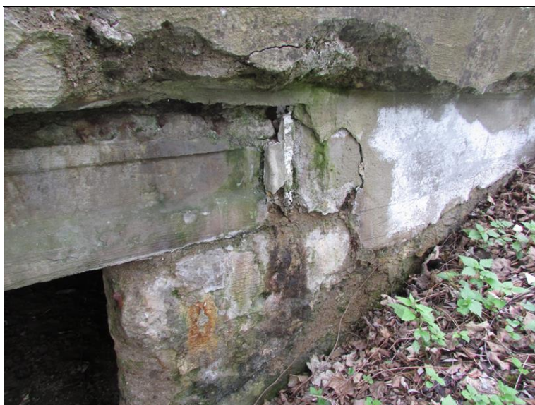
Detail uložení NK na OP1 vlevo
