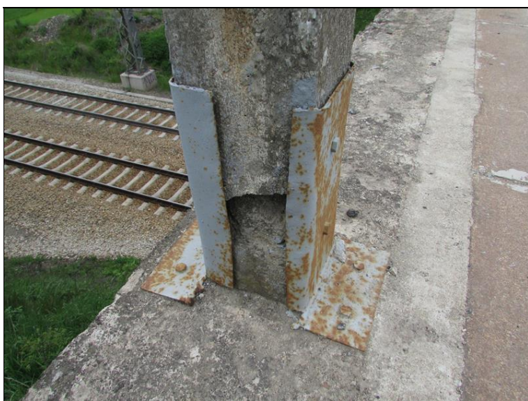
Způsob zajištění upadlých sloupků zábradlí
