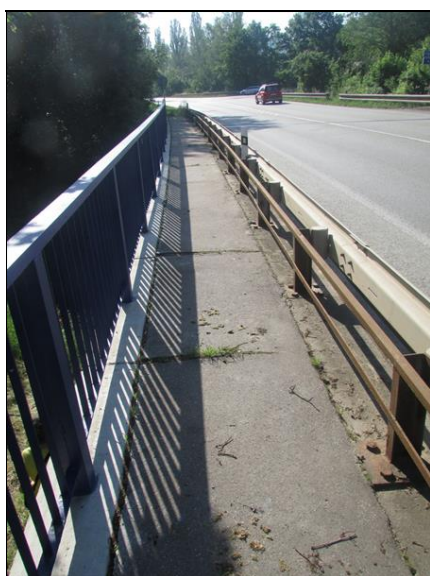
trhliny v pochozí vrstvě revizního chodníku s usazenou vegetací
