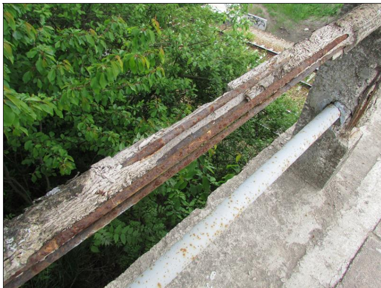
Rozpad výplně zábradlí
