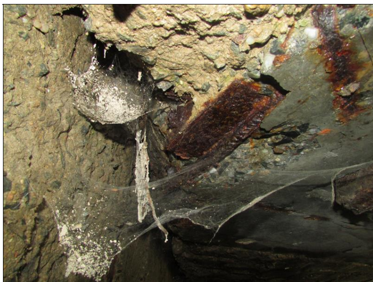
Obnažená korodující kotevní deska předpětí
