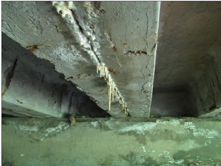
Stopy po zatékání mezi nosníky
