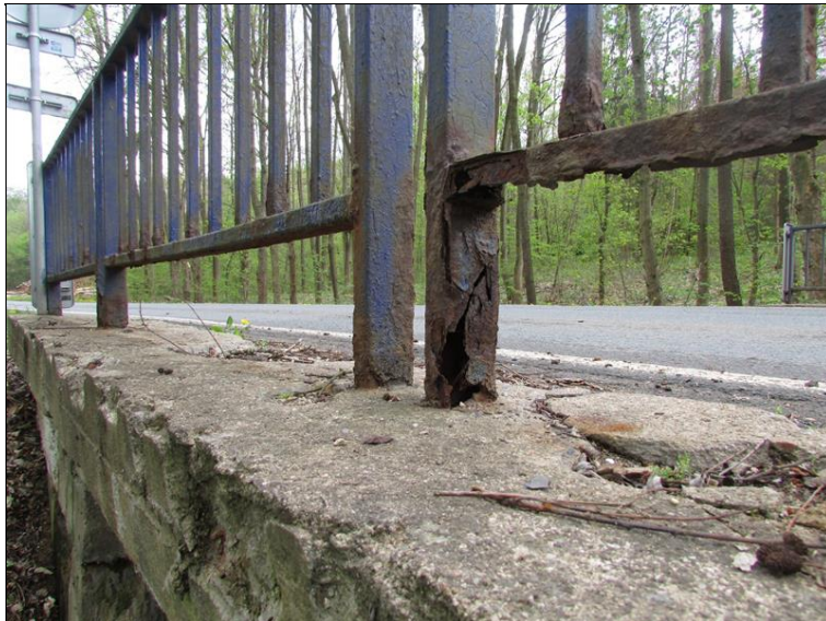
Zcela prokorodovaný sloupek zábradlí
