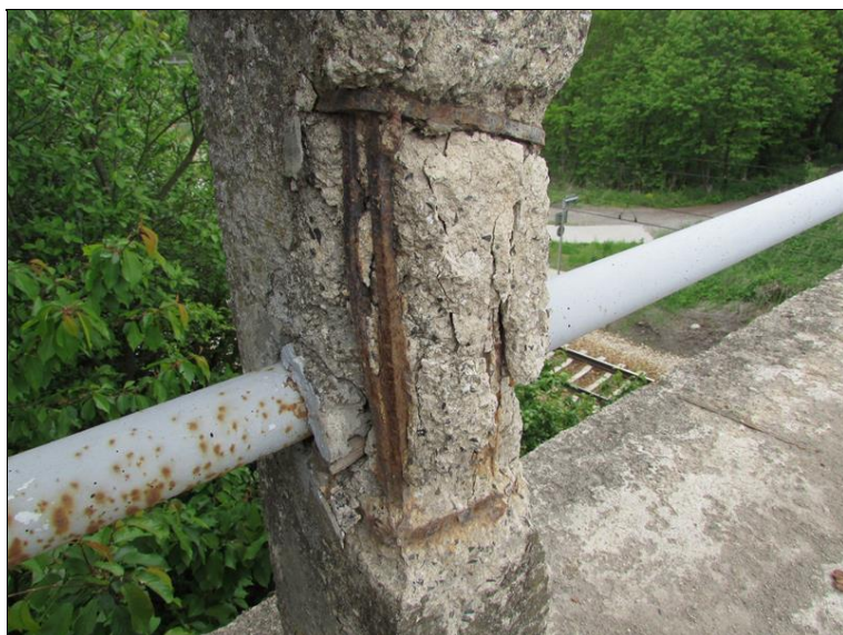
Degradace betonu sloupků zábradlí
