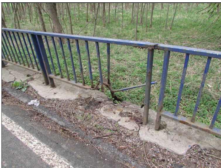
Výplň zábradlí po opření se o zábradlí - zcela ukorodované
