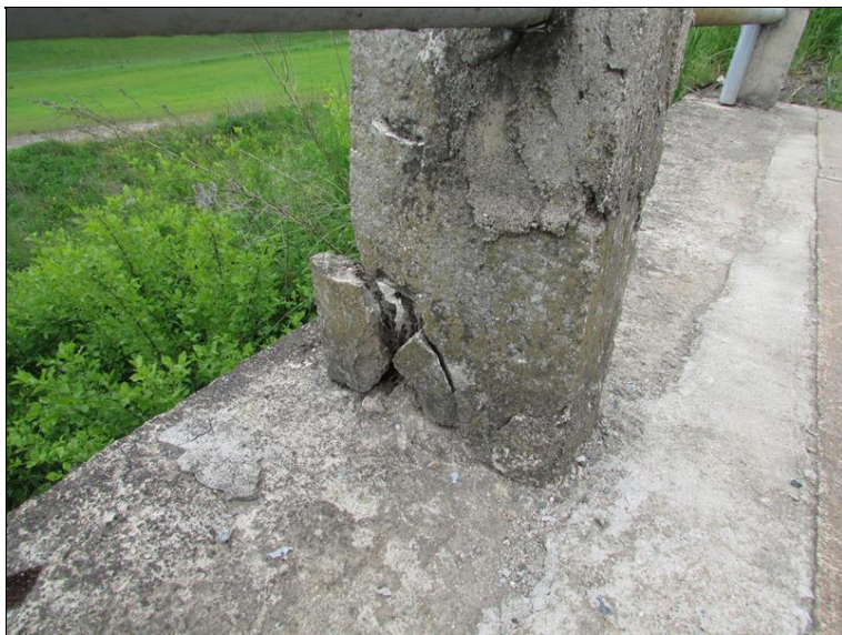
Degradace betonu v patě sloupku zábradlí
