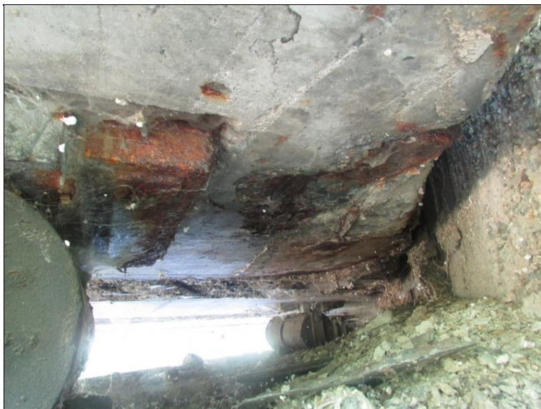
Pohled na nosník za osou uložení - koroze desky ložiska a obnažená korodující kotevní deska předpětí
