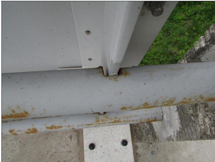
Úprava vodorovné výplně zábradlí v místě kolize se sloupkem protidotykové zábrany
