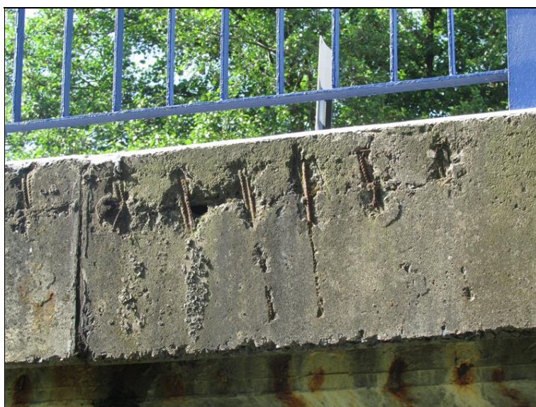
Degradace římsy s obnaženou korodující výztuží
