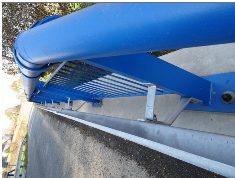
8.JPG Pohled na pravou (povodní) římsu s osazeným zábradelním mostním svodidlem ZMS4/H2.
