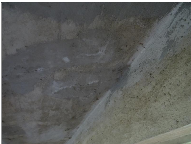
7c.JPG Podhled mostovky mezi 3. a 4. ŽB trámem blíže k Op1. Na podhledu jsou patrné stopy po zátocích do mostovky.
