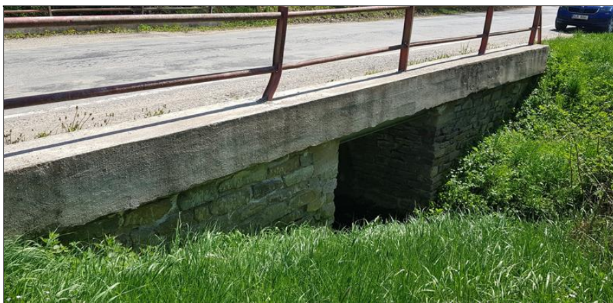
levá římsa a deformace zábradlí
