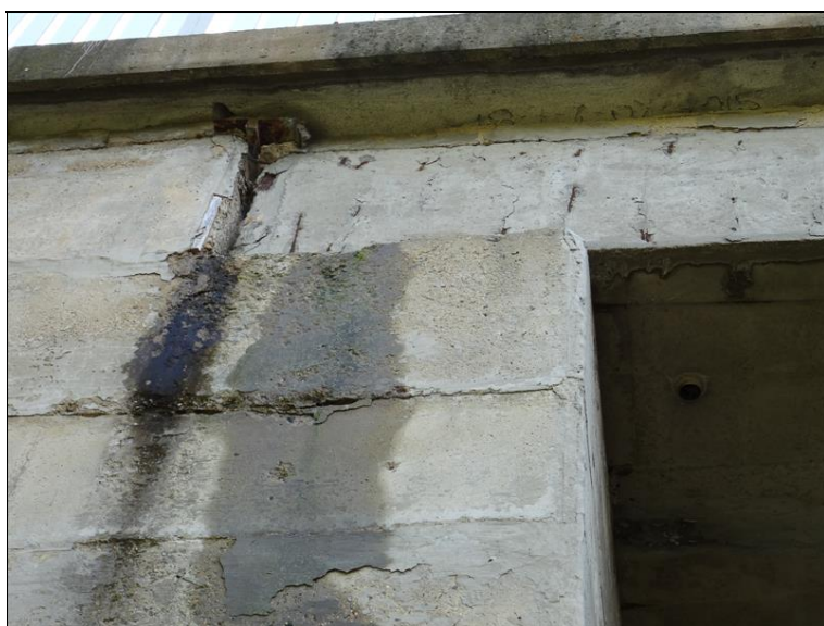
6.JPG Op1 zprava - detail zátoku dilatační spárou přes ulož. práh. Degradace betonu, obnažené a korodující těmínky krajního nosníku.
