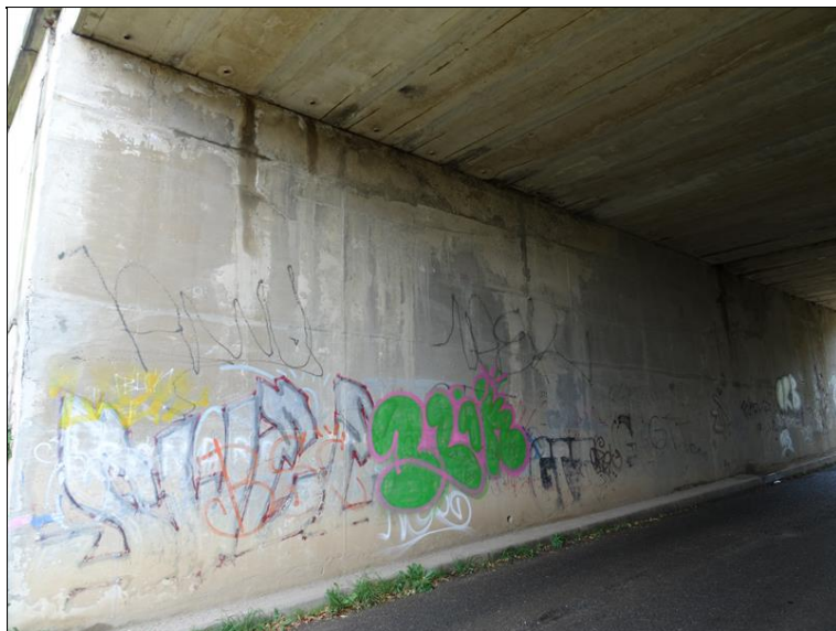
4.JPG Pohled na opěru 1 (Op1). Průsak na úložný práh, vápenné výluhy.
