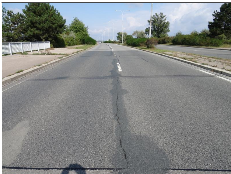
17.JPG Otevřeně široká trhlina ve středu vozovky za mostem. Na mostě v menším rozsahu.
