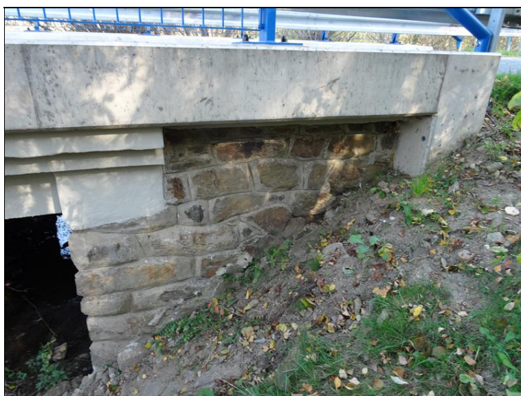
6b.JPG Pohled na povodní křídlo Op2. Na boční stěně koncového svahového sloupku římsy je ponechaný těsnící prvek spínací tyče bednění.
