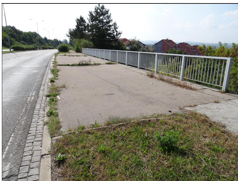
18.JPG Pravý chodník s trhlinami a uchycenou vegetací.
