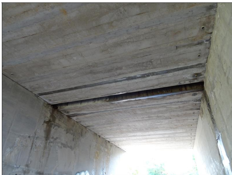
11.JPG Silný průsak vody levém kraji NK (pod středovou římsou).
