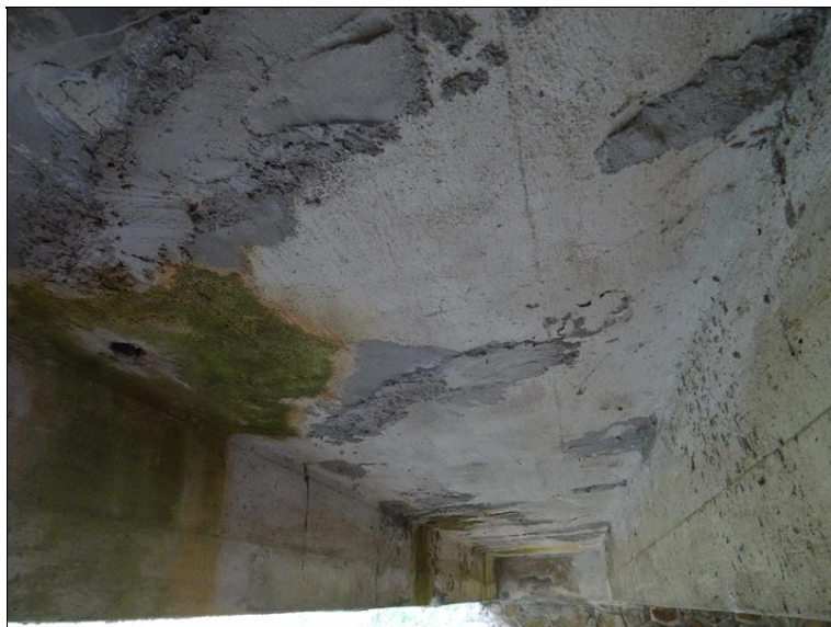
7a.JPG Podhled mostovky mezi 1. a 2. ŽB trámem u Op1 v pohledu směrem k Op2. Pohled na stav provedených sanačních oprav betonu.
