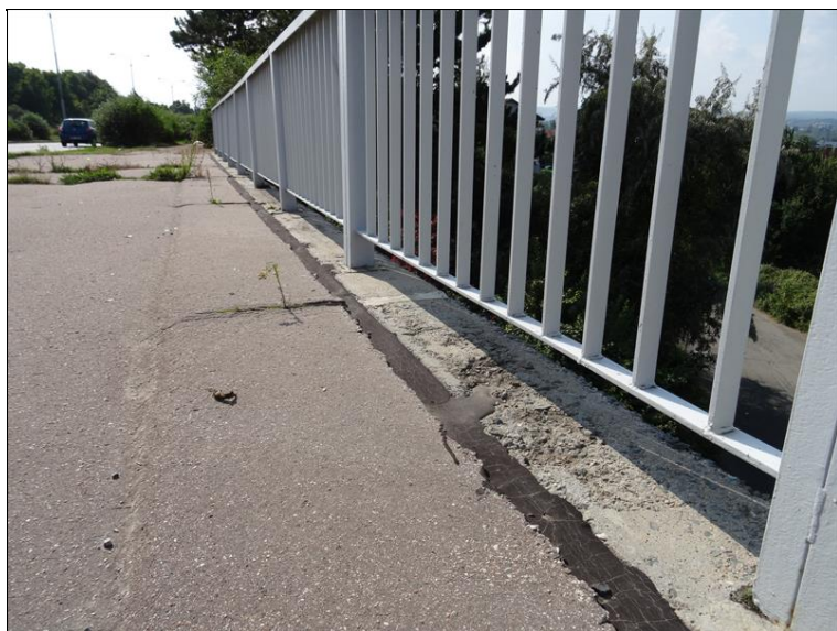
20.JPG Pravá římsa a zábradlí - degradace betonu římsy.
