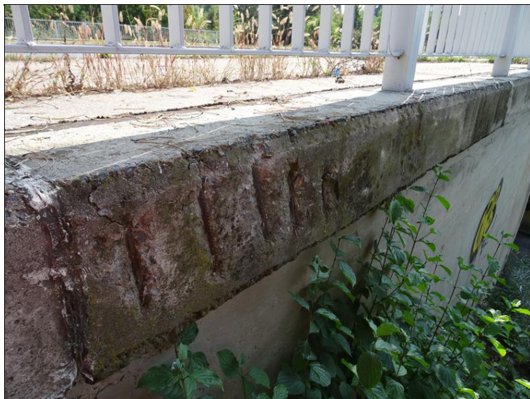
17.JPG Začátek pravé římsy - degradace betonu s obnaženou korodující výztuží.
