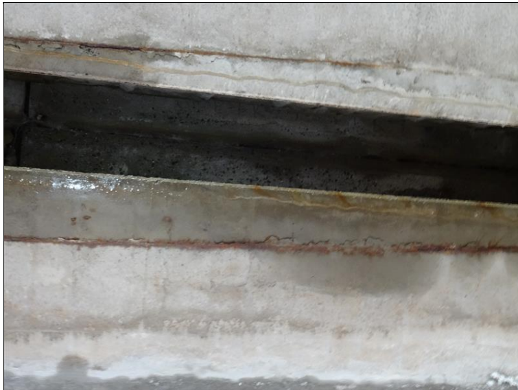
14.JPG Podhled NK v místě středového zrcadla. Silné zátoky přes překrytí zrcadla.
