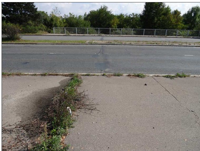
19.JPG Pravý chodník v místě nad Op1. Bujně zakořeněná vegetace v příčné spáře chodníku, vpravo v krytu chodníku otevřená příčná trhлина.
