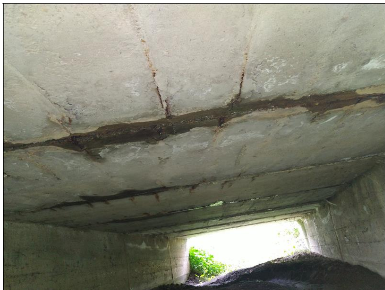
Podhled na NK, průsaky vody s výluhy v oblasti opěr, zejména na okrajích.jpg
