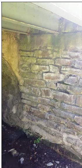
kamenné opěry v rozšíření
