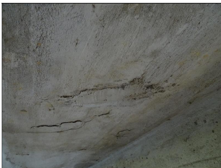
7d.JPG Podhled mostovky mezi 3. a 4. ŽB trámem blíže k Op2 v pohledu směrem k Op1. Lokální separace krycí vrstvy výztuže.
