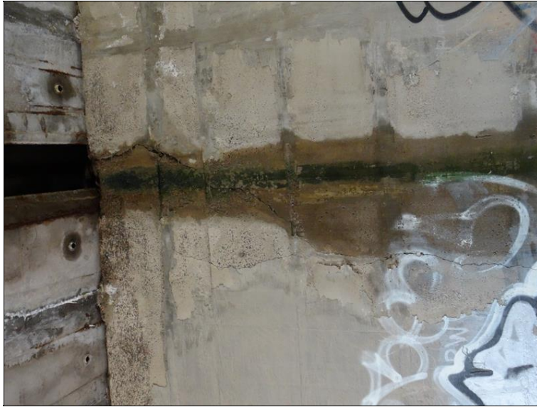
13.JPG Silný průsak vody mezi mosty, trhlina v Op2.
