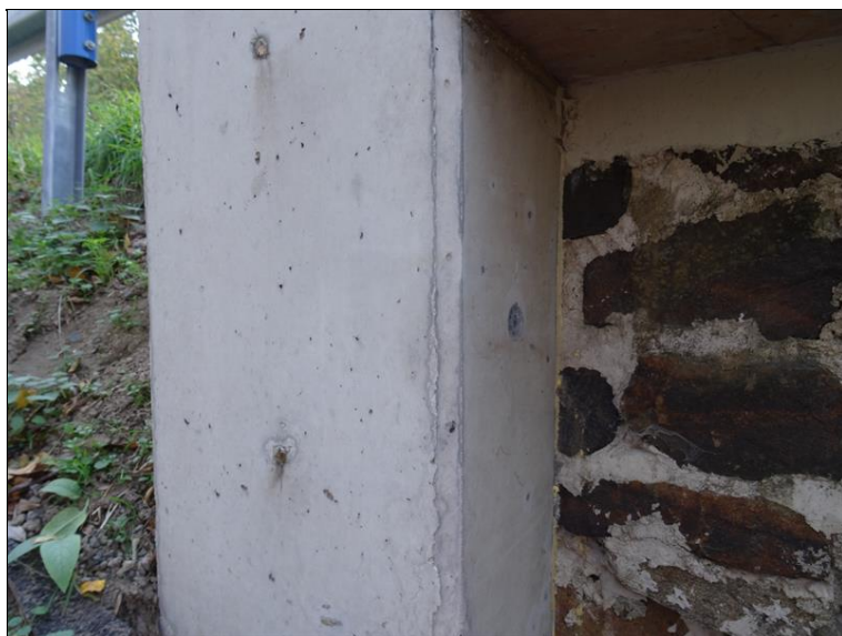
5c.JPG Pohled na nezapravené uřezané konce technol. výztuže na koncovém svahovém sloupku povodní římsy.
