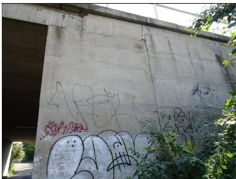
9.JPG Pravý bok Op1 s navazujícím křídlem. Trhlina v dilataci mezi Op a křídlem, degradace betonu.
