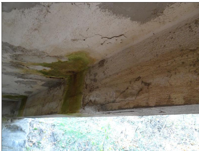
7.JPG Podhled NK mezi 1. a 2. ŽB trámem.(od návodní strany mostu) v pohledu směrem k Op1. Lokální separace krycí vrstvy výztuže na vnitřní dolní hraně 1. ŽB trámu a podhledu mostovky.
