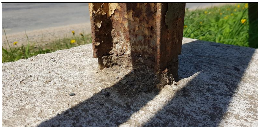
kotvení zábradlí !!!
