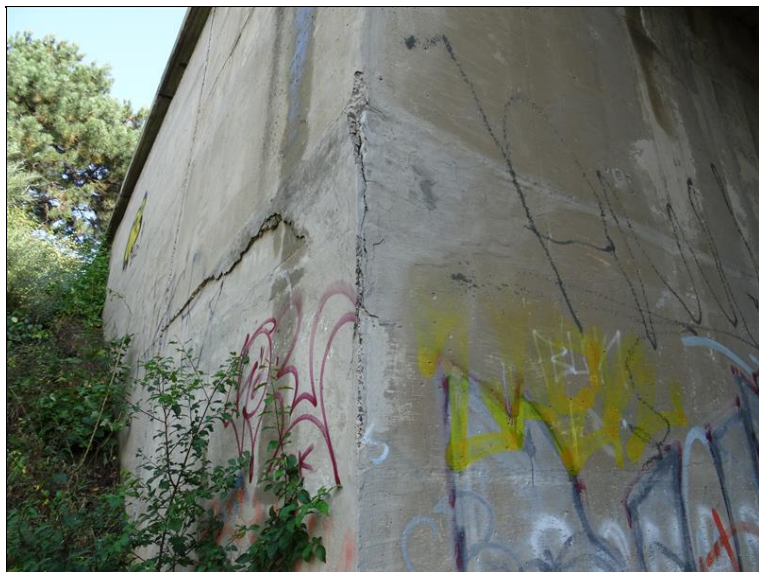
7.JPG Op1 zprava ve spodní části - opad reprofilační omítky, trhliny, degradace betonu.
