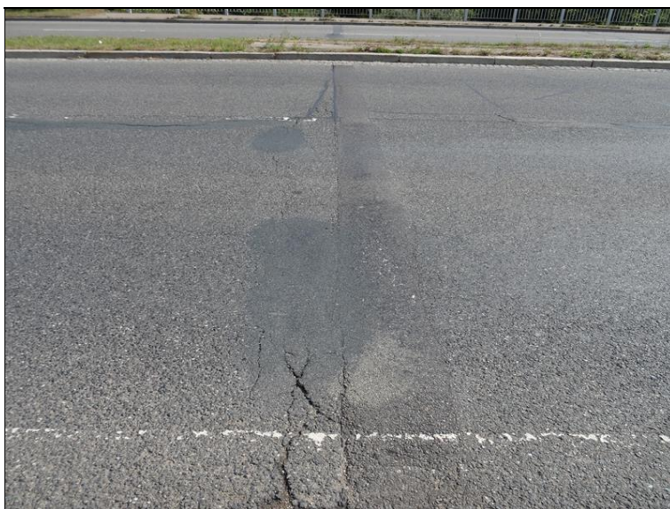
15.JPG EMZ na Op1. V oblasti kolem EMZ trhliny.
