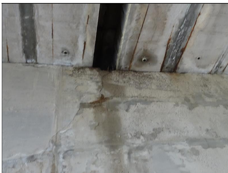
12.JPG Průsaky mezi mosty, trhlina v OP1.
