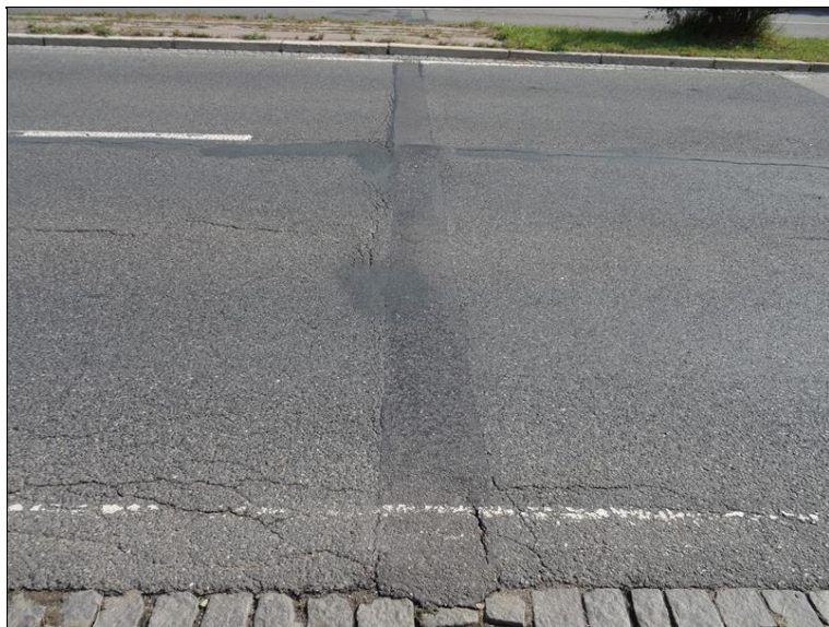
16.JPG EMZ na Op2. Trhliny v oblasti kolem EMZ., V krytu vozovky patrné i podélné rozvětvené trhliny.
