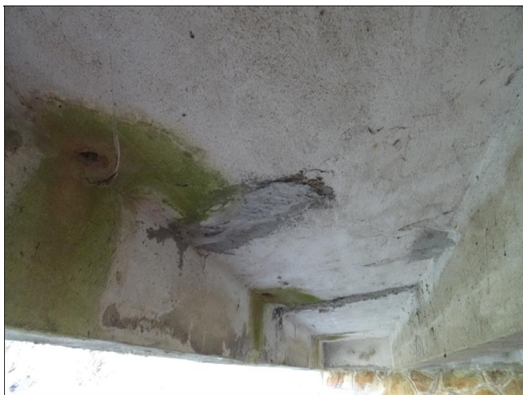
7d.JPG Podhled mostovky mezi 5. a 6. ŽB trámem v pohledu od Op2 směrem k Op1.
