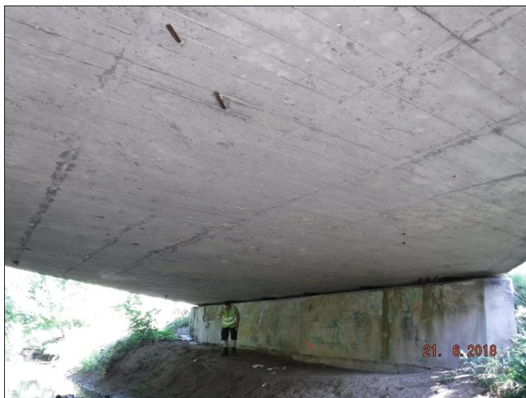
Podhled nosné konstrukce - lokální koroze obnažené výztuže.
