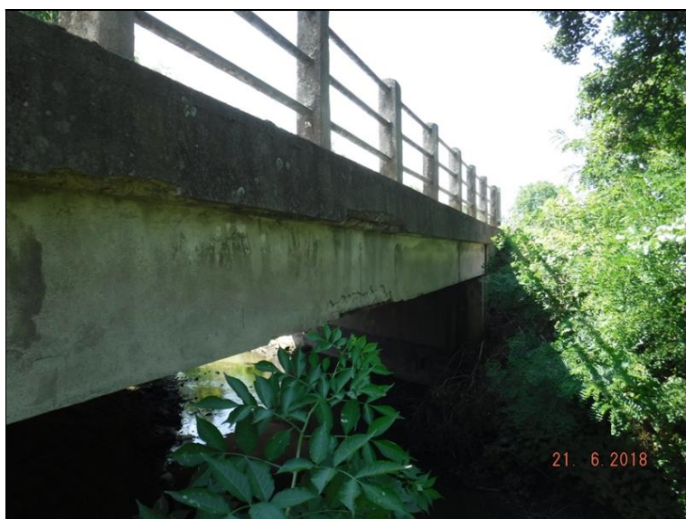
Pravá hrana nosné konstrukce - stopy po zatékání pod římsou na bok desky, degradace betonu, výluhy, mapy.
