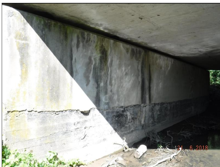
Pohled na opěru 02. Zatékání vody na líc opěry z úložného prahu a průsak vody z rubu opěry. Degradace povrchu omítky, mapy, trhliny, výluhy, odpadávání omítky. U paty opěry pravděpodobně obnažený, původně zasypaný líc opěry.
