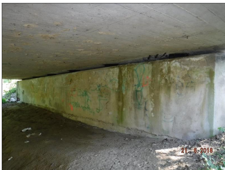
Pohled na opěru 01. Zatékání vody na líc opěry z úložného prahu a průsak vody z rubu opěry. Degradace povrchu omítky, mapy, trhliny, výluhy, odpadávání omítky.
