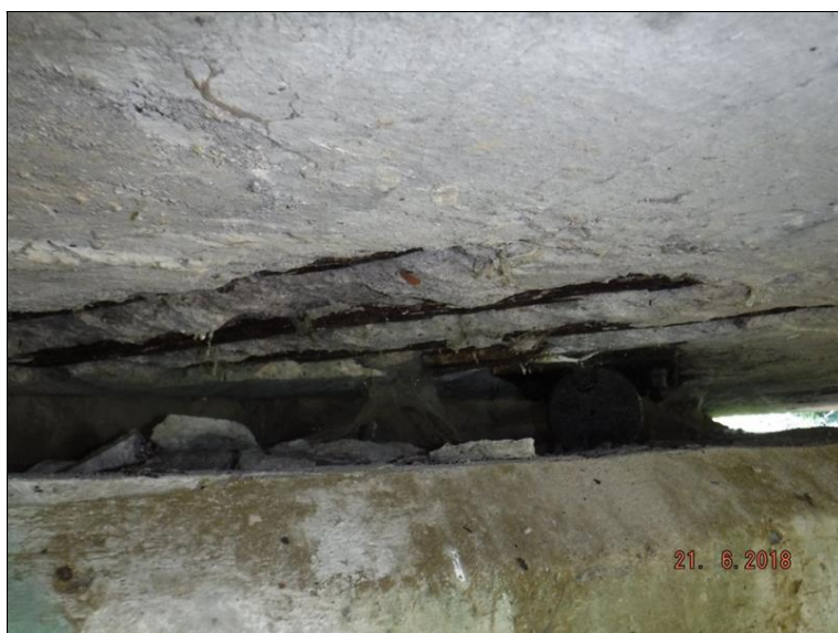
Detail lokální poruchy nosné konstrukce vlevo na opěře 01 - obnažená výztuž silně koroduje.
