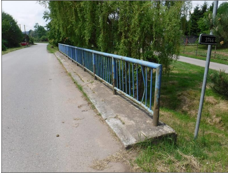
Koroze zábradlí
