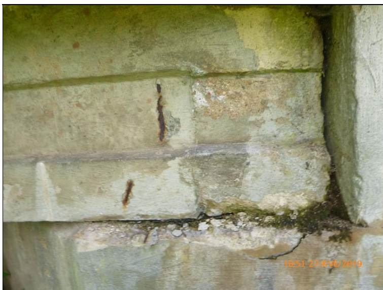
Přímé uložení NK na opěru
