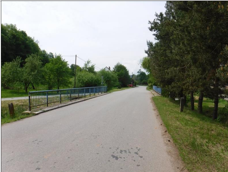
Pohled na most proti směru staničení
