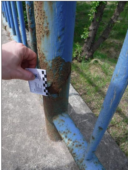
Koroze zábradlí
