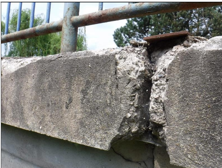
Dilatace v římse
