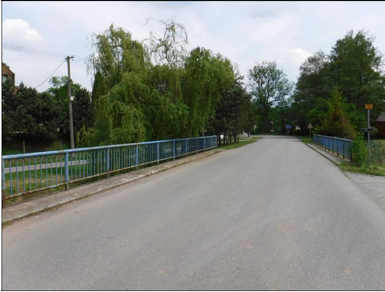
Pohled na most ve směru staničení
