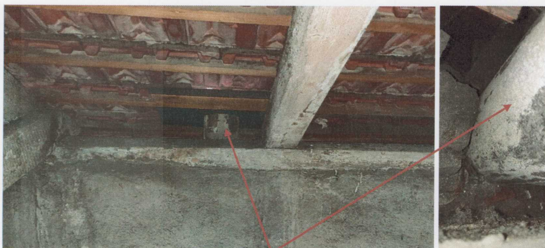
Odvětrávací kanalizační roura s obsahem azbestu (pohled z půdy)
