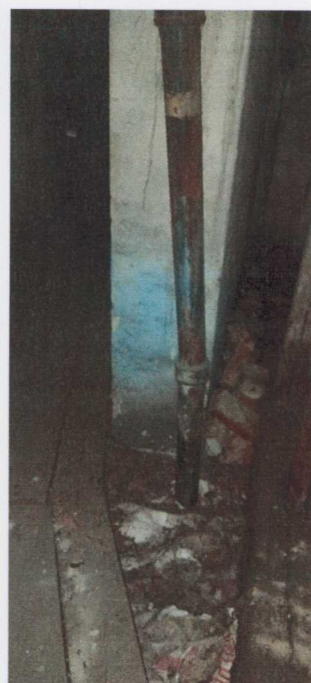
Pohled na odvětrání kanalizace v prostoru půdy
