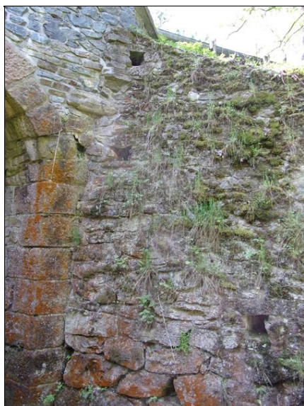
Pohled na levé křídlo OP1 - vydrolené spárování, usazená vegetace
