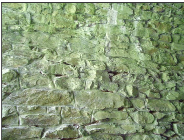
Pohled na lokálně porušené spárování zdiva opěr
