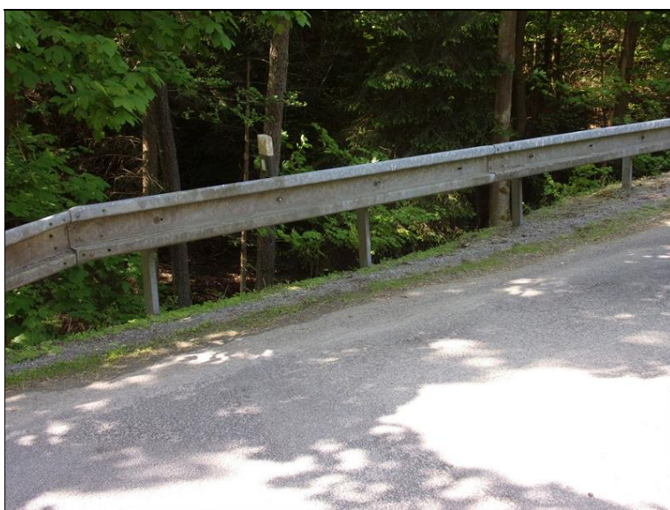
Výška svodnice na mostě 81 - 85 cm
