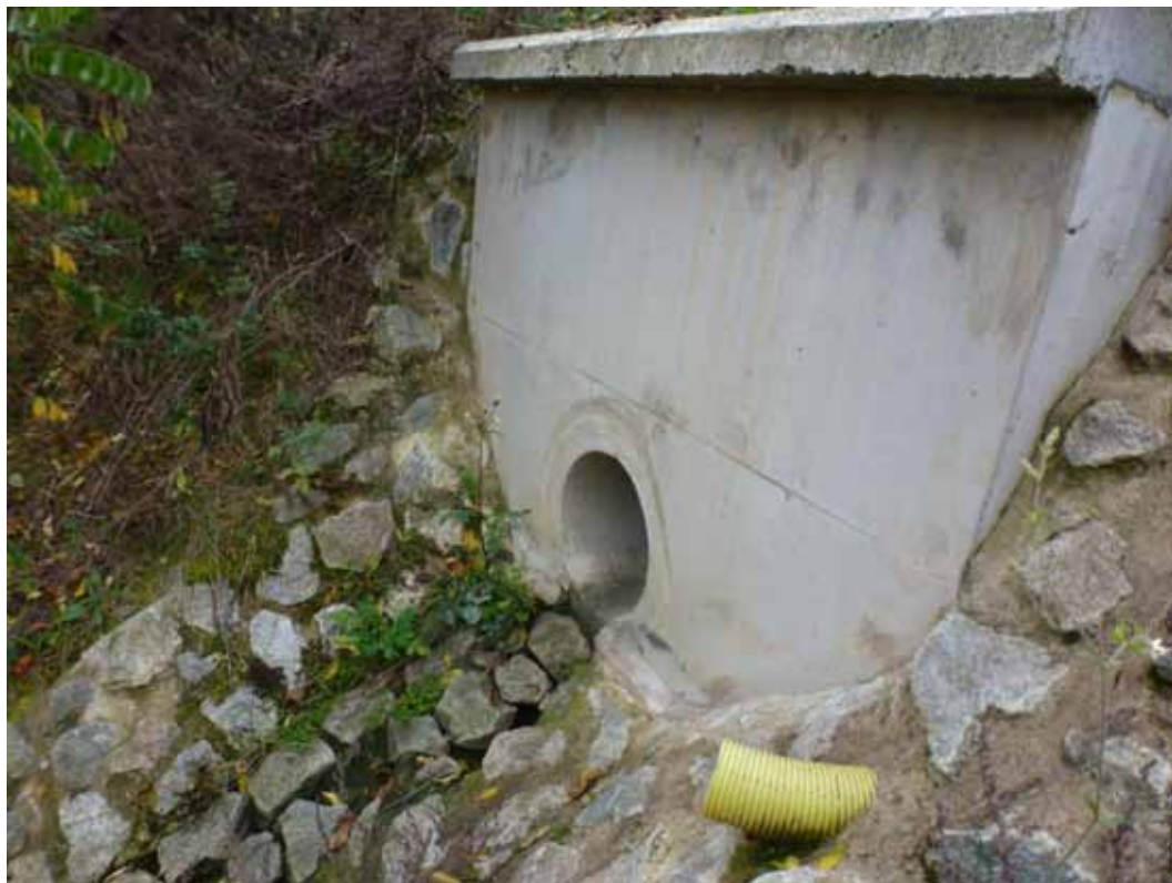
Obr. č. 1 – Vyústění propustku pod Hradištskou ulicí
