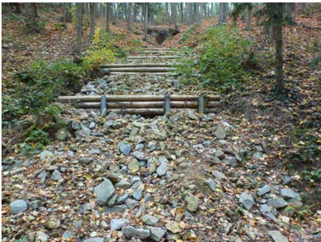
Obr. č. 6 – Sanace erozních jevů a zachycení sutě nad dnem Gránického údolí
