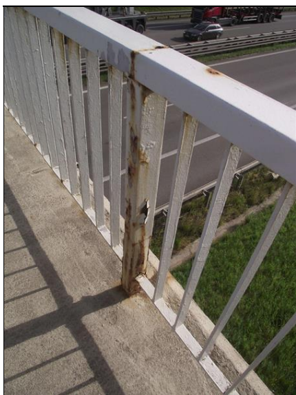
Zábradlí na mnoha místech koroduje, zejména sloupky.
