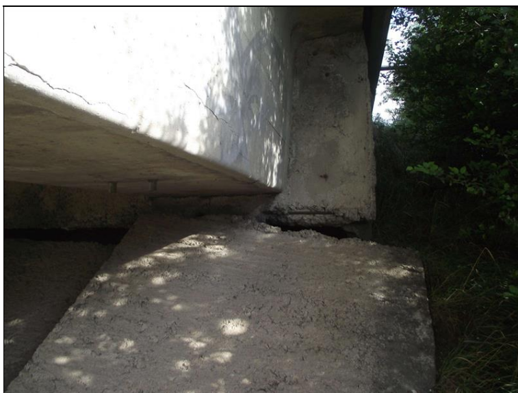
Rozvolněné betonové desky na svazích pod koncovými příčnicíky.
