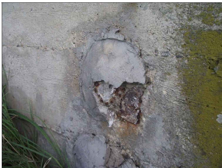
Způsob zapravení kotev předpínací výztuže na bocích koncových příčníků je nevhodný.
