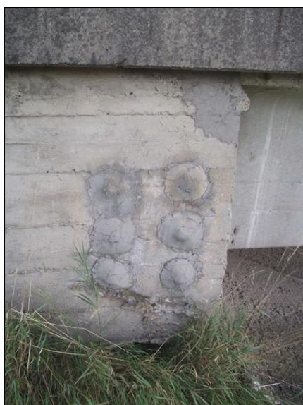
Způsob zapravení kotev předpínací výztuže na bocích koncových příčníků je nevhodný.
