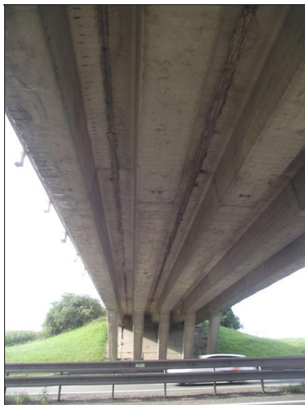
Obnažená korodující výztuž na mnoha místech pohledu NK.
