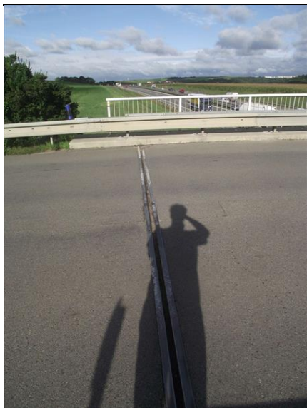
Mostní závěry jsou zanesené a povrchově korodují.
