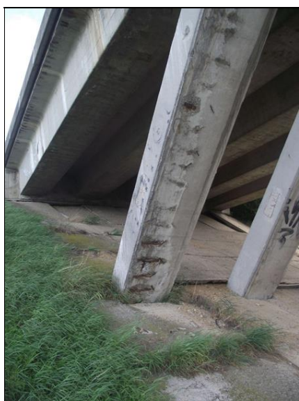
Zdegradovaný beton s obnaženou korodující výztuží krajních vzpěr pilíře P3.
