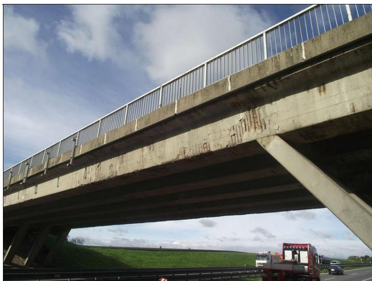
Silně zdegradovaný krajní nosník s obnaženou korodující výztuží (pravá strana).
