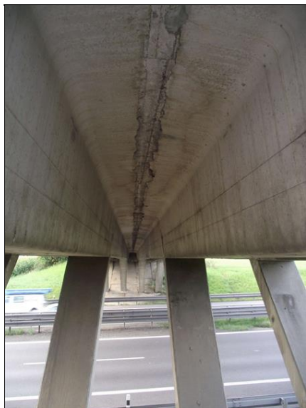
Pohled na spáru mezi nosníky.
