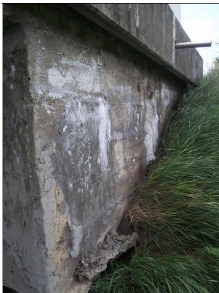
Degradace betonu na koncových příčnicích, vápenné výluhy a inkrustace.
