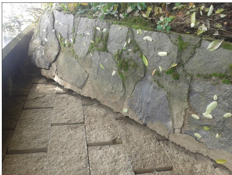
11. Odláždění křídla odtržené od křídla.jpg
