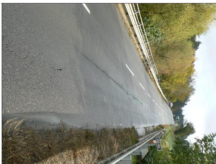
8. Podelná trhlina ve vozovce.jpg
