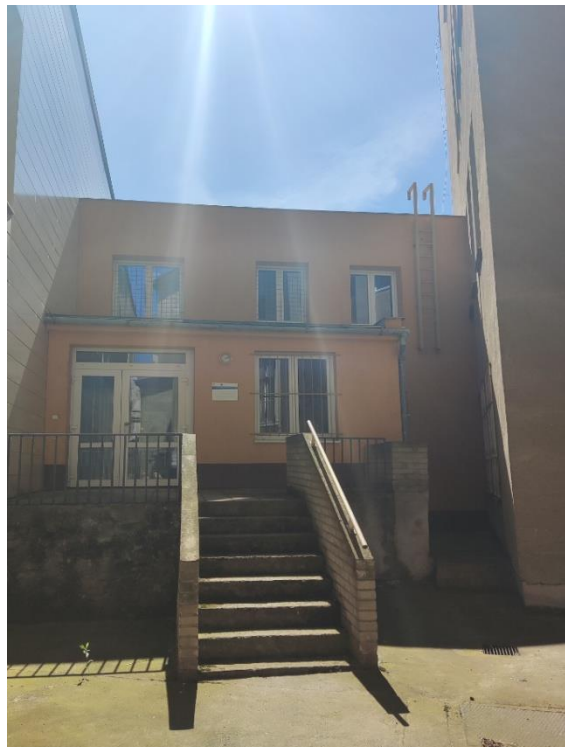
Východní fasáda spojovacího objektu
