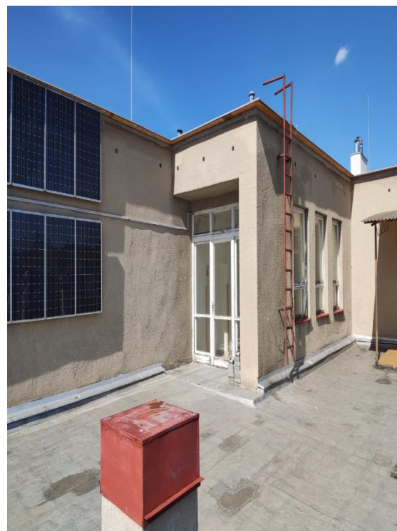
Jižní fasáda terasy přístavby
