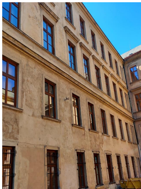
Východní fasáda západního křídla hlavní budovy
