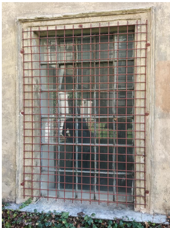
Ocelové okno 1PP na západní fasádě školního dvora
