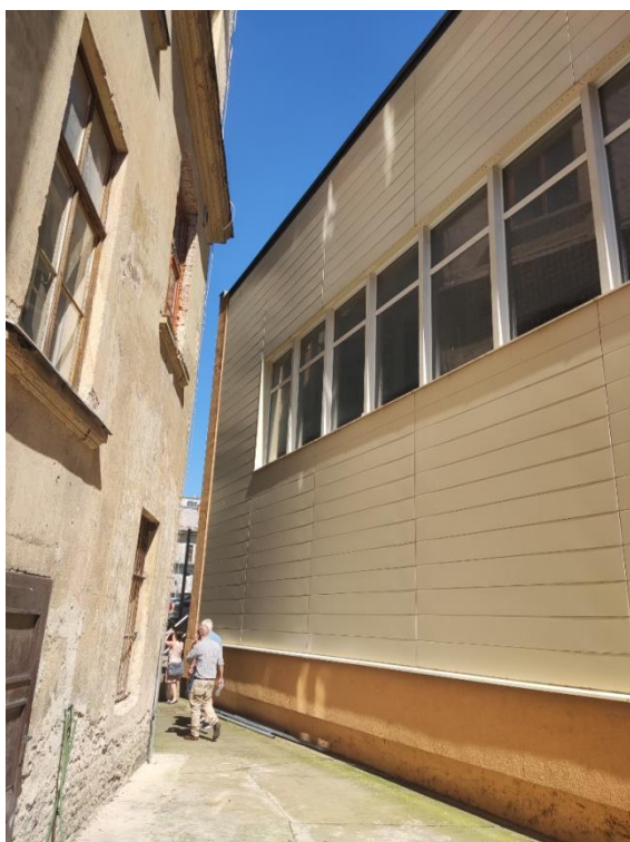
Jižní fasáda přístavby a severní fasáda tělocvičny
