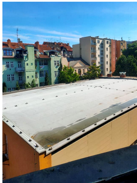
Plochá střecha tělocvičny
