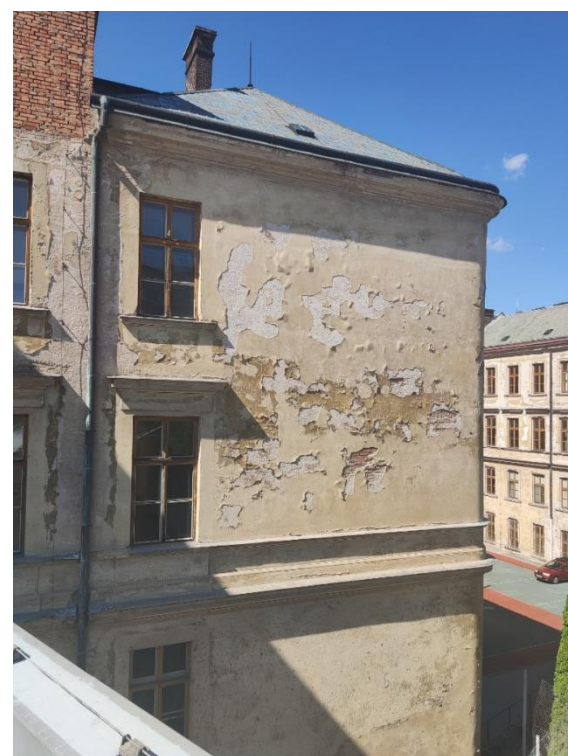
Jižní fasáda západního křídla hlavní budovy
