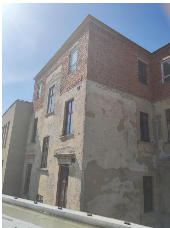
Jižní a východní fasáda přístavby
