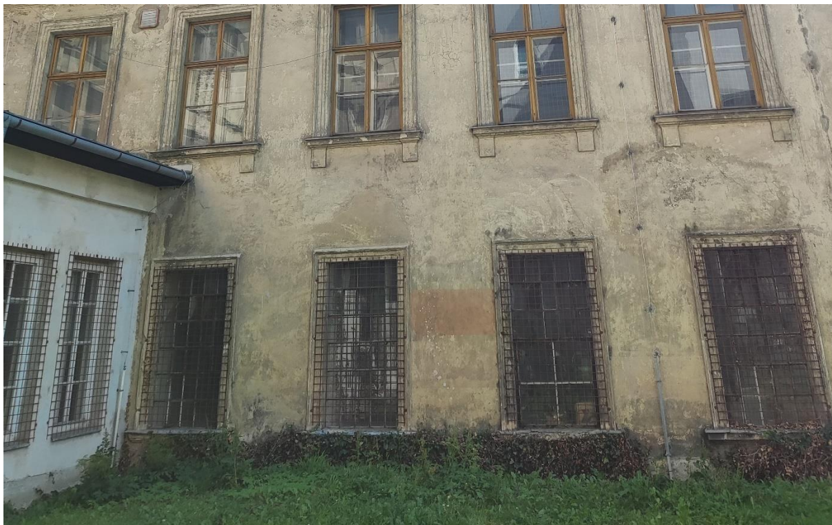
Obr. č. 15 Stávající stav - čtyři ocelová okna z místnosti 155
