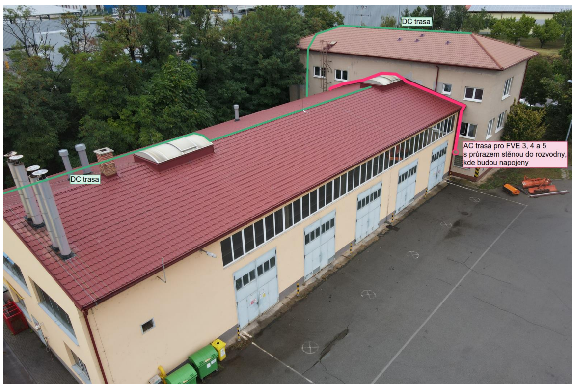
Obr. č. 8.1.6: Kabelové trasy - budovy č. 3, 4 a 5
