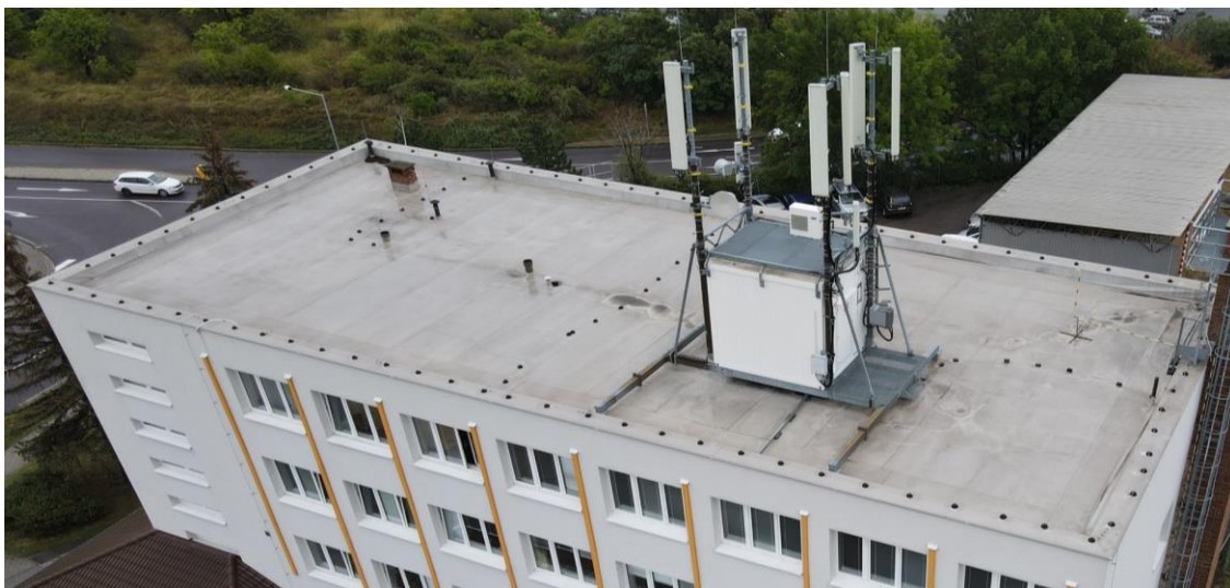
Obr. č. 4.1.3: Pohled na střešní konstrukci - budova č. 1
