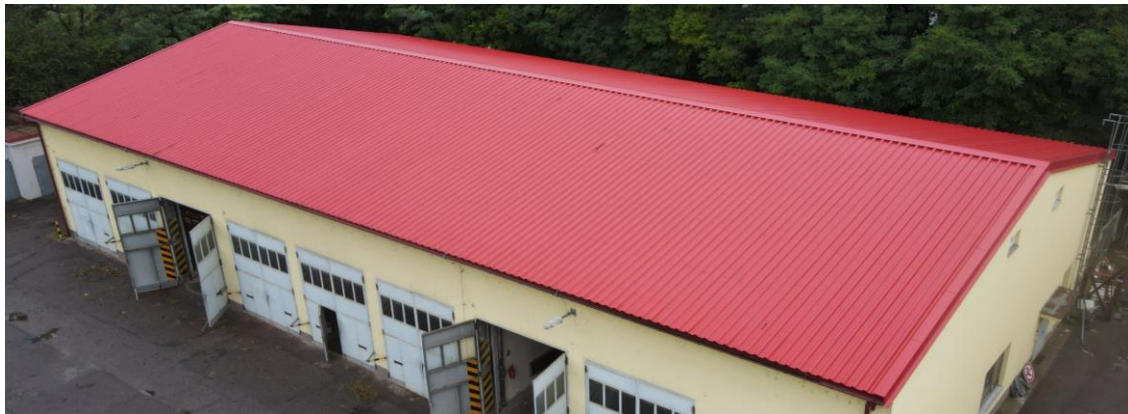
Obr. č. 4.1.8: Pohled na střešní konstrukci - budova č. 6
