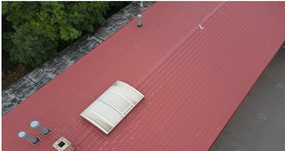
Obr. č. 4.1.6: Pohled na střešní konstrukci - budova č. 4
