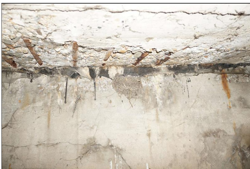
Detail uložení NK u opěry OP2. Odpadávající vrstvy betonu až na nosnou výztuž, která koroduje. Nekvalitní beton.
