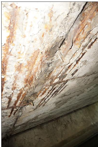
Detail pohledu nosné konstrukce. Velké plochy odpadávající vrstvy betonu až na nosnou výztuž, která koroduje.
