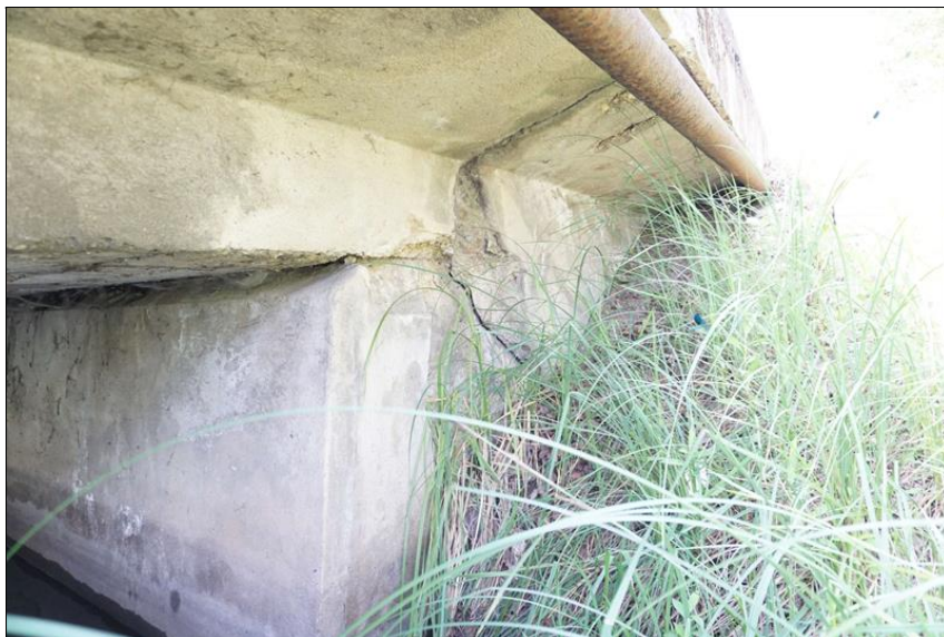
Detail levé strany NK u opěry OP1. Trhlina v křídle, rozpad mezery mezi NK a křídlem.
