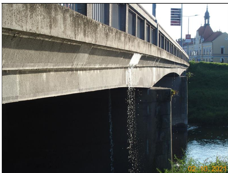
Průsaky z dilatačních spár po celé délce pravého boku mostu v průběhu havárie vodovodu
