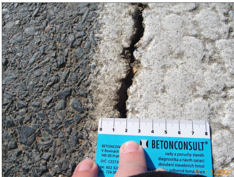
Podélná trhlina ve vozovce v 1. poli
