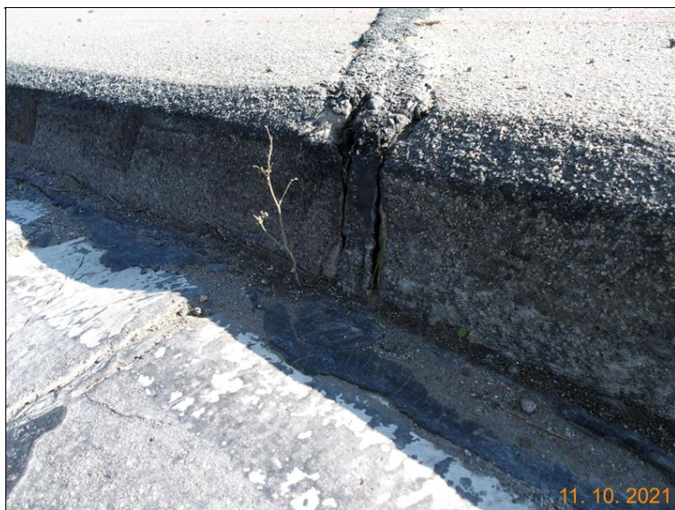
Dilatační spára chodníku nad OP1 vlevo
