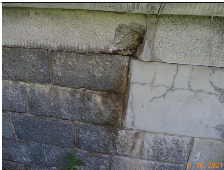
Zamáčení uložení NK na OP1 vpravo
