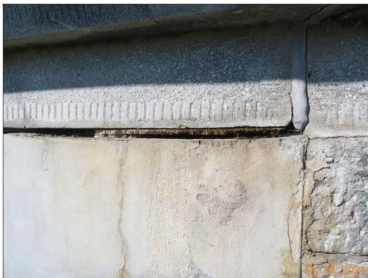
Zamáčení uložení NK na OP1 vlevo
