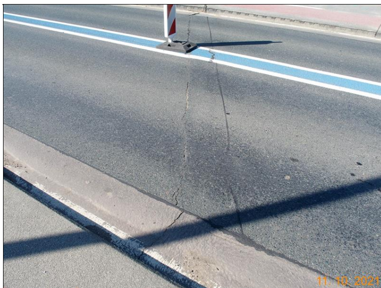
Dilatační spára vozovky nad OP4
