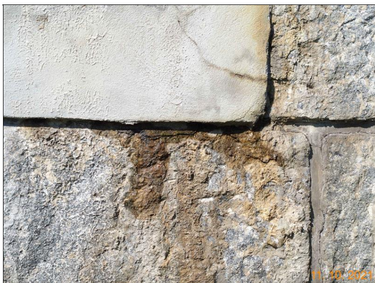
Zamáčení uložení NK na OP1 vlevo
