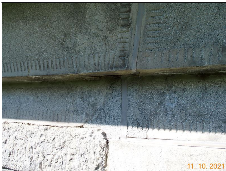
Zatmelení dilatačních spár římsy a NK vlevo na OP4
