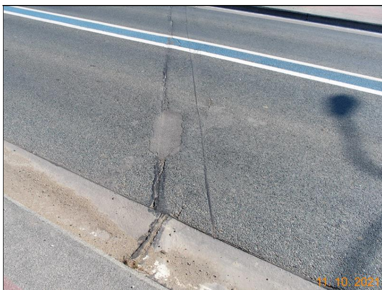
Dilatační spára vozovky nad OP1
