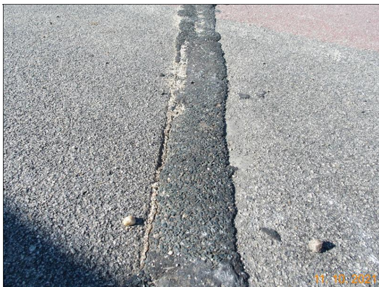
Dilatační spára chodníku nad OP1 vlevo
