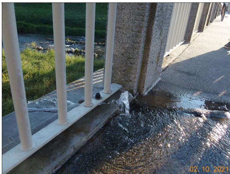
Tlakový průsak z dilatační spáry v chodníku na OP1 vlevo v průběhu havárie vodovodu
