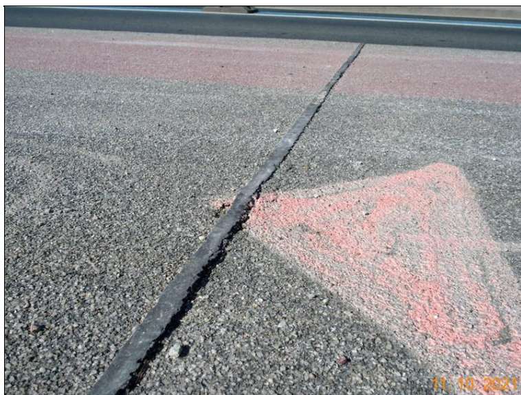
Dilatační spára levé římsy - odtržená záливka
