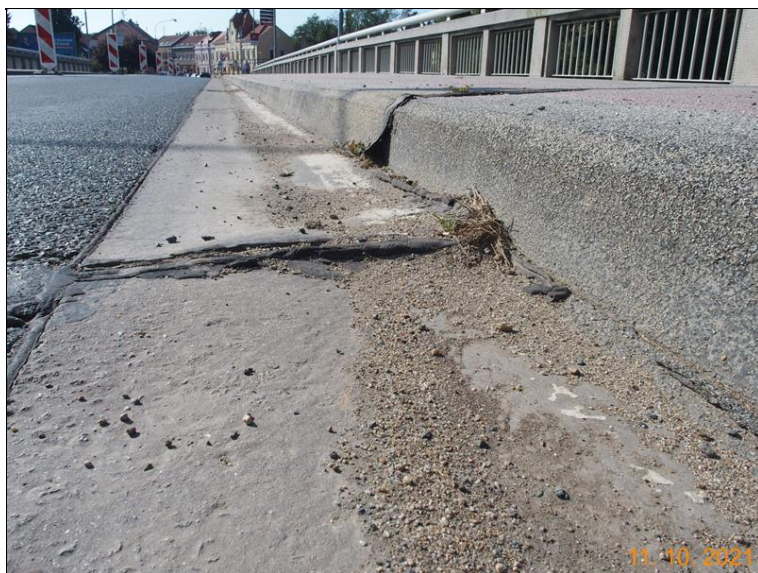
Dilatační spára vozovky nad OP1 vpravo
