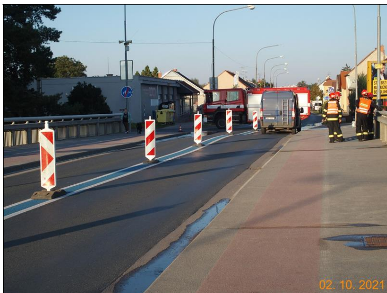
Vydatí vozovky v 1. poli v průběhu havárie vodovodu
