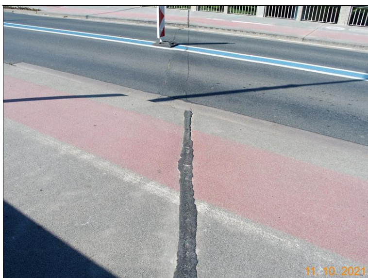
Dilatační spára vozovky nad OP4
