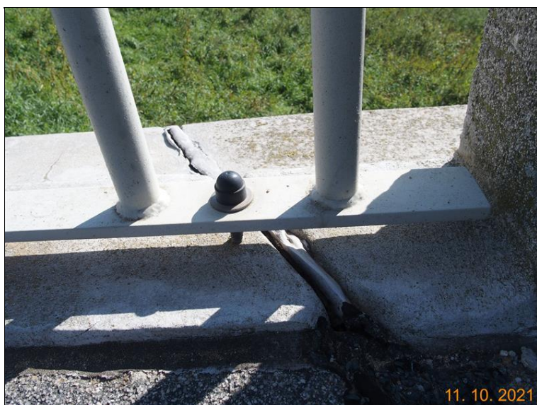
Poškození těsnění dilatační spáry na OP1 vlevo z horní strany
