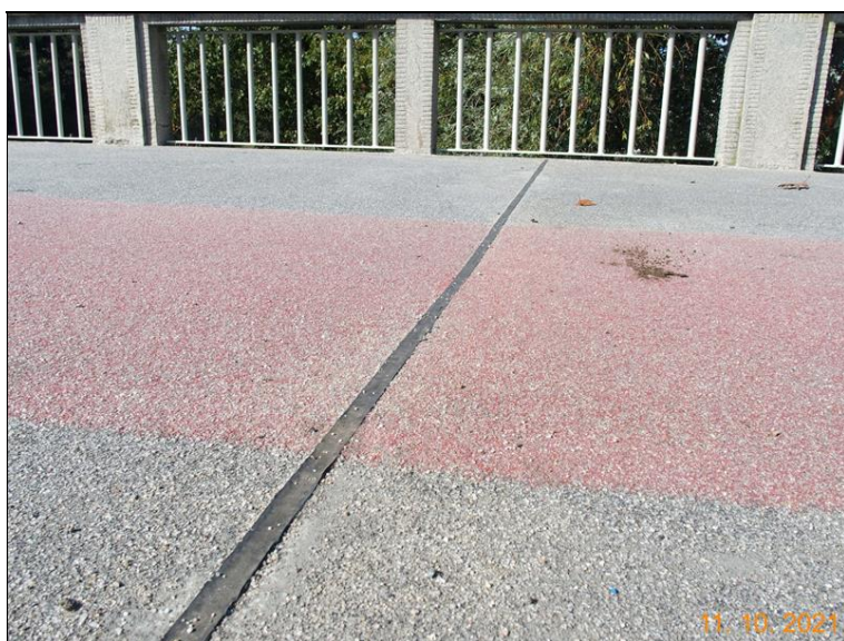
Dilatační spára pravé římsy
