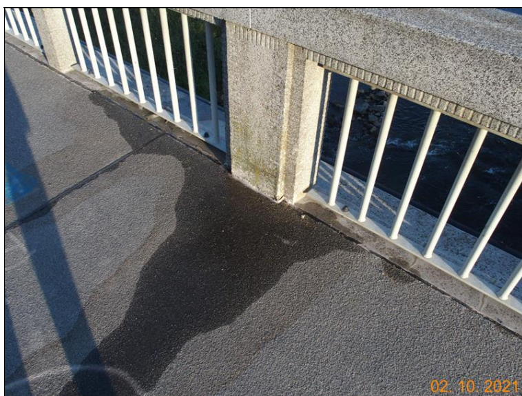
Průsak ze spáry mezi chodníkem a pravou římsou v průběhu havárie vodovodu
