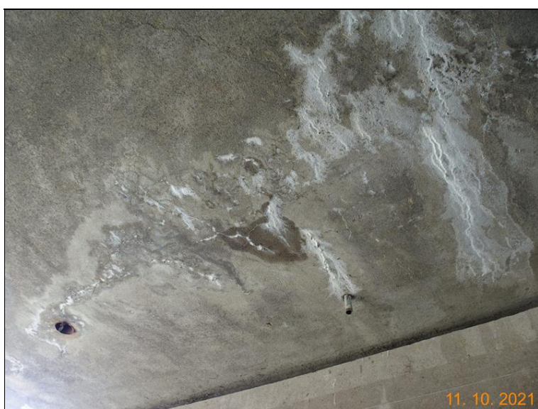
Podhled nosné konstrukce - 1. pole, zvodnělé trhliny u PI2
