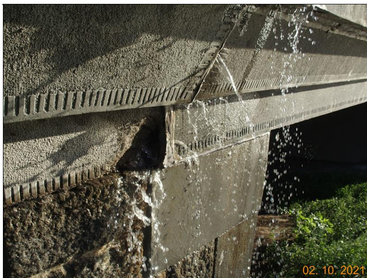
Tlakový průsak z boku dilatační spáry na OP1 vpravo v průběhu havárie vodovodu
