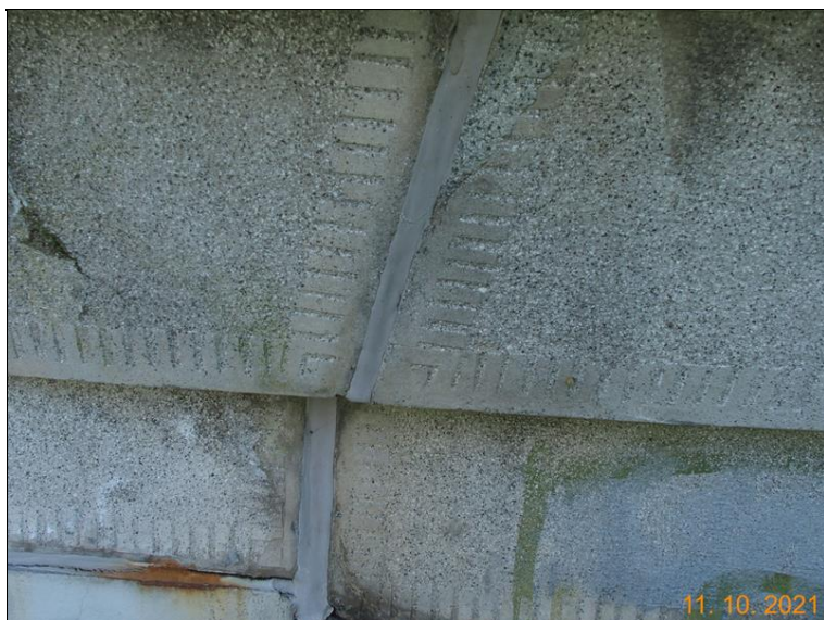
Zatmelení dilatačních spár římsy a NK vpravo na OP4
