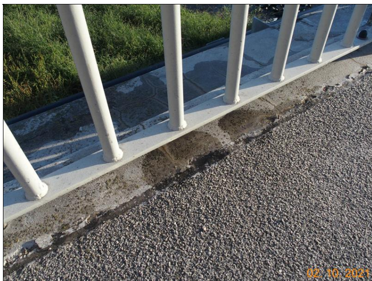
Průsak ze spáry mezi chodníkem a levou římsou v průběhu havárie vodovodu
