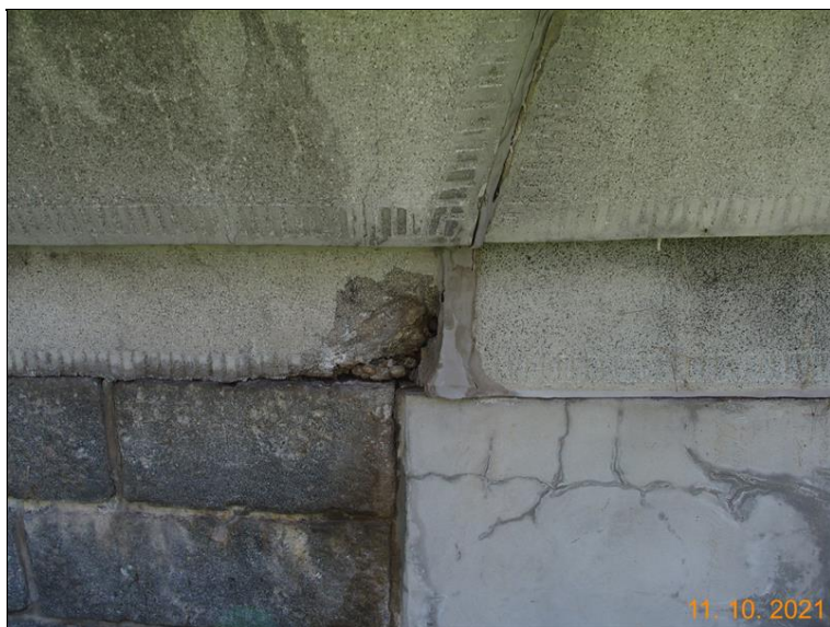
Zamáčení uložení NK na OP1 vpravo
