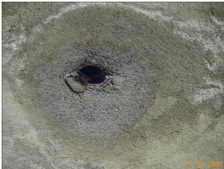
Podhled nosné konstrukce - 1. pole, zamáčení v okolí odpadu odvodnění
