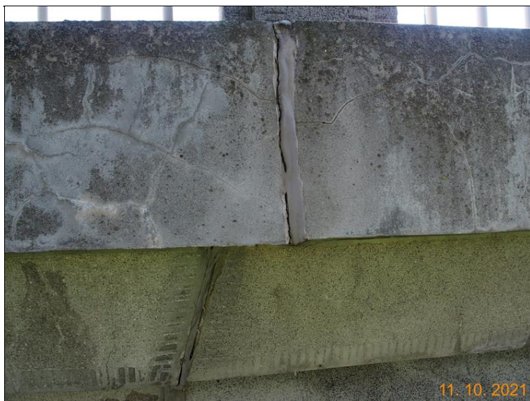
Poškození těsnění dilatační spáry na OP1 vlevo z boční strany
