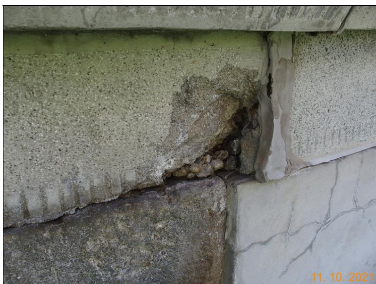
Zamáčení uložení NK na OP1 vpravo
