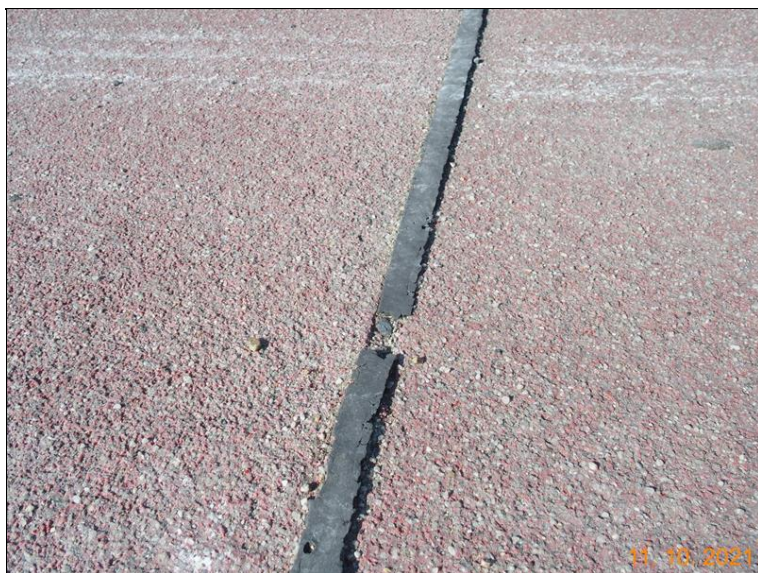
Dilatační spára levé římsy - odtržená záливka
