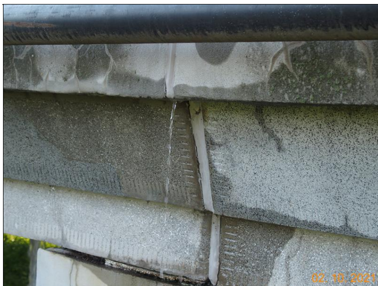
Průsak z boku dilatační spáry na OP1 vlevo v průběhu havárie vodovodu
