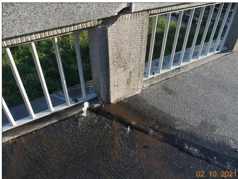
Tlakové průsaky z dilatační spáry v chodníku na OP1 vlevo v průběhu havárie vodovodu
