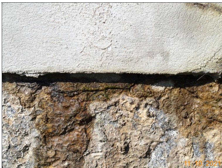
Zamáčení uložení NK na OP1 vlevo
