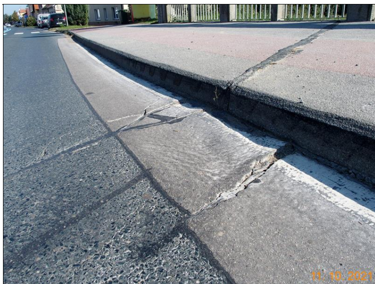
Dilatační spára vozovky nad OP1 vlevo
