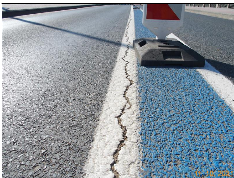
Podélná trhlina ve vozovce v 1. poli
