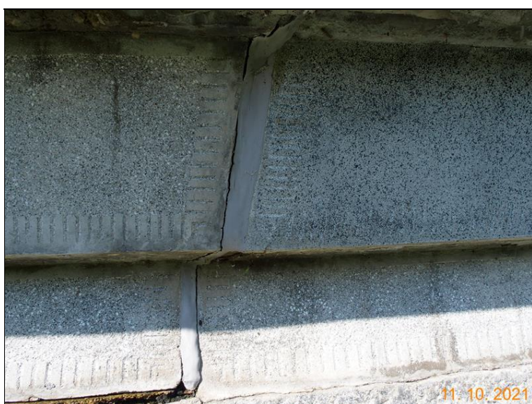
Poškození těsnění dilatační spáry na OP1 vlevo z boční strany
