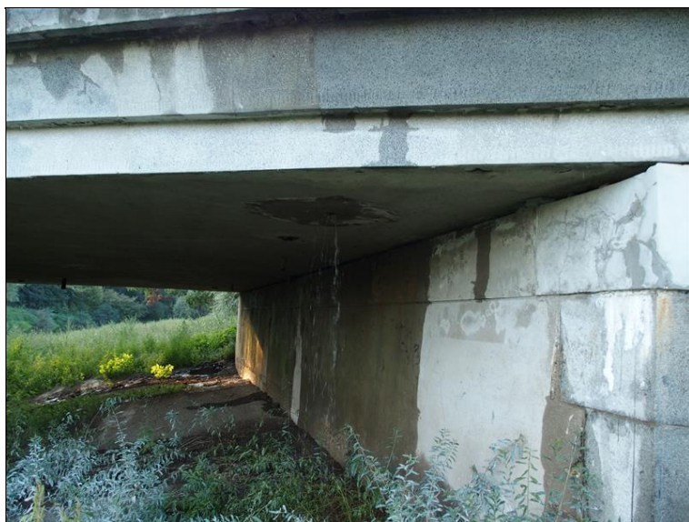
Plošné průsaky na líc OP1 přes dilataci v průběhu havárie vodovodu
