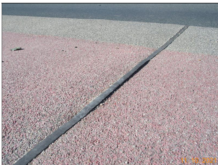
Dilatační spára levé římsy - odtržená zálivka
