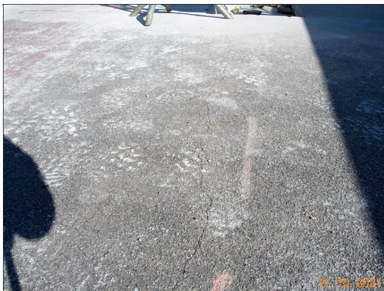
Podélná trhlina v izolaci chodníku v poli s poruchou vodovodu
