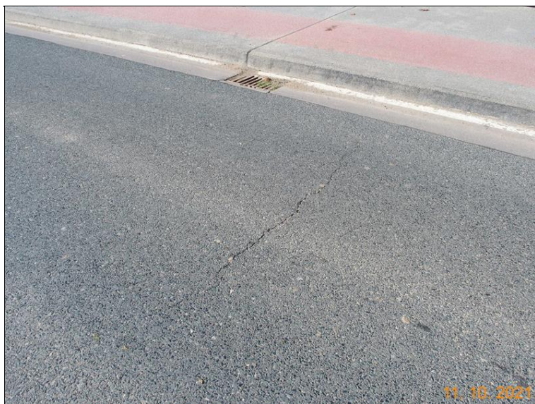
Příčná trhlina ve vozovce v 1. poli
