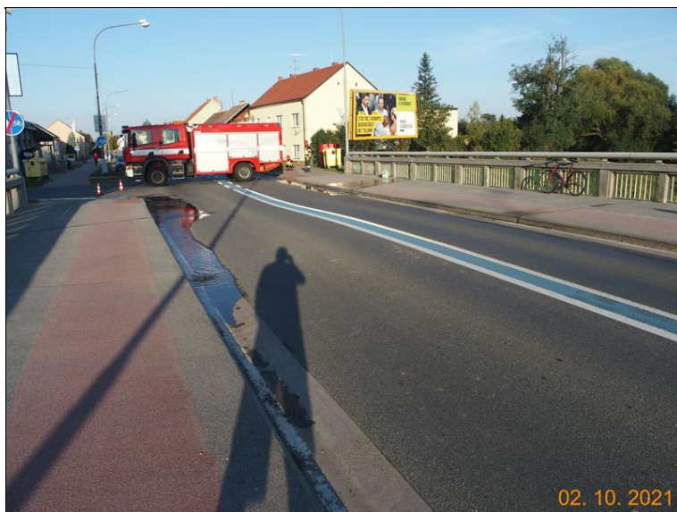
Vyutí vozovky v 1. poli v průběhu havárie vodovodu
