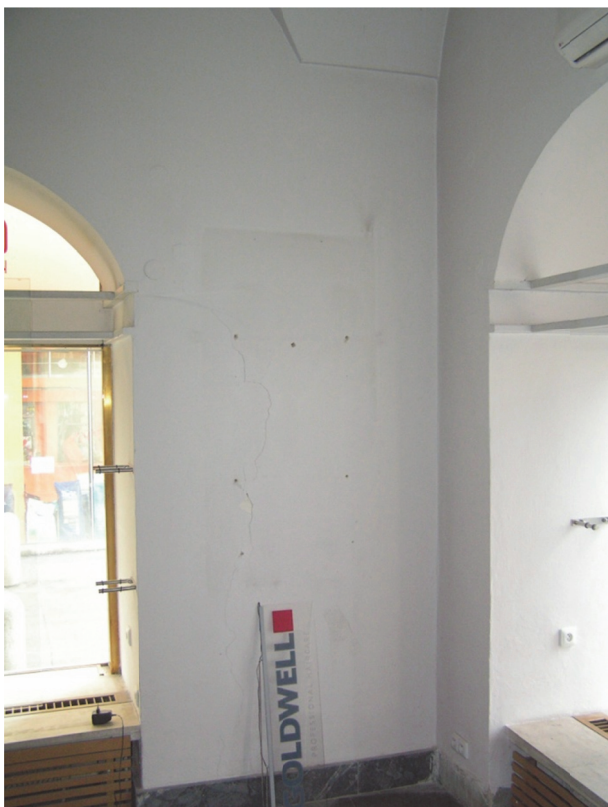
Foto 9: Pilíř na rohu ulic Veselá a skrytá z vnitřní strany
