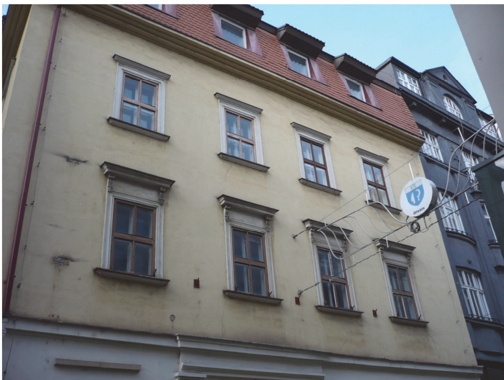
Foto 1: Pohled z ulice Česká
