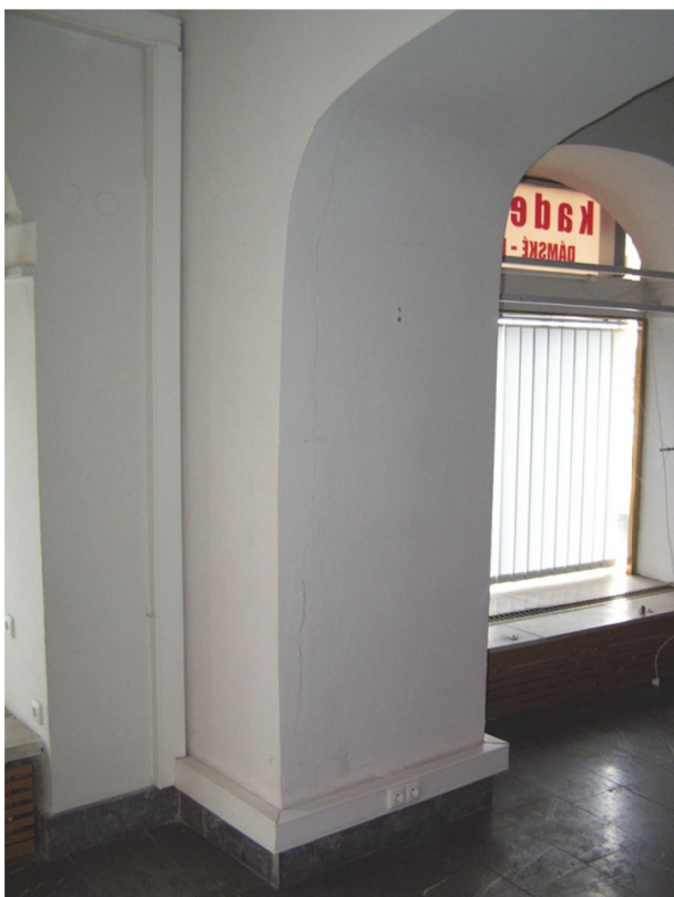
Foto 11, 12: Drobné trhliny ve ve vnitřních pilířích kadeřnictví v 1.NP
