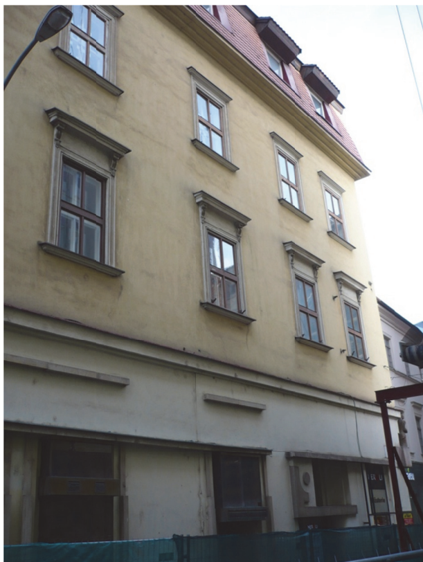
Foto 3: Pohled z ulice Skrytá
