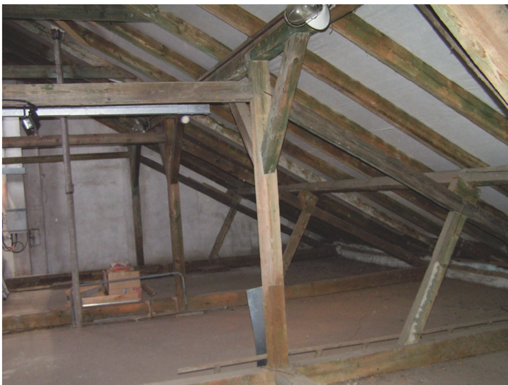
Foto 18: Konstrukce krovu (část podél ulice Česká)
