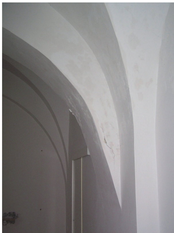
Foto 11, 12: Drobné trhliny ve ve vnitřních pilířích kadeřnictví v 1.NP
