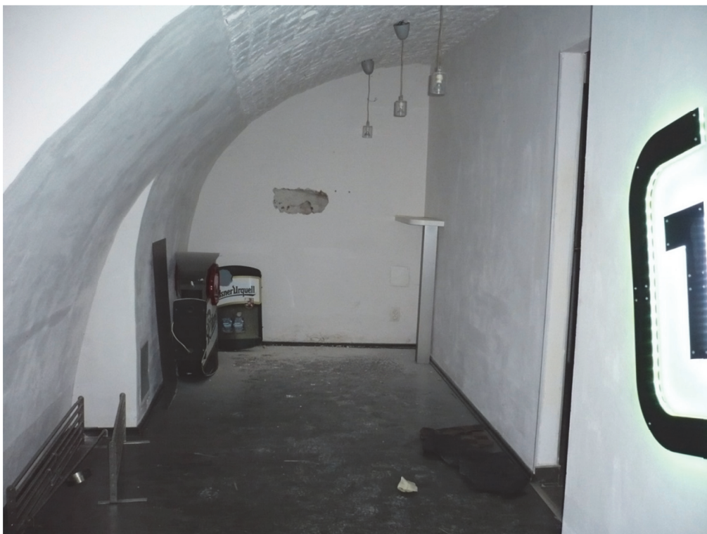
Foto 6: Stěny suterénu nejeví známky poruch
