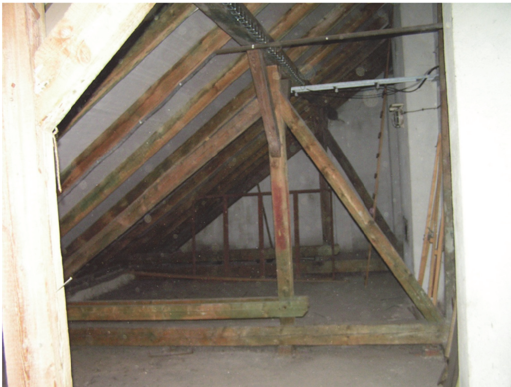
Foto 19: Pultová střešní konstrukce (část podél ulice Veselá)
