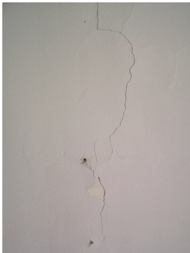
Foto 10: Detail trhliny
