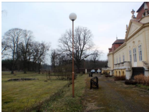
Obrázek č. 3 Pohled na vstup do zahrady dvoukřídlým schodištěm z vyvýšeného přízemí
