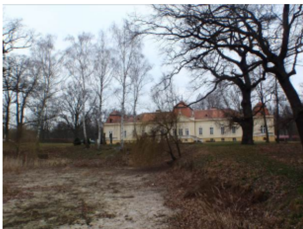
Obrázek č. 6 Pohled na zámek přes prázdnou vodní nádrž, stěny nádrže jsou poškozeny a propouštějí
