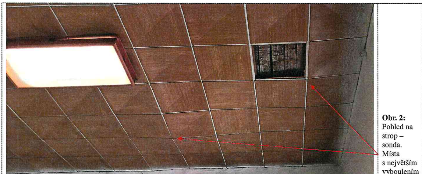
Obr. 1: Pohled na strop
