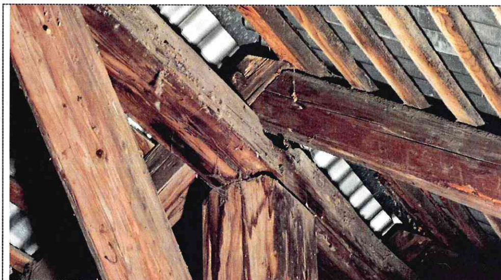
Obr. 18: Rozjetí vazeb
