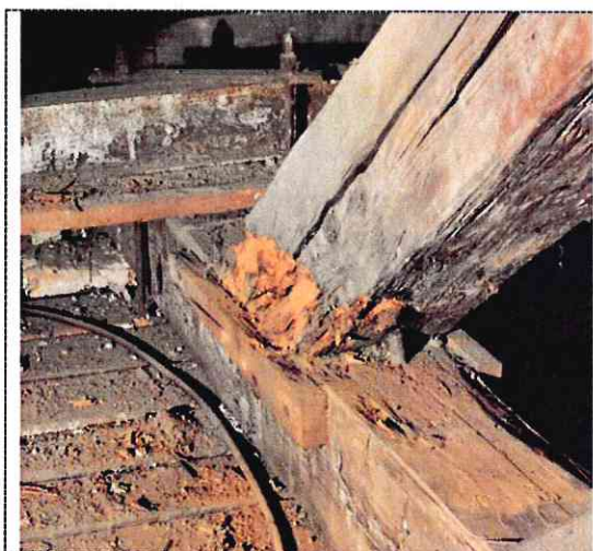
Obr. 23: Vzpěrka věšadla uhnílé
