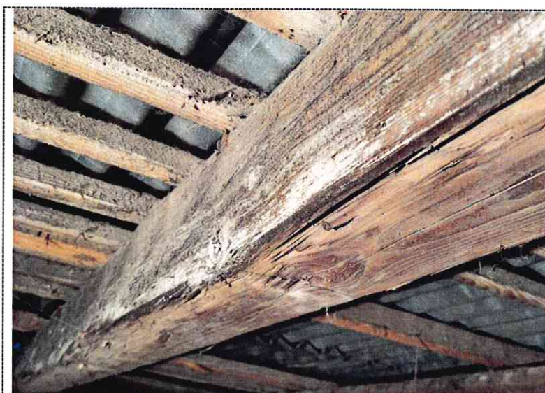
Obr. 7: Krokve plíseň
