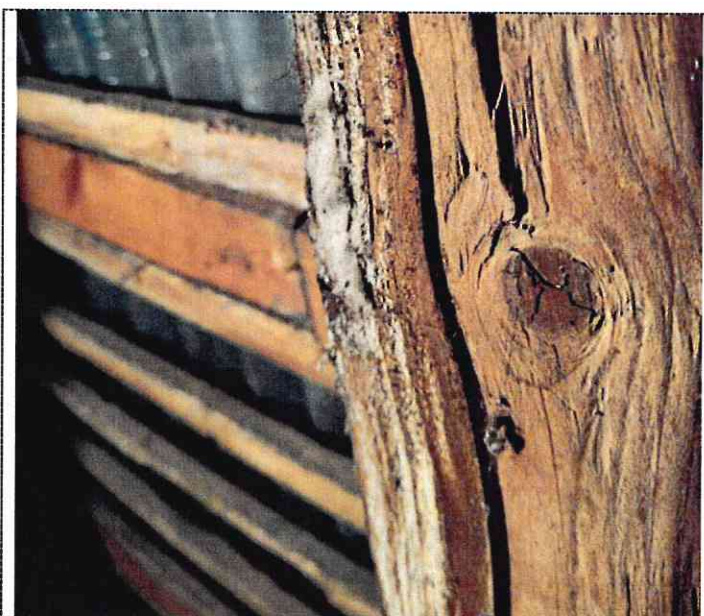
Obr. 8: Krokve plíseň
