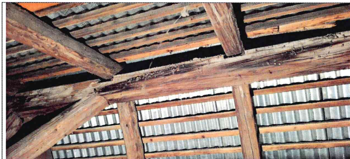
Obr. 29: Rozjeté vazby
