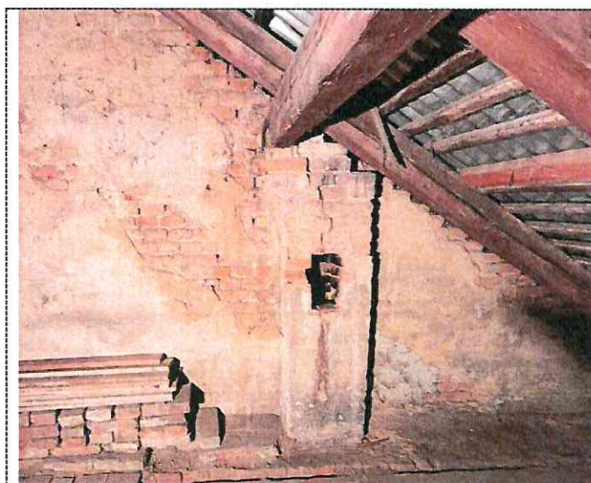
Obr. 27: Uložení střední vaznice
