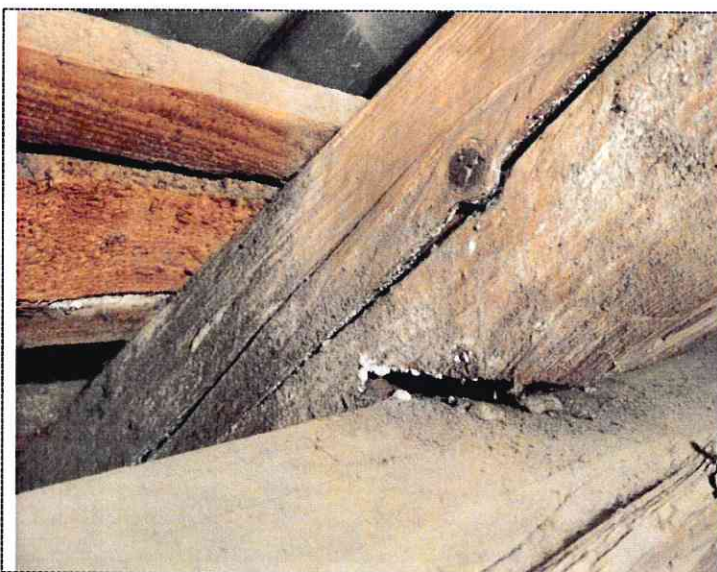
Obr. 20: Rozjetí vazeb
