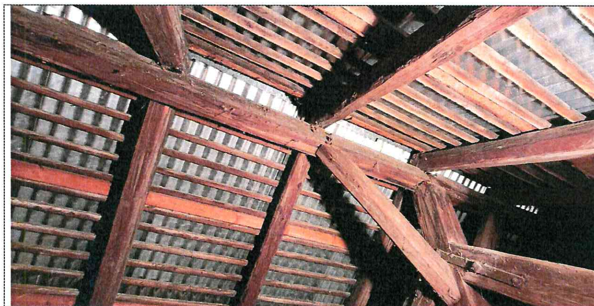
Obr. 17: Rozjetí vazeb
