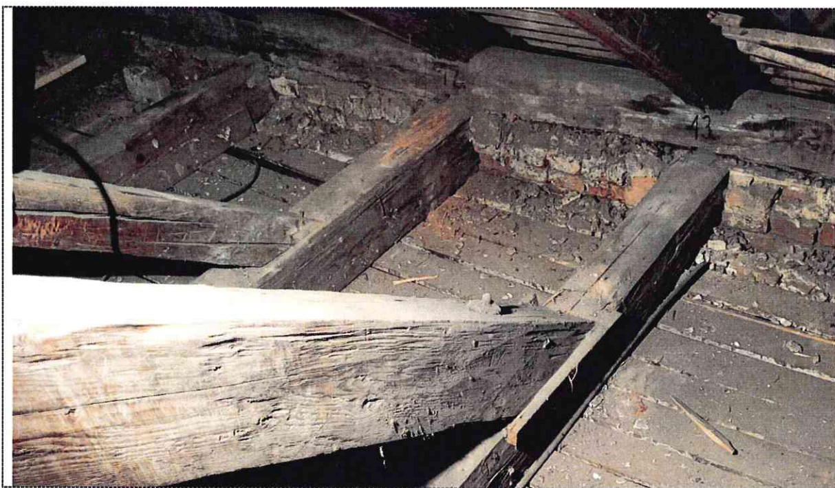
Obr. 30: Poškozené zhlaví
