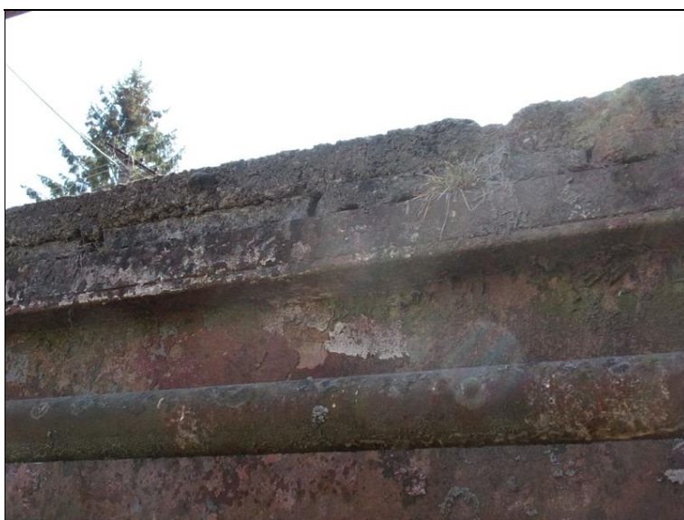
Boční pohled na konstrukční vrstvy chodníku
