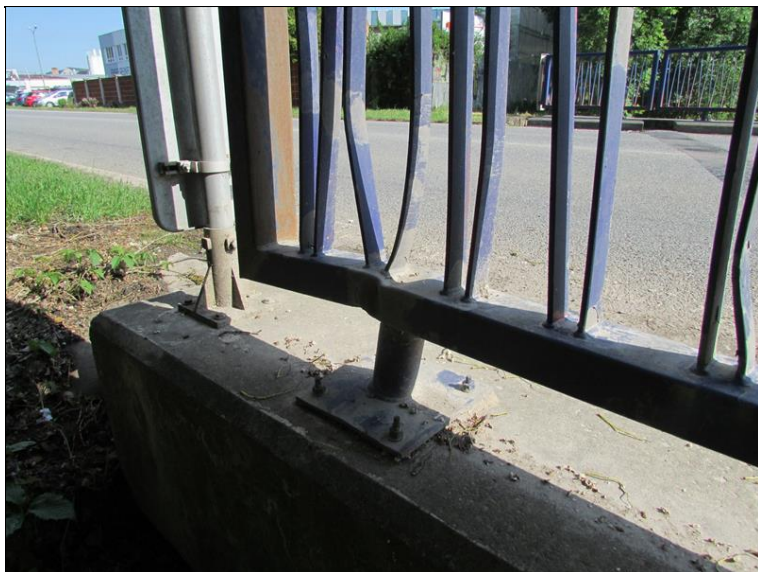
Deformace zábradlí u OP1 vpravo
