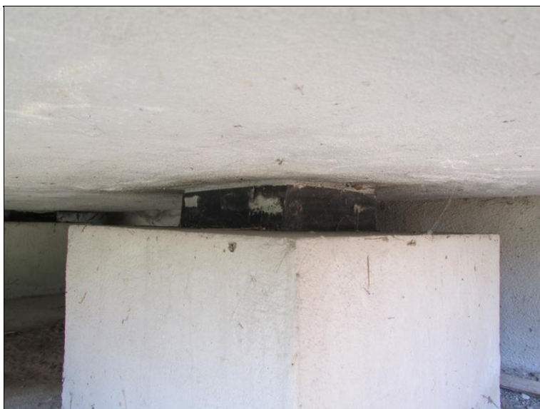
Elastomerové ložisko na opěře OP1
