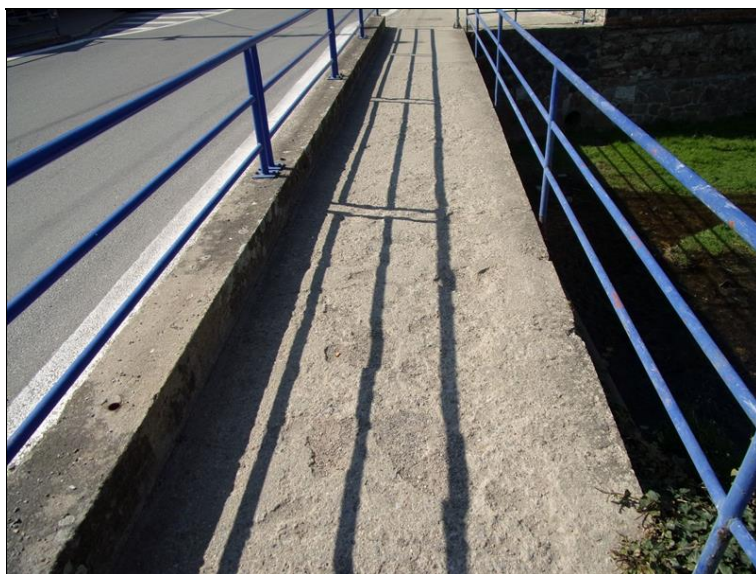
Degradace betonu povrchu chodníku
