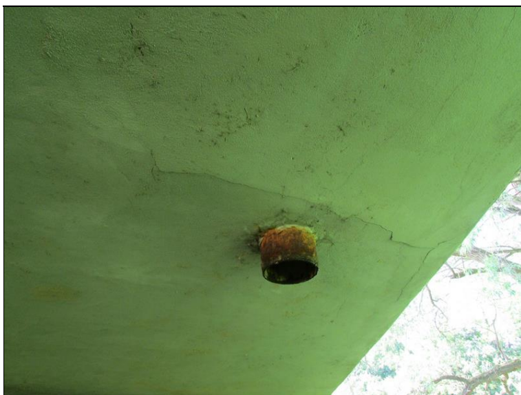
Koroze svodu odvodnění a popraskaná sanace v jeho okolí - známky zatékání
