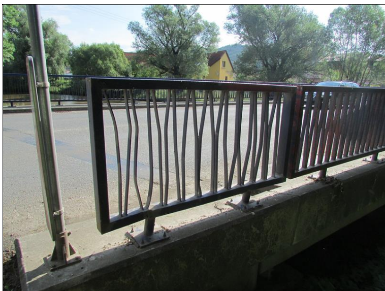
Deformace zábradlí u OP1 vpravo
