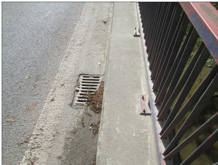
Odvodnění na mostě
