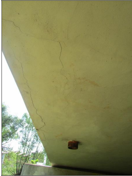
Trhliny na sanaci NK na podhledu
