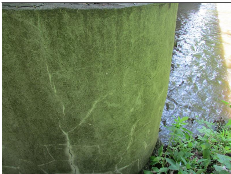
Trhliny v omítce pilíře P2
