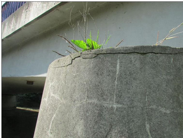
Trhliny na pilíři P2
