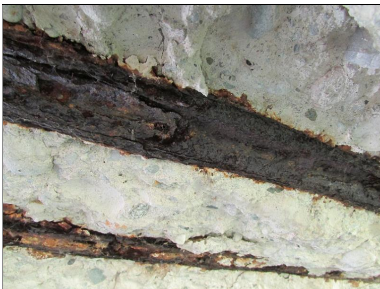
Opadávající sanace na podhledu - koroze nosné výztuže
