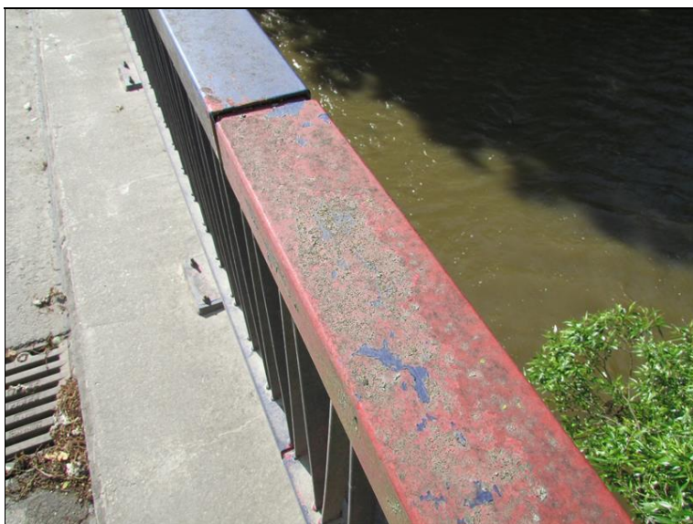
Strávený vrchní nátěr zábradlí
