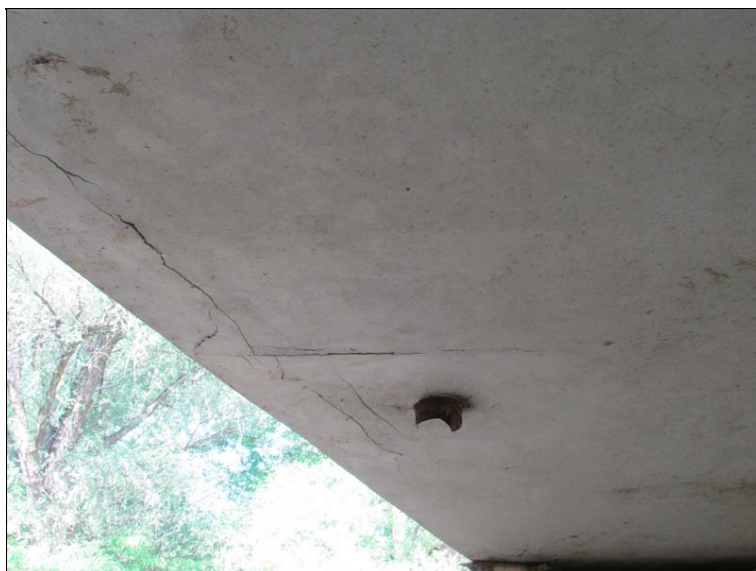
Koroze nosné výztuže
