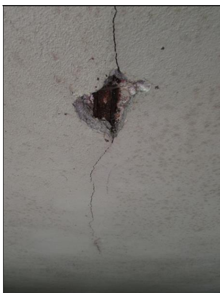
Koroze nosné výztuže
