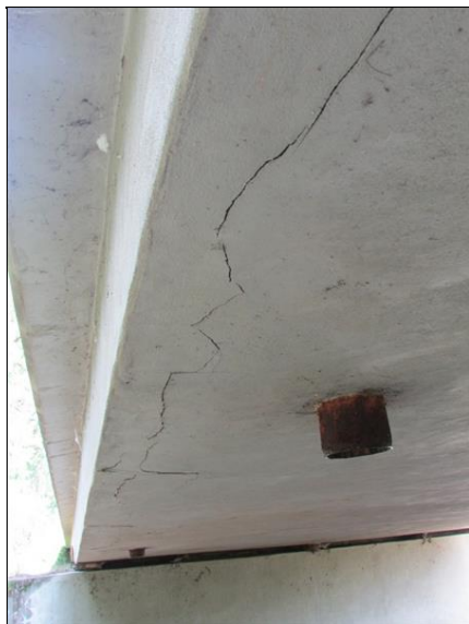
Trhilna v sanaci NK - téměř po celé délce hrany mostu
