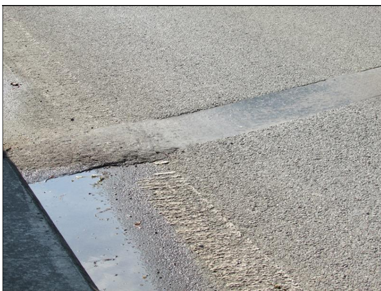
Vyjeté koleje v mostním závěru u OP1
