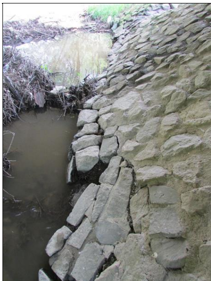
Rozpad odláždění svahl toku pod mostem
