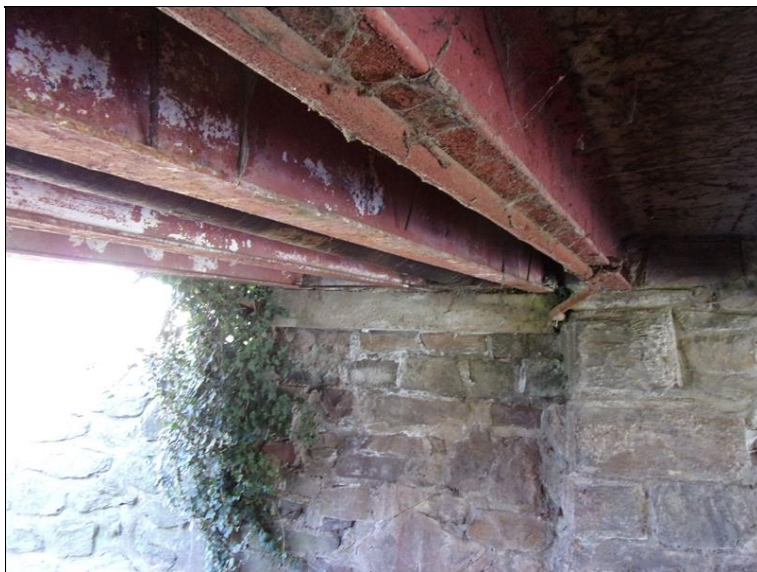
Pohled na OP2 vlevo a podhled NK levého chodníku
