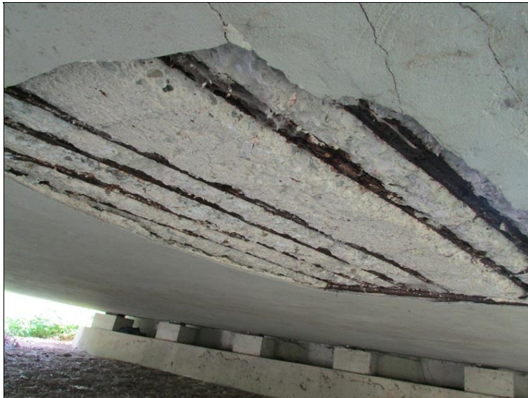
Opadávající sanace na podhledu - koroze nosné výztuže
