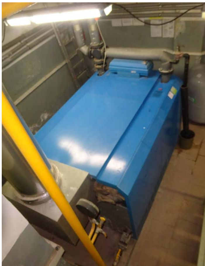
Foto č. 13 Plynový kotel BUDERUSG 434 X na vytápění a přípravu teplé vody v areálu Srdce v domě, p. o., Klentnice 81
