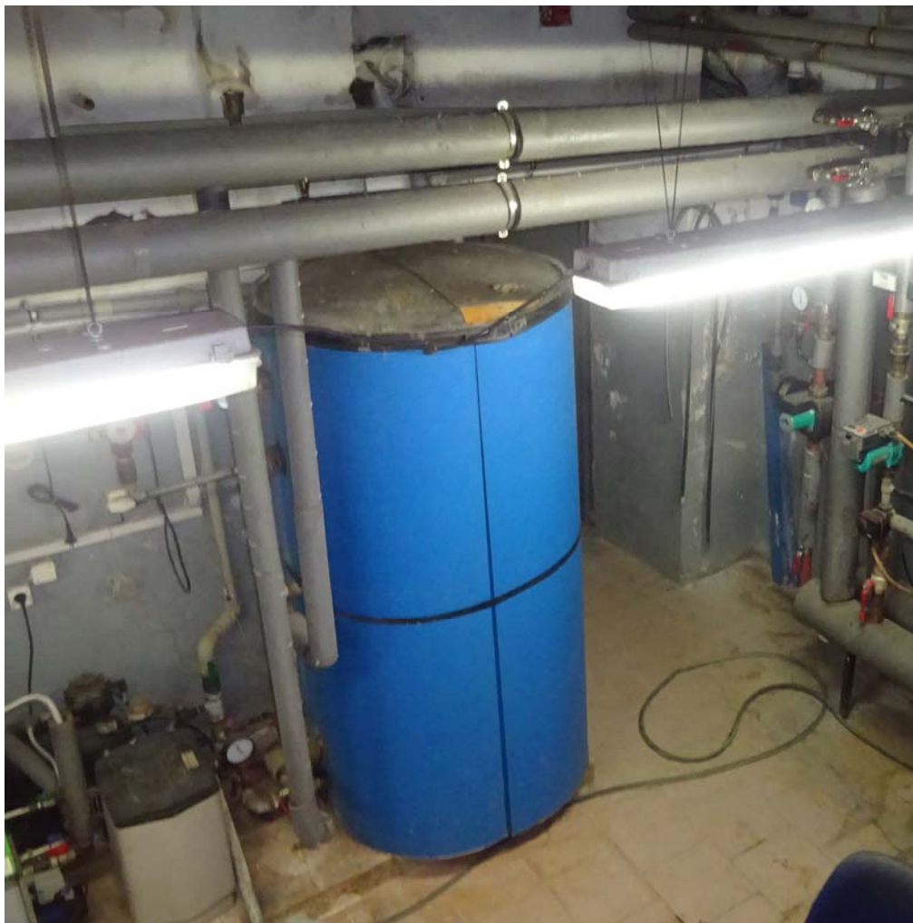
Foto č. 14 Zásobníkový nepřímotopný ohřívač BUDERUSG 751 ST na přípravu teplé vody v areálu Srdce v domě, p. o., Klentnice 81
