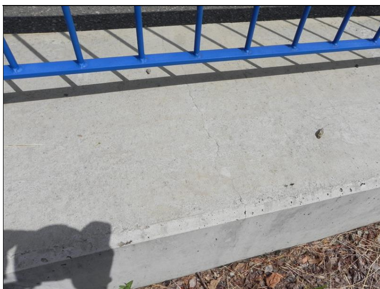
Pravá mostní římsa - příčná trhlina
