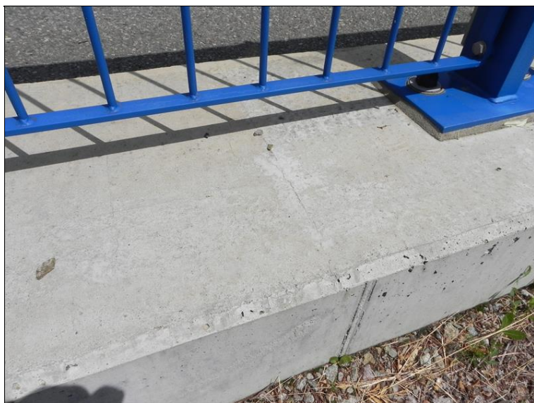
Pravá mostní římsa - trhlina
