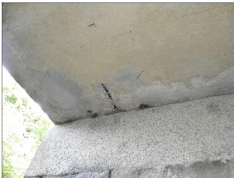
OP2 - opadaná krycí vrstva v místě uložení NK
