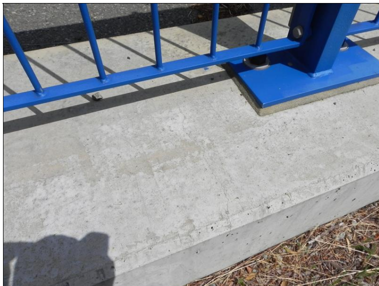
Pravá mostní řimsa - příčná trhлина
