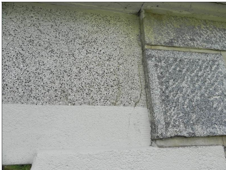
Svislá trhlina - místo uložení nad OP1 vlevo
