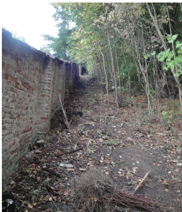
Foto 13 : Odkácení keřů od severozápadní zdi foto 11. 10. 2016
