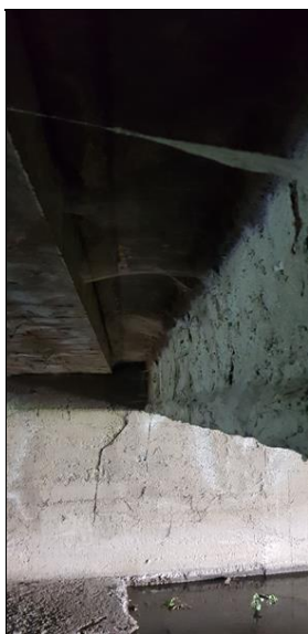
spára mezi mostem a obecním zastropením
