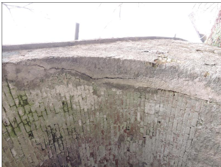
PS - podélná trhlina portálu
