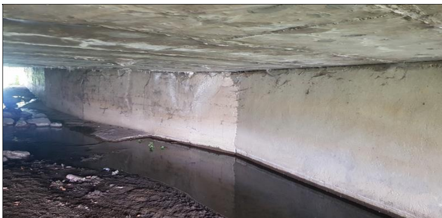
spára mezi mostem a obecním zastropením
