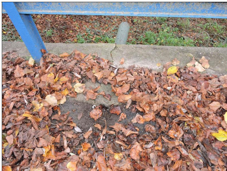
Zanesené odvodňovače na PS NAS
