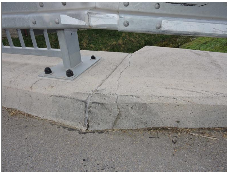
Nad Kř2L trhlina v římse
