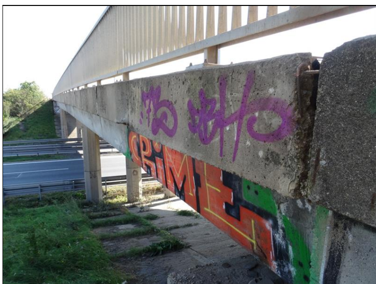
54.JPG Fasáda římsových prefabrikátů na začátku mostu v místě dilatace nad Op1. Beton povrchově degradovaný, na dilatační spáře odpadlý s obnaženou výztuží.
