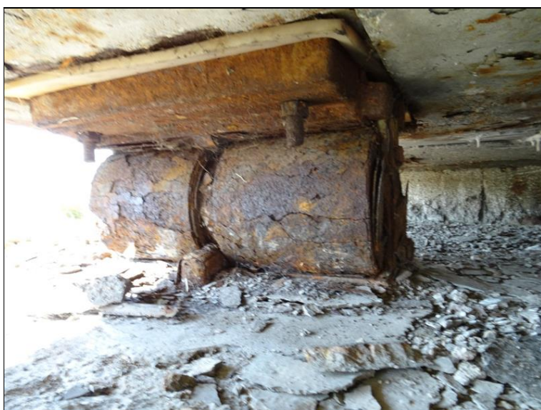
18.JPG Pravé krajní ložisko na Op1. Silná koroze.
