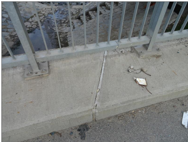
16.JPG Pravá římsa mostu v místě dilatační spáry nad Op1. Separace těsnícího tmelu.
