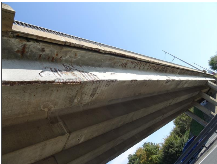
35.JPG Podhled NK v 2. poli ve směru pohledu od P2 k P3. Plošný ztráta krytí výztuže na čele levého krajního nosníku.
