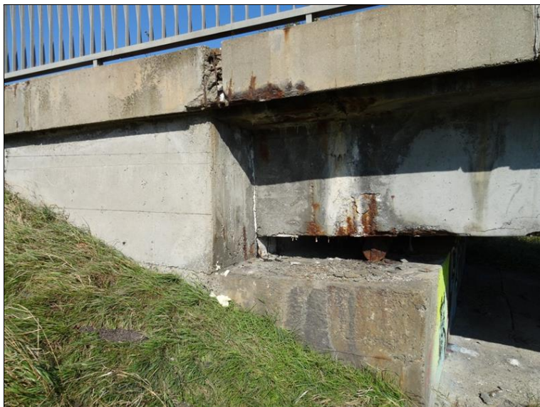
19.JPG Op1 zprava. silná průsak pod řimsou, rozpad říms. prefabrikátu v místě MZ a v okapové hraně. Bok krajního nosníku se s inkrustací a korodující výztuží s malým krytím.
