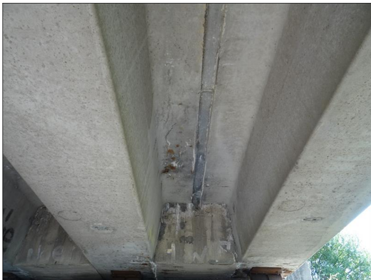
49.JPG Podhled pravých krajních nosníků před Op4. V konzole 2. nosníku zprava trhliny s průsakem. Na koncovém příčniku v místě mezi nosníky patrné stoky průsaků.
