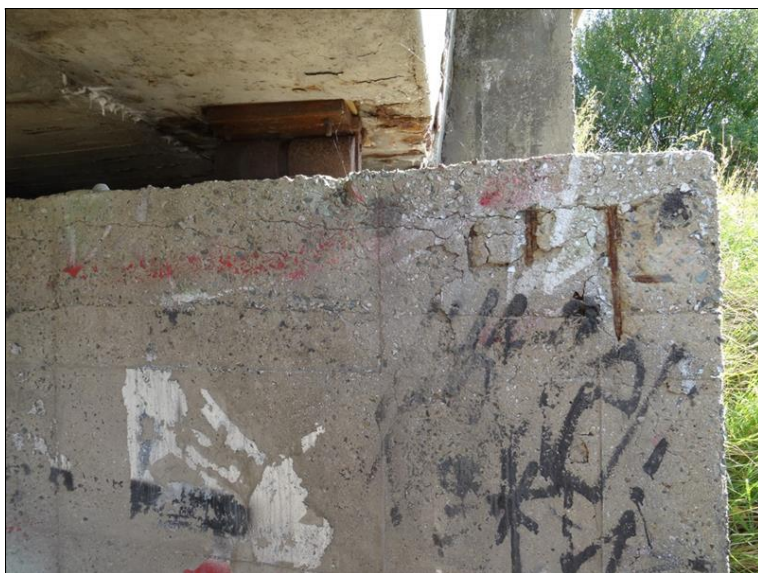
50.JPG Pravý čelní horní roh Op4. Degradace betonu.
