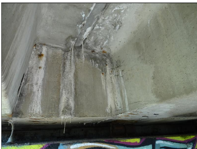
15.JPG Průsaky mezi středovými nosníky v místě koncového příčníku nad Op1. Stoky vápných výluh a Inkrustace jejich sedimentu.
