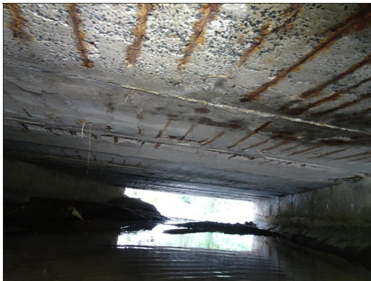
10.JPG Podhled NK ve směru pohledu zleva. Průsaky, degrad. beton, koroze obnažené výztuže.
