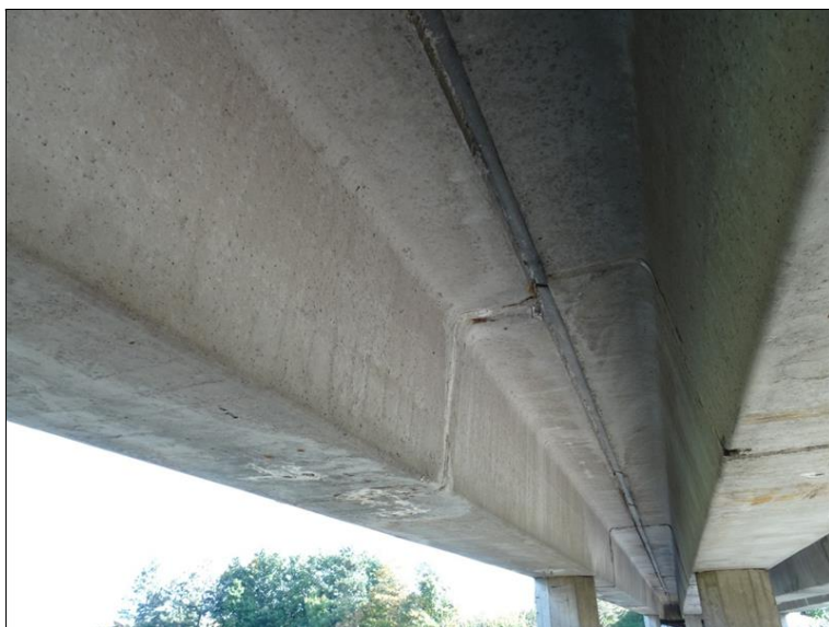
23.JPG Podhled levých krajních nosníků v 1. poli. Průsaky příčnou spárou.
