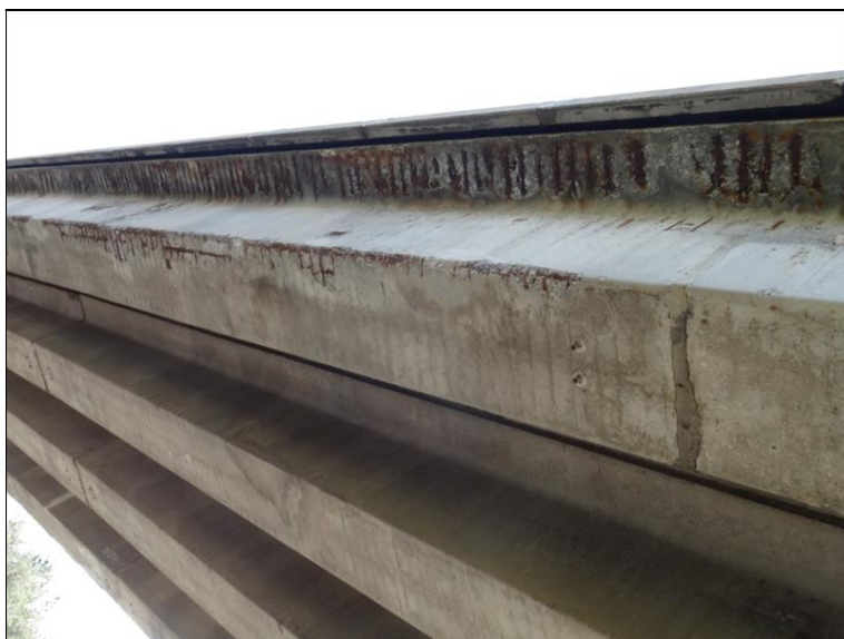
30.JPG Podhled NK ve 2. poli od P2 ve směru pohledu k P3. Na podhledu levého krajního nosníku a konzoly vyrýsovaná výztuž s malým krytím.
