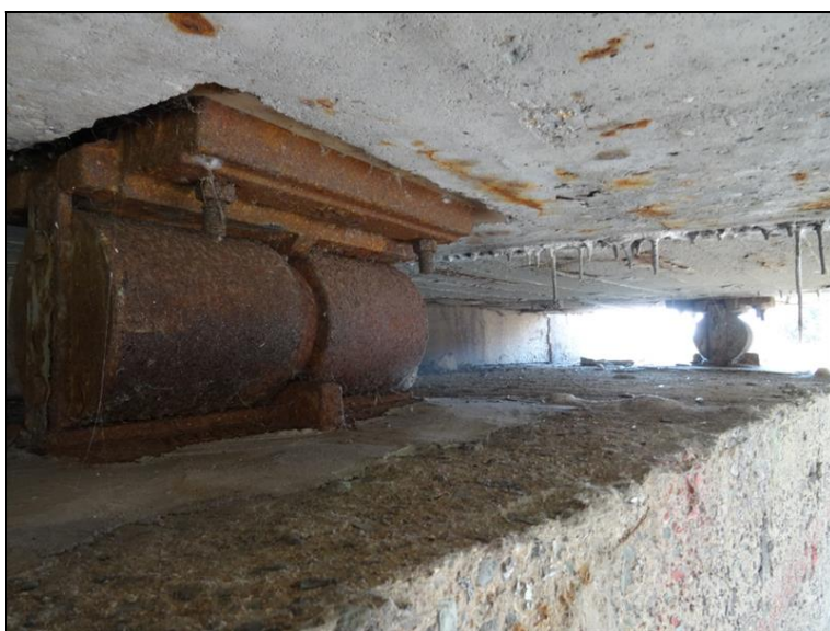
48.JPG Detail 2. ložiska zprava. Na pohledu příčnicku patrné intenzivní průsaky vytvářející záclonku krápníčků.
