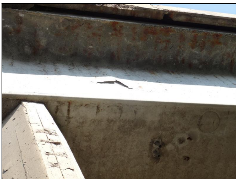
39.JPG Separace krycí vrstvy výztuže na boku pravého nosníku ve 3.poli u P3.
