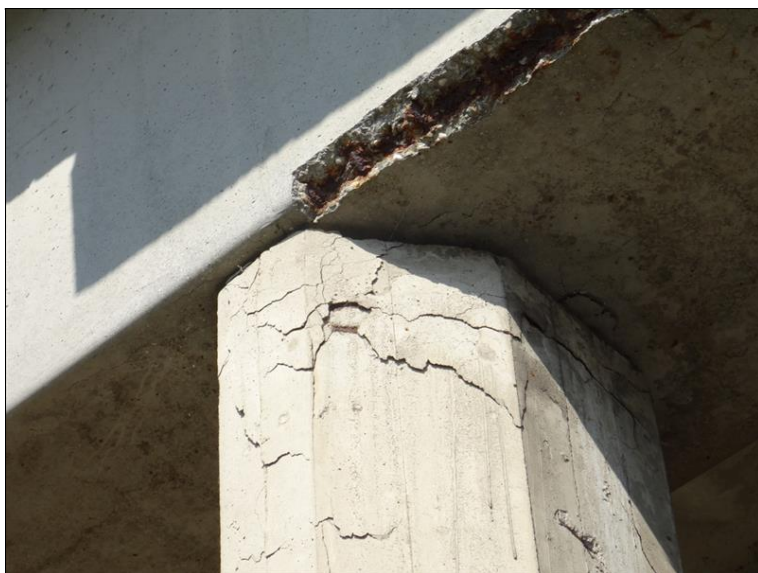
29.JPG Pravý sloup P2 v místě uloženého krajního nosníku přes vrubový kloub v pohledu z 2. pole ve směru zprava doleva. Separace betonu krycí vrstvy výztuže.
