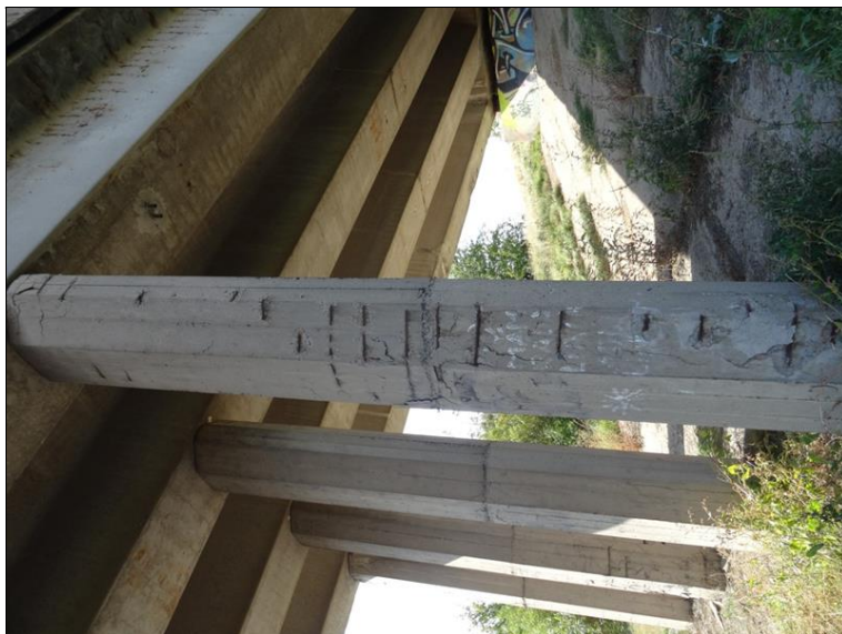
26.JPG P2 v pohledu z 2. pole ve směru zleva doprava. Odpad krycí vrstvy, obnažené třmínky.
