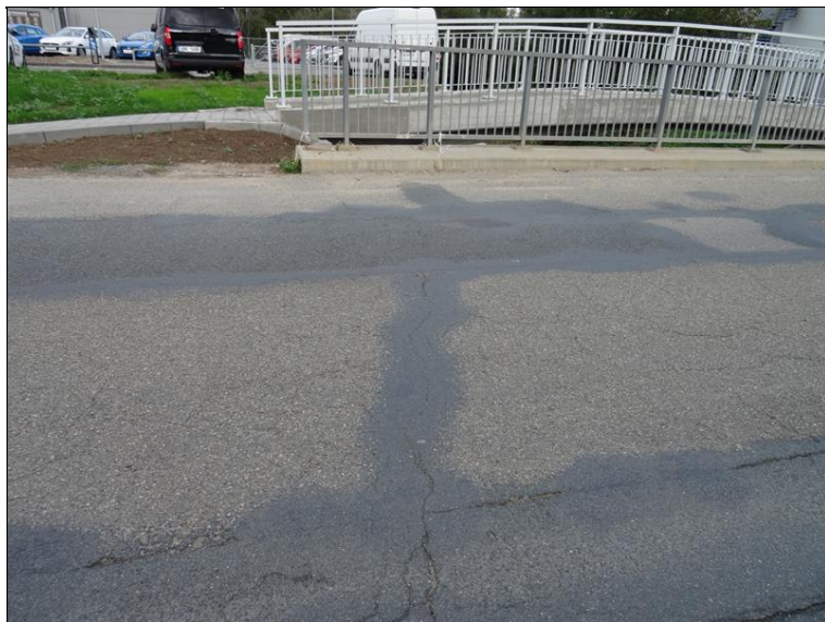
13.JPG Kryt vozovky na konci mostu v oblasti nad Op2. Vysprávky, trhliny.
