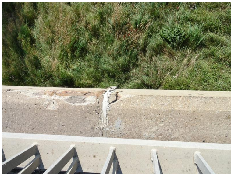
61.JPG Odpad hrany ř. prefabrikátu v těsněné spáře.
