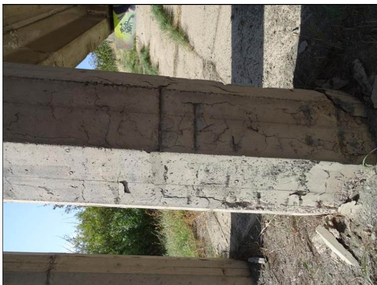
27.JPG Nadzemní část 2. sloupu zprava P2 v pohledu z 2. pole. Odpad a separace krycí vrstvy výztuže. Místa obnažené třmínky.
