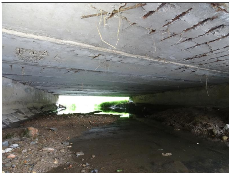
11.JPG Podhled NK ve směru pohledu zprava. Odpad krycí vrstvy a koroze obnaž. výztuže.
