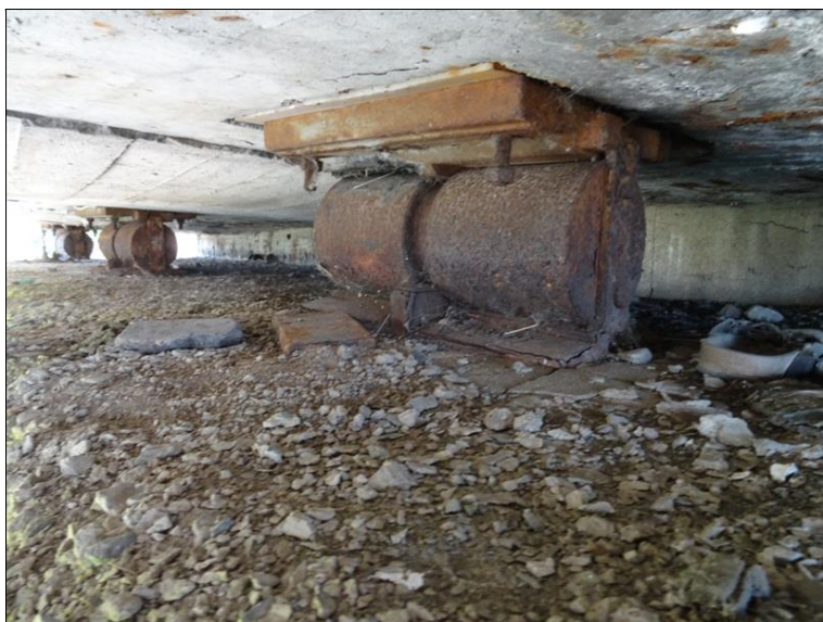
14.JPG 2. -3. ložisko zleva na Op1. Koroze ložisek. Rozpad povrchu betonu úlož. prahu.
