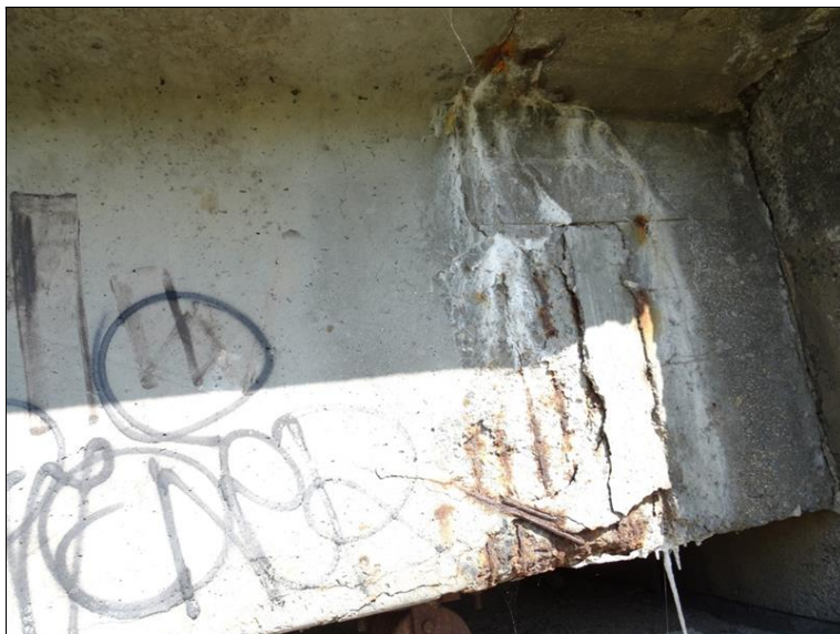
52.JPG Bok pravého krajního nosníku nad Op4. Průsaky, malé krytí výztuže, separace a odpad krycí vrstvy.
