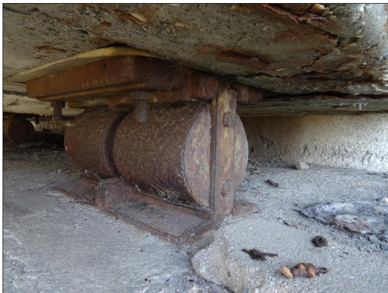
13.JPG 1. ložisko zleva na Op1. Silná koroze.
