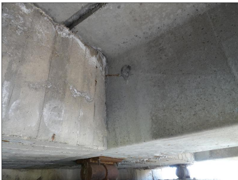
47.JPG Detail průsaku v místě středu koncového příčnicku nad Op4.
