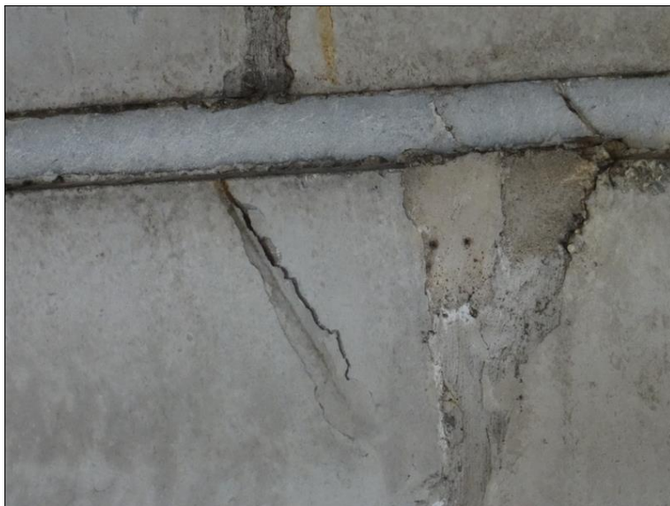
34.JPG Detail praskliny rohu pravé (vnitřní) konzoly levého středového nosníku v místě příčné spáry.
