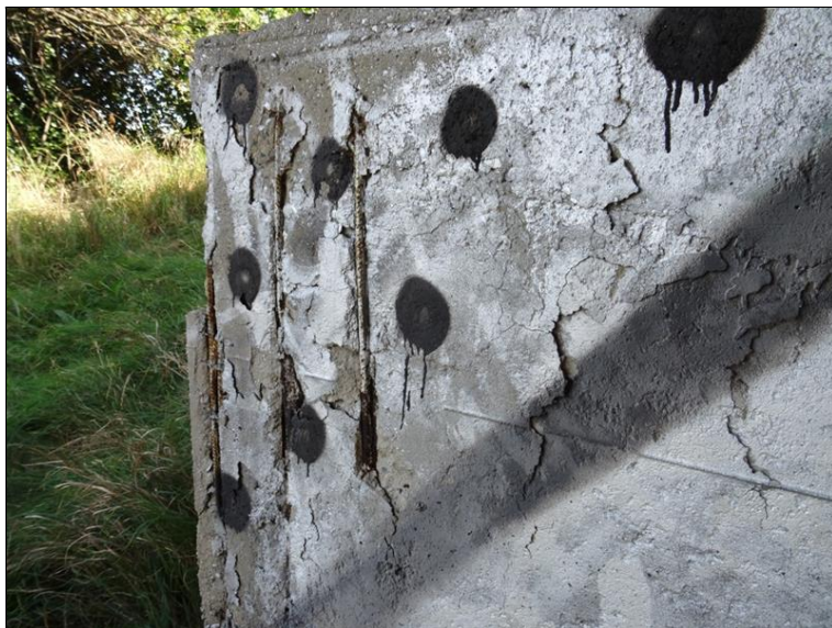
43.JPG Op4 - levý čelní horní roh. Odkrytá výztuž s malým krytím a patrná separace betonu v místě další výztuže,
