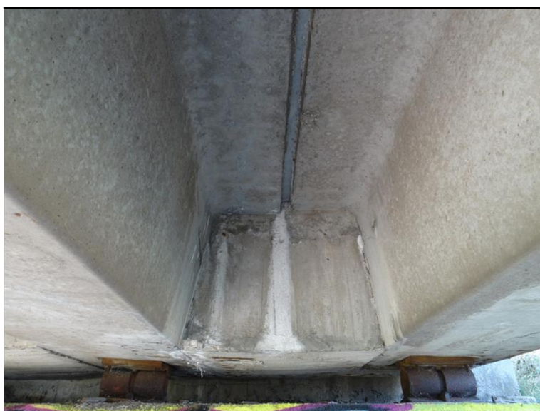
12.JPG Průsaky mezi krajními nosníky zleva v místě koncového příčníku. Stoky vápenných výluh a inkrustace jejich sedimentů.
