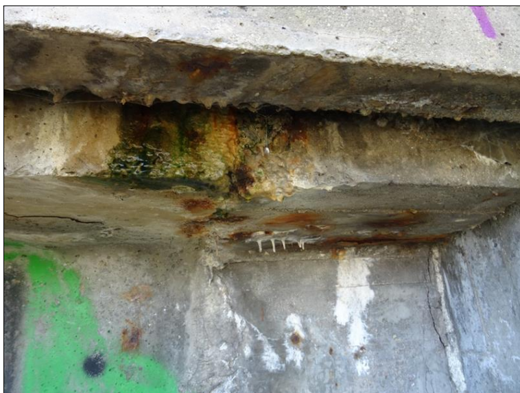
8.JPG Detail průsaku pod řimsou.
