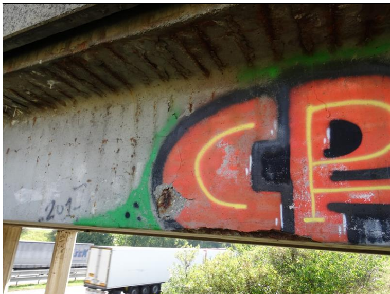
10.JPG Bok levého krajního nosníku před Op1. Odpadá spodní hrana trámu, vyrýsované třmínky.
