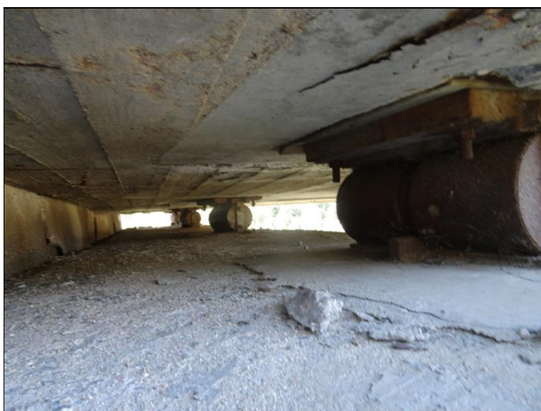
45.JPG Podhled koncového příčnicku NK nad Op4 zleva v oblasti mezi ložisky a závěr. zídkou. V místě 1. ložiska separace betonu krycí vrstvy výztuže.
