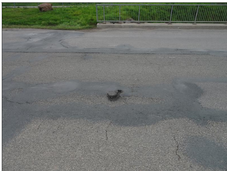
14.JPG Kryt vozovky na začátku mostu. Výtluk, trhliny, vysprávky.
