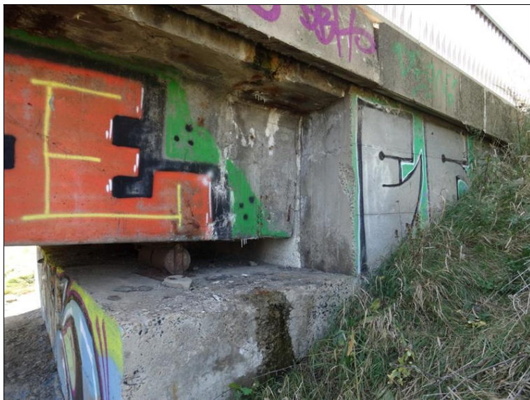
7.JPG Op1 zleva. Silný průsak pod řimsou
