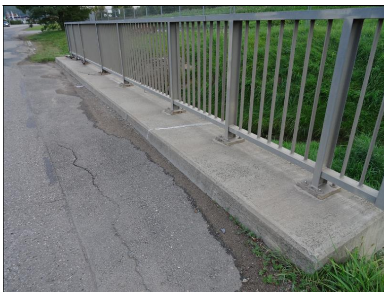
15.JPG Levá římsa. Před římsou v živici podélná široká trhlina. Povrch. degradace betonu, zanesená krajnice.
