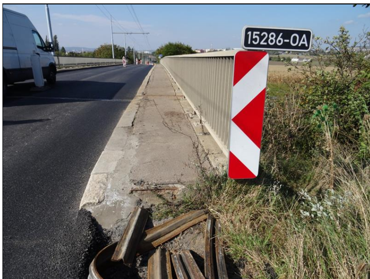
3.JPG Doplněná tabulka s evid. číslem a naváděcí deska Z4 na konci mostu.
