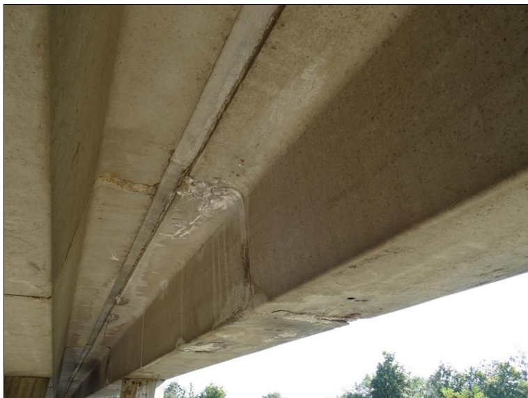
22.JPG Podhled pravých krajních nosníků v 1. poli. Průsaky příčnou spárou.
