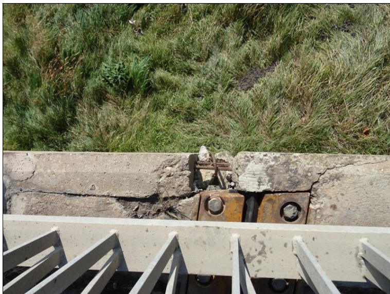
58.JPG Odpadlý (ulomený nebo rozdrčený) svislý kraj ř. prefabrikátu v místě MZ na straně Op1.
