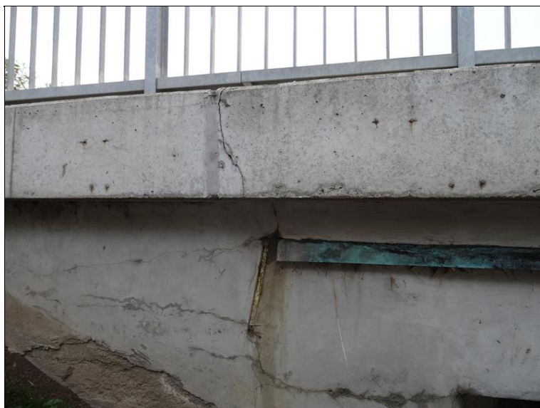
17.JPG Pravá římsa v místě nad Op1. Svislá trhлина mimo dilatační spáru. Patrné průsaky na konci NK a ložnou spárou , vlhkostí zvýrazněné trhliny v sanační omítce křídla opěry.
