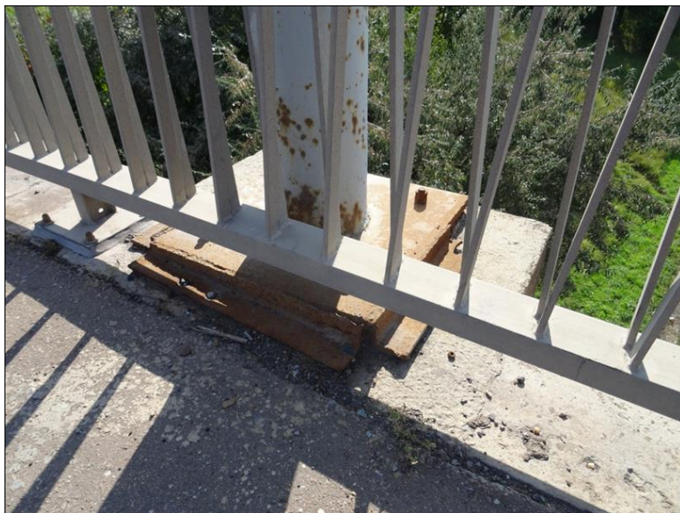
64.JPG Koroze patní desky sloupu trolejového vedení.
