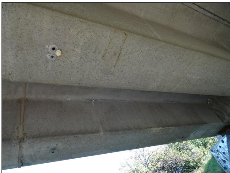
41.JPG Podhled levých krajních nosníků před Op4. Odvod. trubičky dutin nosníků bez okapového přesahu.
