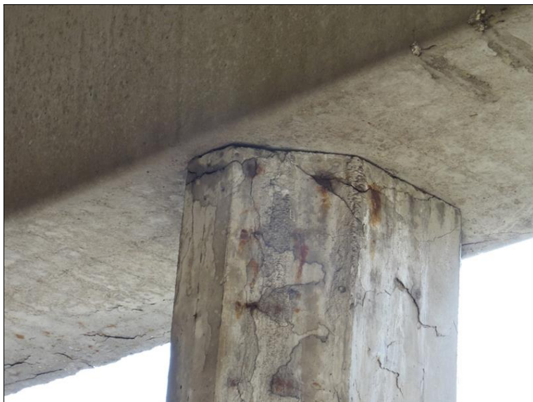
25.JPG Pravý sloup P2 v místě uloženého krajního nosníku přes vrubový kloub v pohledu z 1. pole ve směru zleva doprava. Separace betonu krycí vrstvy výztuže.
