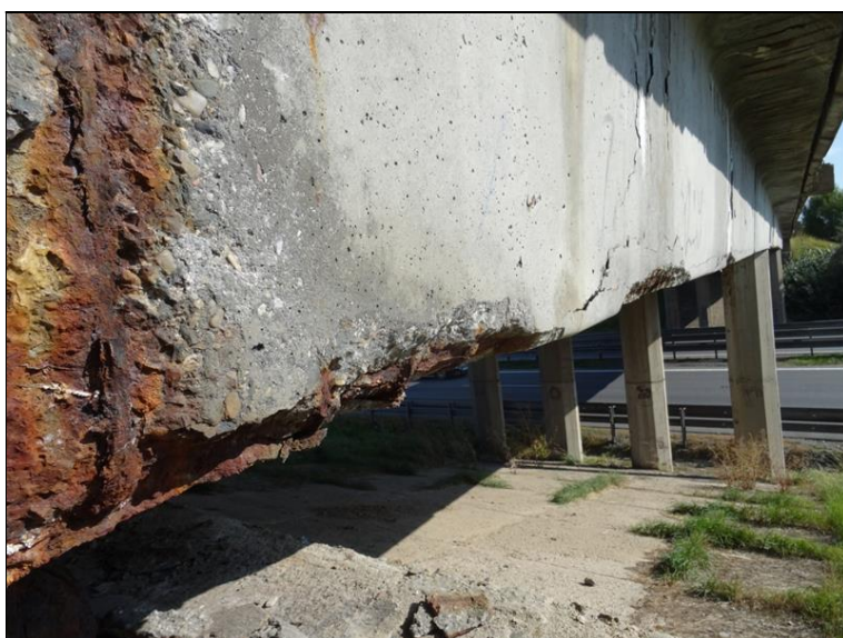
21.JPG Bok pravého krajního nosníku v pohledu od Op1. Odpadlá spodní hrana nosníku, odkrytá podélná výztuž.
