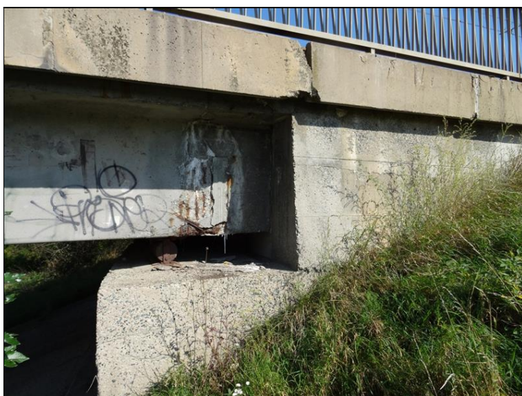
51.JPG Op4 zprava. Beton na boku Op a křídle pod římsou silně degradován. Olámaná hrana ř. prefabrikátu v místě dilatační spáry.
