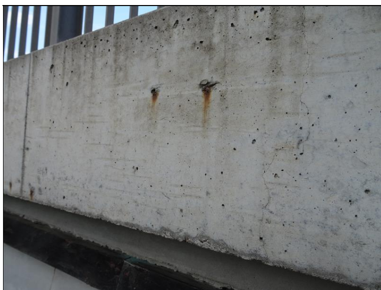
18.JPG Místy prorýsované ocel. vložky na čele římsy.
