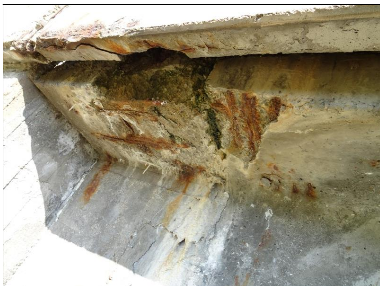
20.JPG Detail. podhledu vnější konzoly pravého krajního nosníku nad Op1 závěrné zídky (ZZ).
