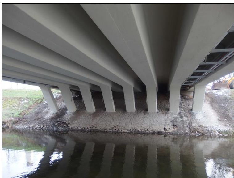
Pohled na vzpěry P3, OP4 tvořena táhly a koncovým příčником je nepřístupná pod úrovní terénu.
