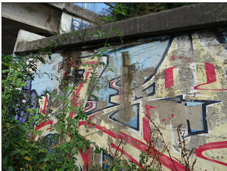
39.JPG Pokročilá degradace betonu, koroze obnažené výztuže v šikmém křídle u Op1 na levé straně mostu.
