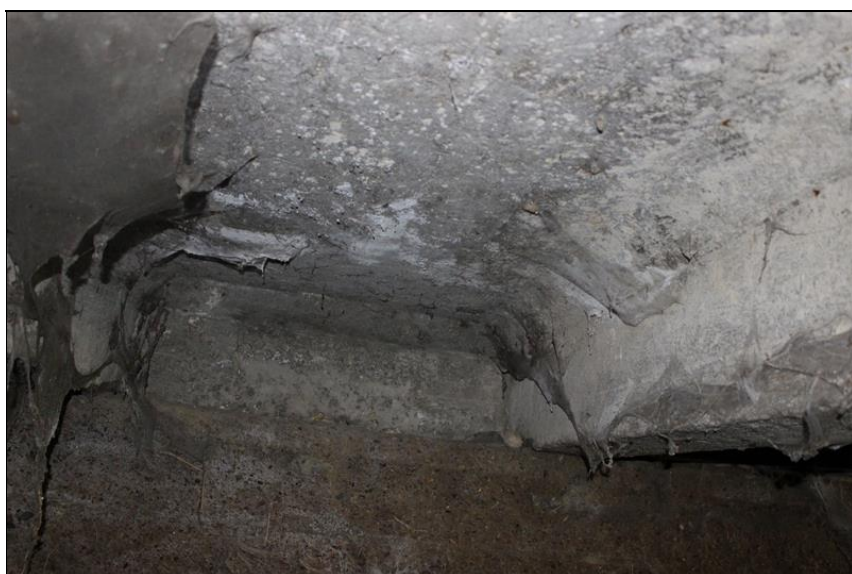
12-detail podhledu NK - vápenné výluhy.JPG
