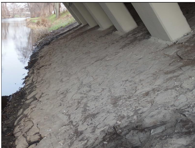
Zpevnění břehů pod mostem je v patě na úrovni vodní hladiny erodováno, spáry jsou vymílány a některé kameny jsou uvolněné.
