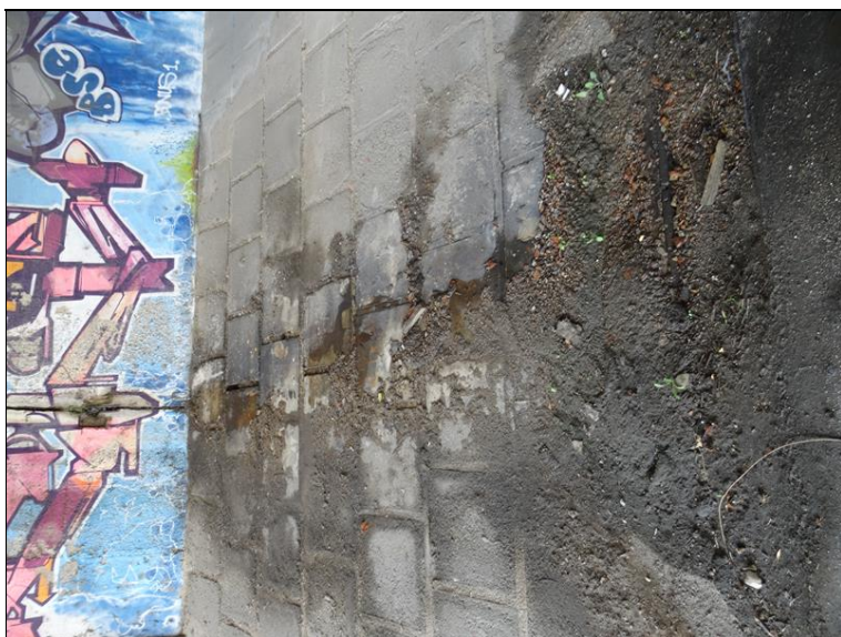
42.JPG Dlážděné zpevnění svahu u Op2 v místě středové spáry mezi mosty. Zátoky středovou spárou dochází k vyplavování spárování dlažby.
