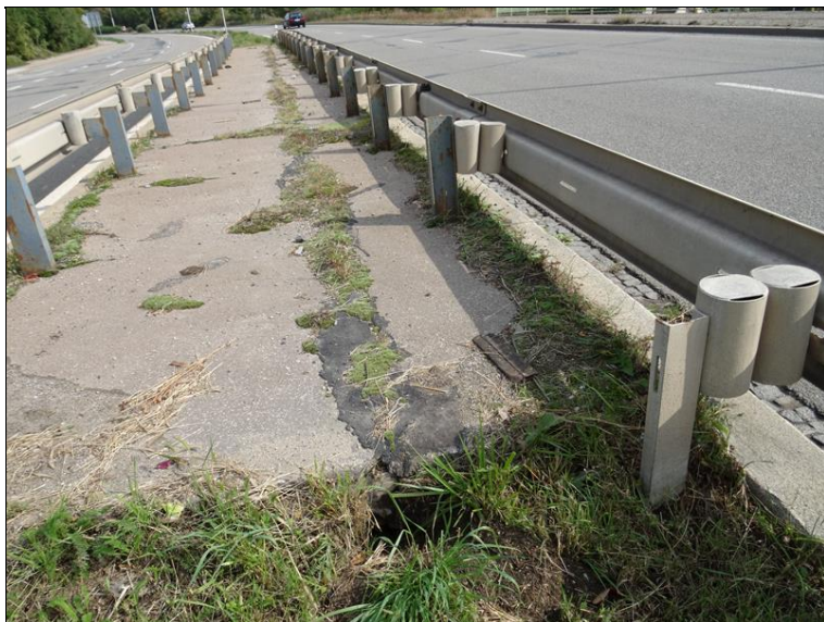
37.JPG Pravá vnitřní římsa na konci mostu. V zeleném pásu na styku s římsou propad s kavernou.
