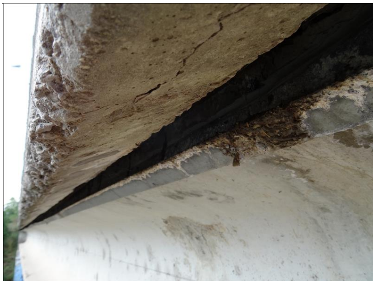
31.JPG Podhled levé římsy od začátku mostního pole . Detail degradace betonu okapové hrany lícního prefabrikátu.
