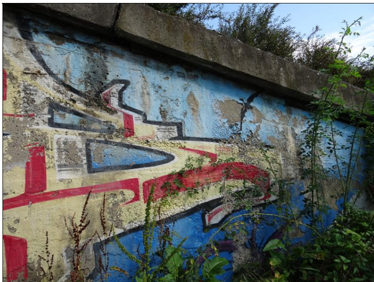
40.JPG Konec šikmého křídla. Průsaky pod římsou, výluhy, povrchová degradace betonu.
