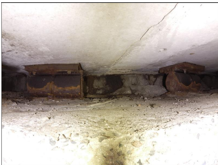
12.JPG Úložná spára v místě 1. a 2. ložiska zprava. Koroze ložisek, Na závěrné zídce stopů zátoků dilatační spárou.
