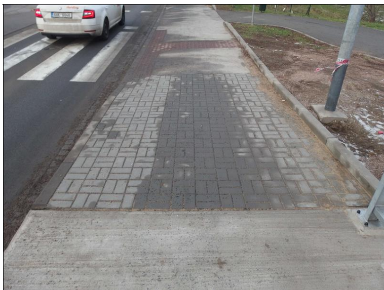
Chodník za konci říms tvořený betonovou zámkovou dlažbou je bez závad.
