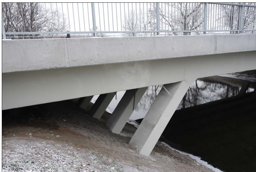
Pohled na levý bok NK v místě P3 - povrch SS a NK je sanován.
