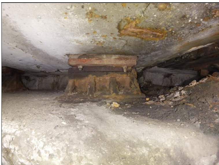
21.JPG 1. ložiska na Op2 zprava - zatékání, silná koroze ložiska, nečistoty na úložném prahu, degradace betonu na podhledu krajního nosníku.
