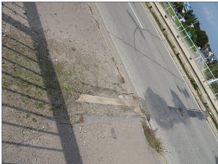
25.JPG Levý chodník a kryt vozovky v místě mostního závěru nad Op1. MZ v chodníku zanesený, ve vozovce přebalený, živice místy vytlačena s trhlinami a korozí.
