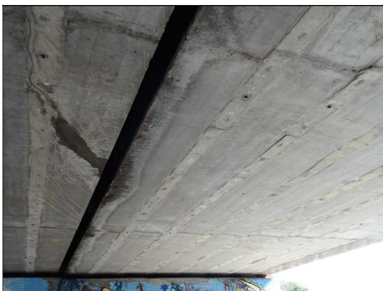
9.JPG Podhled nosné konstrukce (NK) ve směru k Op1. Podhled kraje pravého krajního nosníku zavlhlý až zvodnělý. Ve smývané oblasti koroze obnažených třmínků.
