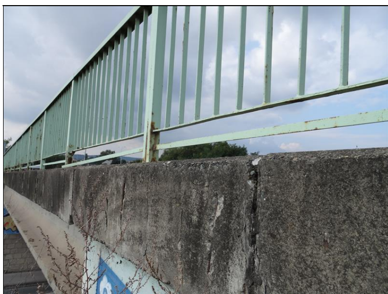
30.JPG Čelní plocha lícnicích prefabrikátů. Povrchová degradace betonu, místy odskok krycí vrstvy výztuže.
