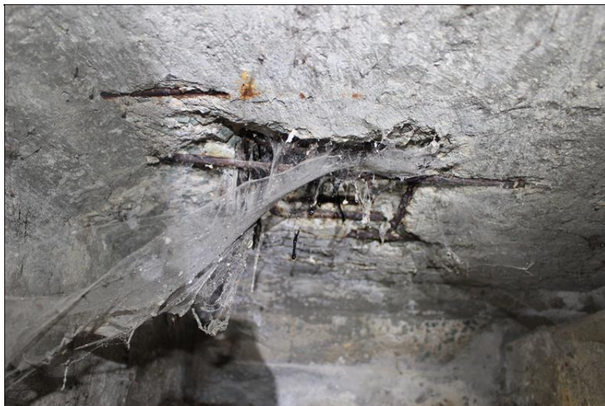
13-podhled NK poblíž opěry 2 - lokální koroze výztuže v hluboké kaverně.JPG
