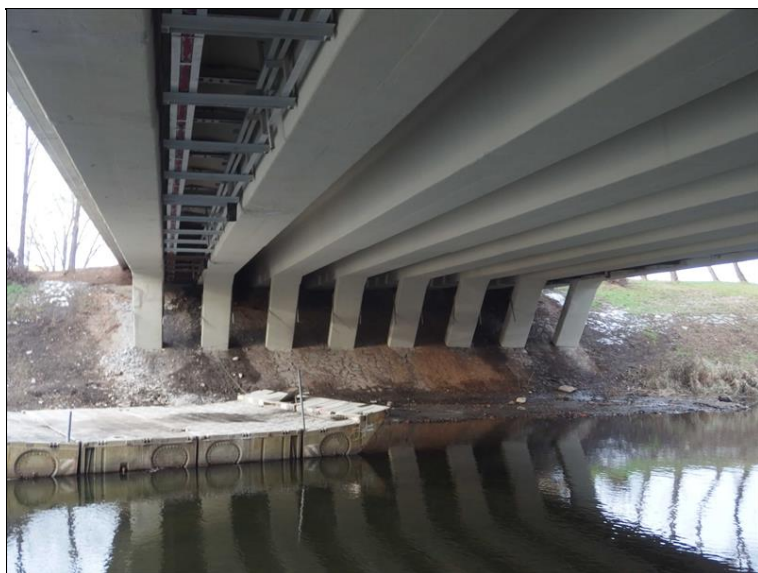
Pohled na vzpěry P2, OP1 tvořena táhly a koncovým příčником je nepřístupná pod úrovní terénu.
