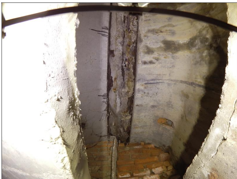
11.JPG Detail průsaku mezi mosty nad Op1.
