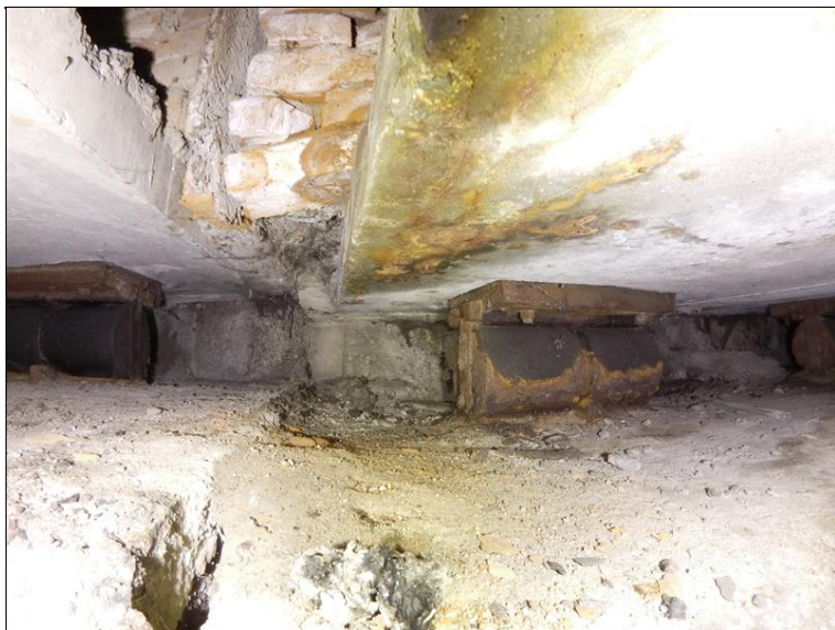
10.JPG Úložná (volná) spára mezi NK a Op1 na levé straně v místě styku s pravým mostem. Zátoky shora podtékají do podhledu krajního nosníku, koroze ložiska, úložný práh zanesený nečistotami.
