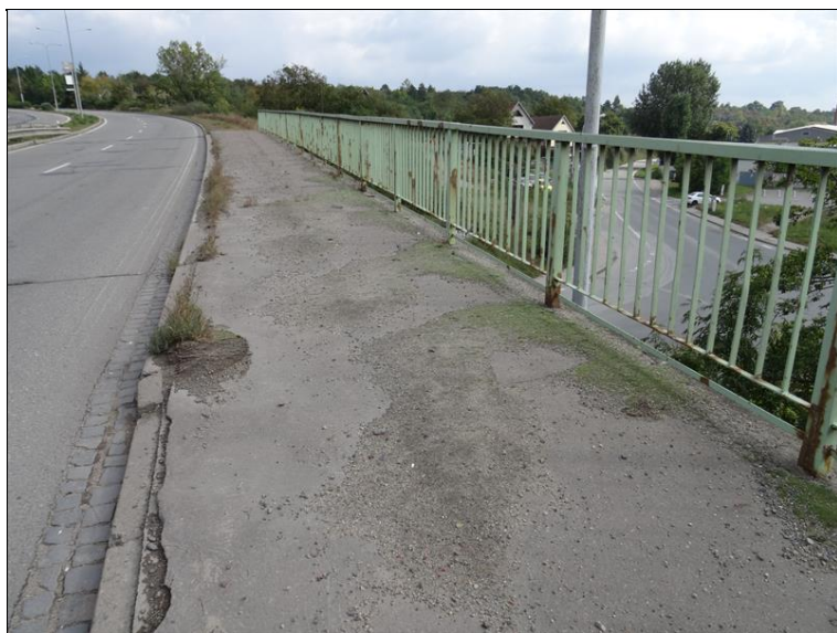
35.JPG Levý chodník z pohledu od konce mostu. Povrch chodníku mírně zvlněný, místy s trhlinami. Zakořeněná vegetace ve spáře podél zvýšených obrub. Povrch chodníku zanesený inertním materiálem a místy uchycenými řasami.
