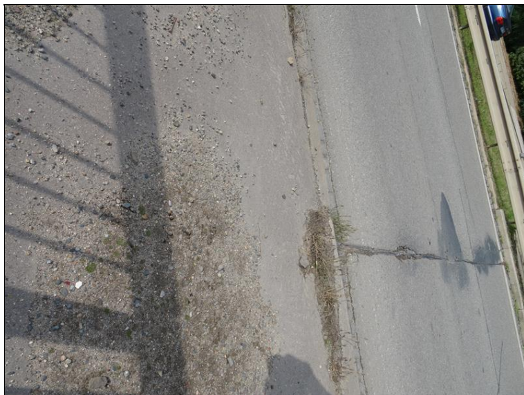
28.JPG Chodník a kryt vozovky v místě podpovrchové dilatace mostu nad Op2.
