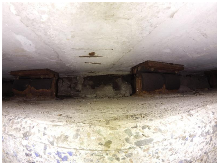
13.JPG Podhled dobetonávky spáry mezi 2. a 3. nosníkem zprava nad Op1. Koroze lokálně obnažené výztuže spáry, povrchová degradace úl. prahu, na závěrné zídce mezi ložisky vlhké mapy zátoků, koroze odvalových desek ložisek.
