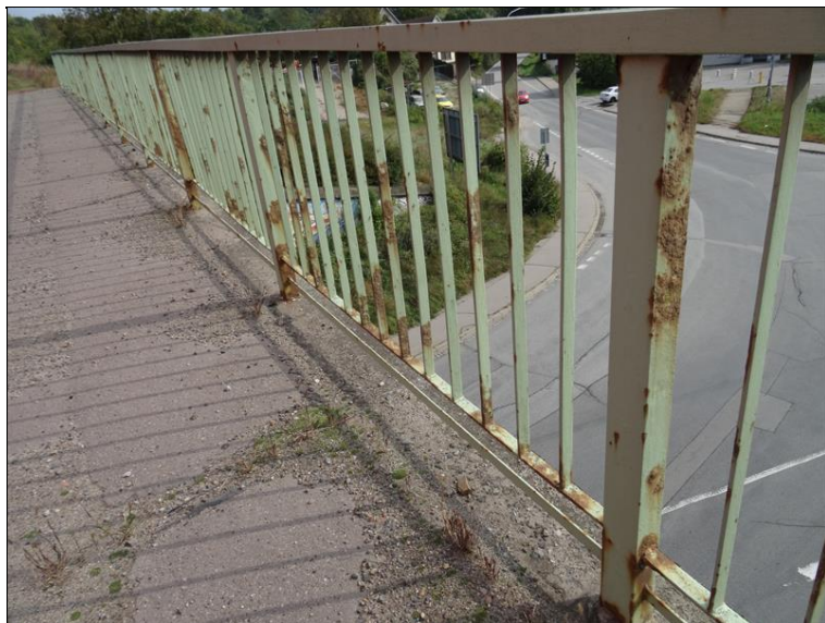
34.JPG Levá římsa s chodníkem. Lokální koroze zábradlí, povrch chodníku mírně zanesený inertním materiálem s uchycenými mechy.
