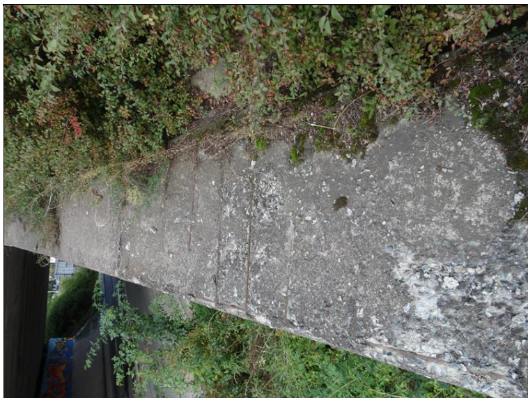
41.JPG Horní povrch římsy šikmého. Degradace betonu, obnažené těmínky.
