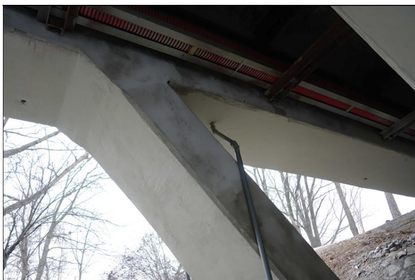
Pohled na vnitřní stranu plavé vzpěry P2 - sanovaný povrch je zde barevně nejednotný.
