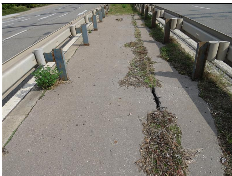
36.JPG Pravá vnitřní římsa a svodidlo (na snímku vpravo). Spára mezi římsami obou mostů zarostlá vegetací, lokálně otevřená, koroze sloupků svodidla.
