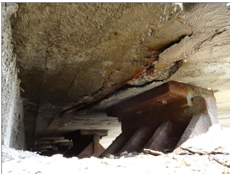
23.JPG Podhled konce krajního nosníku zleva. Odskok krycí vrstvy výztuže, Celá oblast vlhká a povrchově degradovaná od zátoku dilatační spárou. Koroze ložiska, na úlož. prahu beton. spad.
