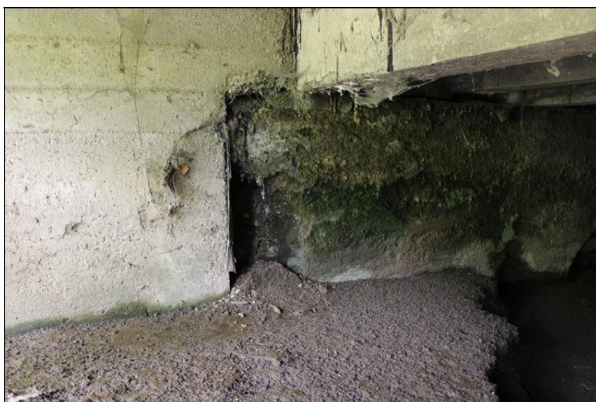
09-pohled na opěru 2 - rozhraní mezi konstrukcemi - kaverny.JPG
