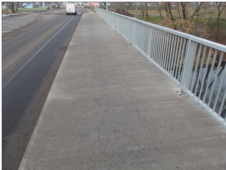
Povrch říms je potečený, jinak bez závad.
