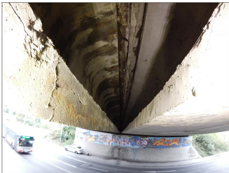
17.JPG Detail NK v pohledu směrem k Op2 - zatékání mezi mosty středovou spárou a pod římsou. Mokrý fasáda krajních (středových) nosníků.
