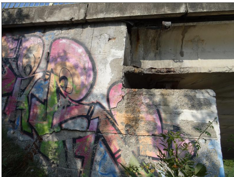
8.JPG Levý bok Op2. Degradace betonu.
