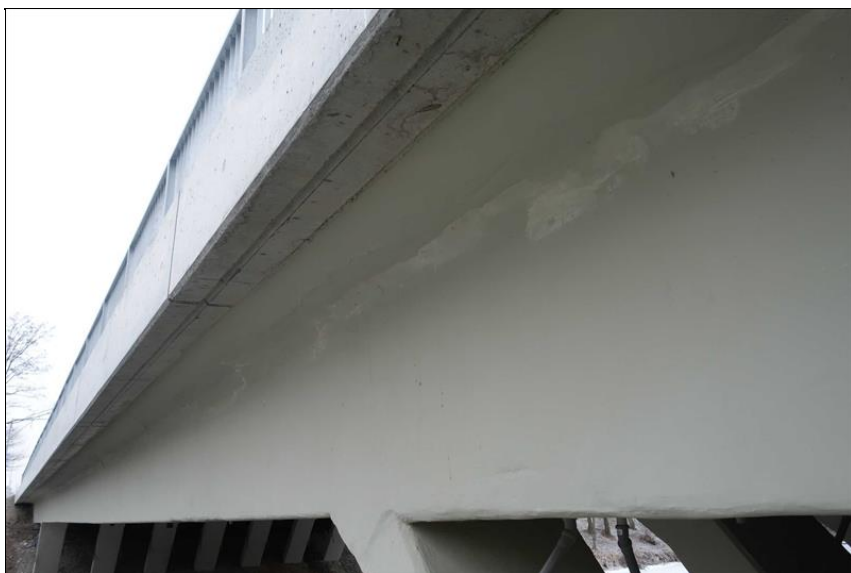
Pohled na sanovaný bok NK a podhled nové římsy.
