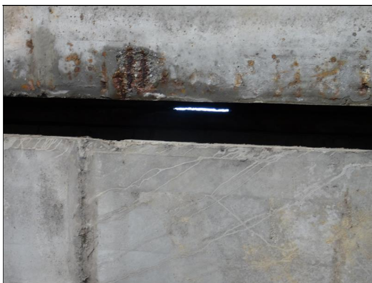
18.JPG Podhled středových nosníků. Průsak mezi mosty, lokální degradace betonu, korodující třmínky, patrná i porucha těsnění středové spáry v římsě mezi mosty.
