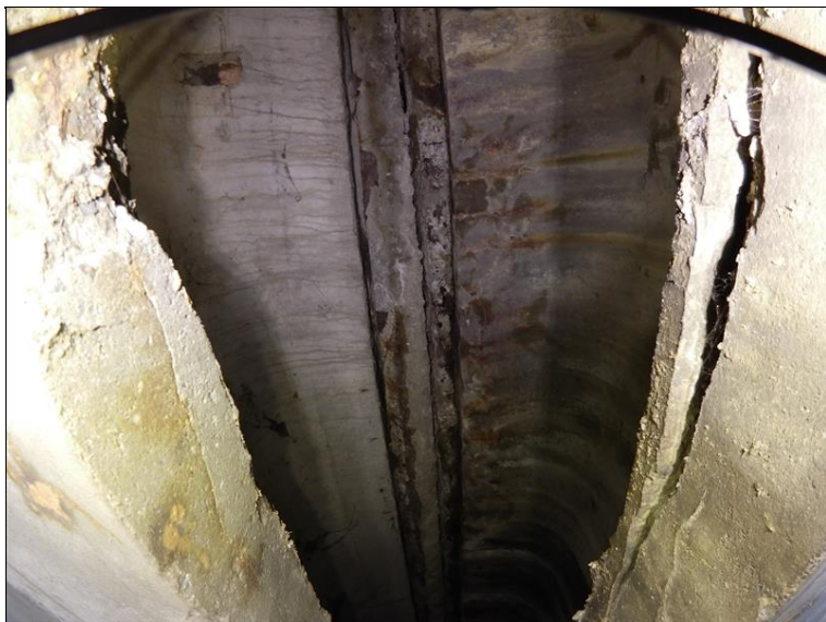
20.JPG Detail zatékání pod střední římsou mezi mosty II (před Op2 v pohledu k Op1). Trhlina při horním povrchu spodní příruby krajního nosníku.
