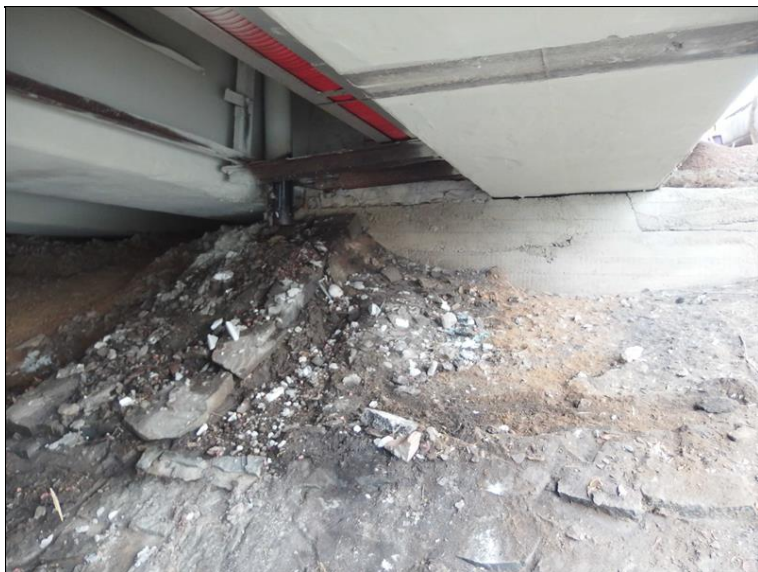
Zpevněné skluzy pod ústím svodů odvodňovačů v blízkosti OP1 a OP4 se rozpadají.
