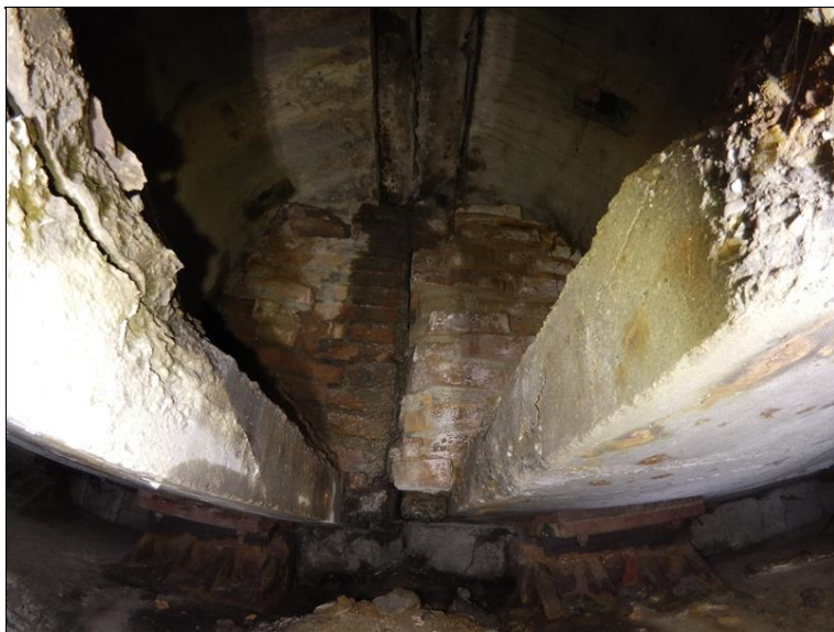
19.JPG Detail zatékání pod středovou římsou mezi mosty - degradace krajních (středových) nosníků obou mostů, koroze pevných ložisek na Op2.
