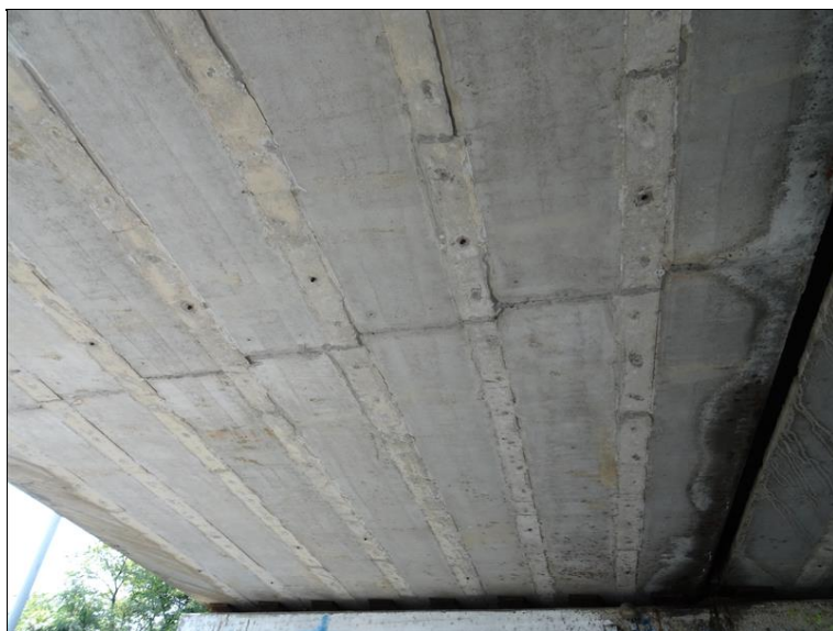
16.JPG Podhled NK ve směru Op2. Masivní zátoky shora podtékají do podhledu pravé krajního nosníku.
