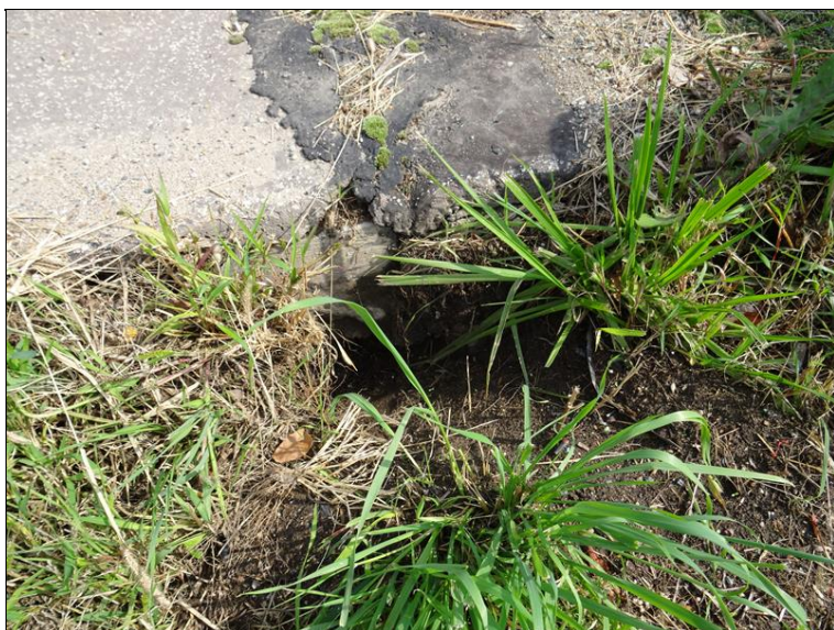
38.JPG Detail propadu ve zeleném pásu.
