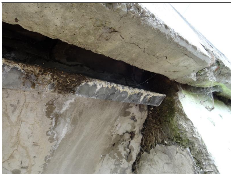
32.JPG Podhled levé římsy na začátku mostního pole. Spodní plocha líc. prefabrikátu s trhlinami. Zátoky na fasádu krajního nosníku podtékáním okapového plechu a dilatací mostu.
