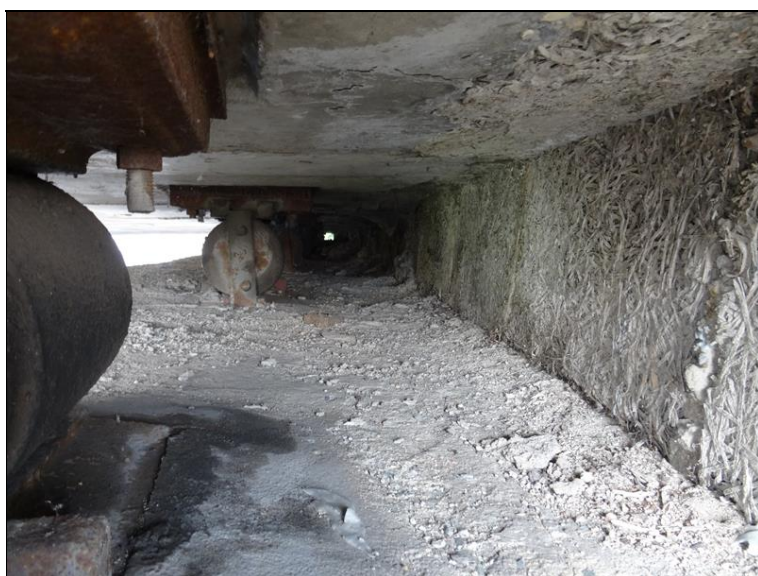
15.JPG Úložná spára mezi NK a Op2 za ložisky v pohledu zleva. Stopy zátoků na podhledu konce NK, závěrná zídka s ponechanou heraklid. deskou a stopami zátoků, úlož. práh zanesený nečistotami.
