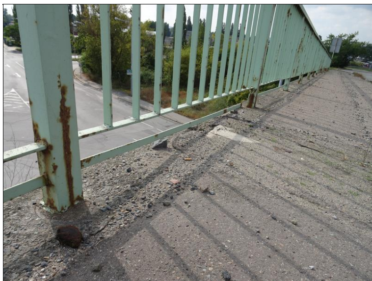
29.JPG Levý chodník v místě dilatace nad Op2. Mostní závěr zanesený nečistotami, lokální koroze zábradlí, uvolněná spodní vodorovná výplň zábradlí.
