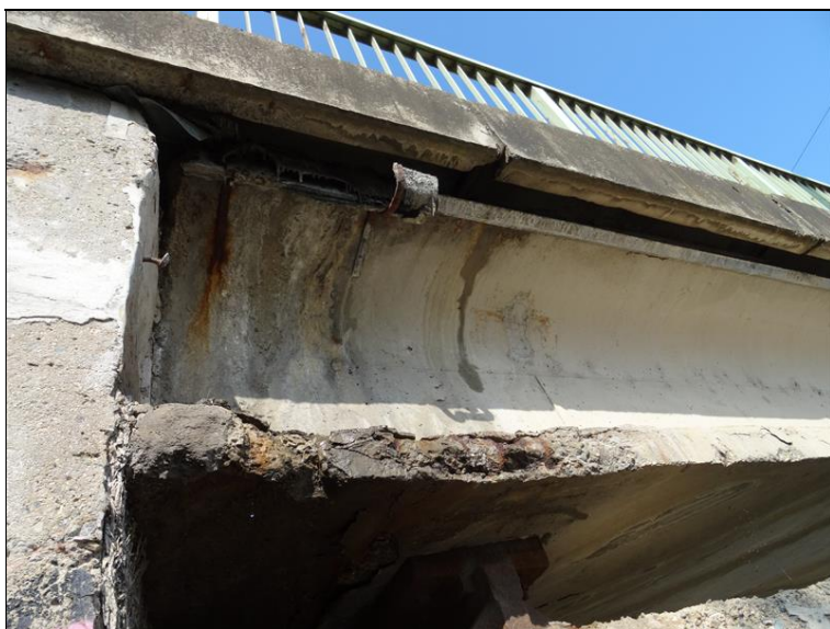
24.JPG Konec levého krajního nosníku nad Op2. Masivní zátoky, přes dilataci a pod římsou. Silná degradace betonu kraje spodní příruby, koroze obnažené výztuže, Pozůstatek odvod. rýny.
