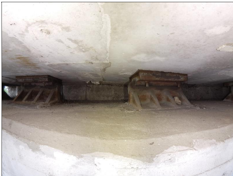
22.JPG Pohled na 2. a 3. ložisko na Op2 zleva. Povrchová koroze ložisek.
