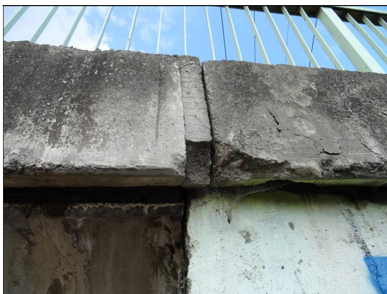
33.JPG Levá římsa v místě dilatace nad Op1. Lícni prefabrikát s uraženou okapovou hranou a lokálním odskokem krycí vrstvy výztuže. Dilatace levé římsy nad Op1. Vyplnění dil. spáry mezi lícními prefabrikáty nefunkční.
