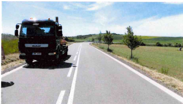
Začátek úseku (pohled vzad)
